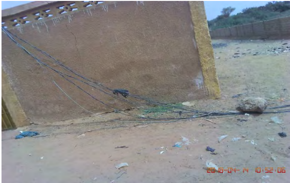
Photo 49 : Câbles provenant des compteurs éloignés dans le quartier Saga de Niamey Source : Abdourazack N. A., 2018
