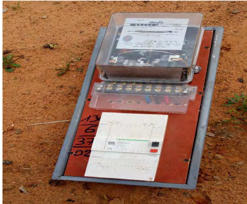
Photo 46 : Type de compteur utilisé par les ménages de Niamey Source : Abdourazack N. A., 2018
