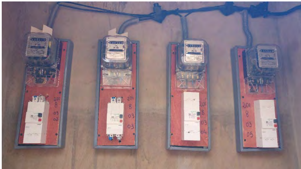
Photo 50: Regroupement de quelques compteurs éloignés Source : Abdourazack N. A., 2018
