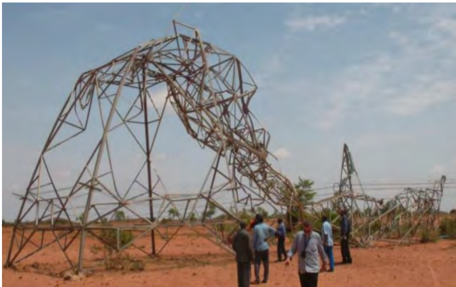
Photo 1: Pylône 612 Source : Mailele D. A., 2013
