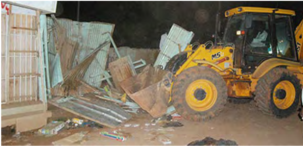
Photo 22: Caterpillar en train de démolir un kiosque à Niamey Source : Niger Express (publiée le 31 octobre 2016)
