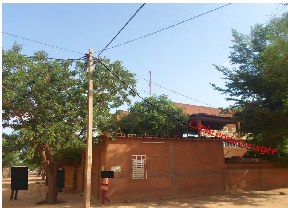
Photo 3 : Câble de branchement arraché par la chute d'une branche d'arbre dans le quartier Nord faisceau
