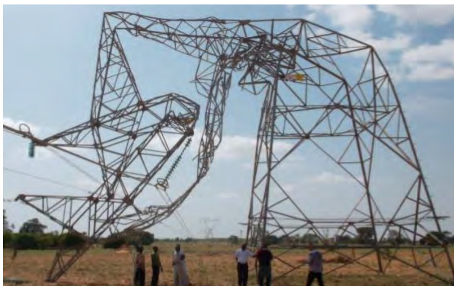
Photo 2 : pylône 620 Source : Mailele D. A., 2013
