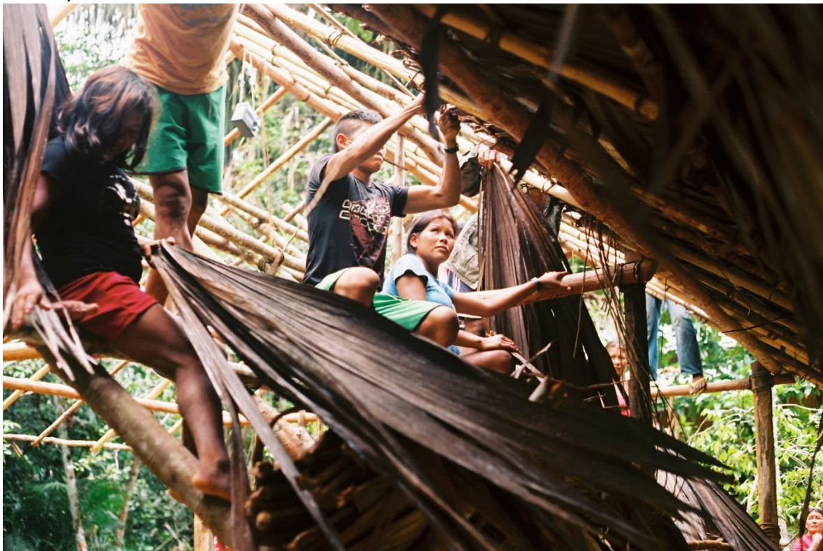
Photo 37 : les jeunes installent les feuilles de caraná pour recouvrir le toit. ©Emmanuel Richard.
