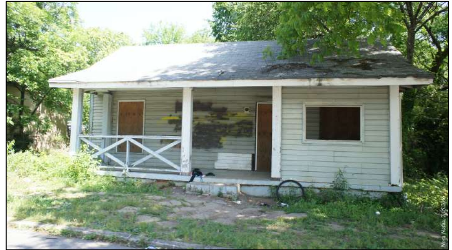
Photo 19. Maison vacante du quartier résidentiel de Thomasville Heights
