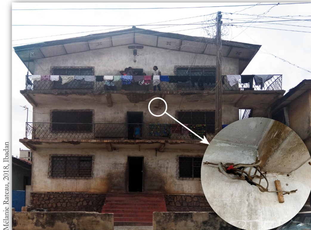
PHOTO 30 : DEUXIÈME ÉTAGE DÉCONNECTÉ DU RÉSEAU ÉLECTRIQUE
