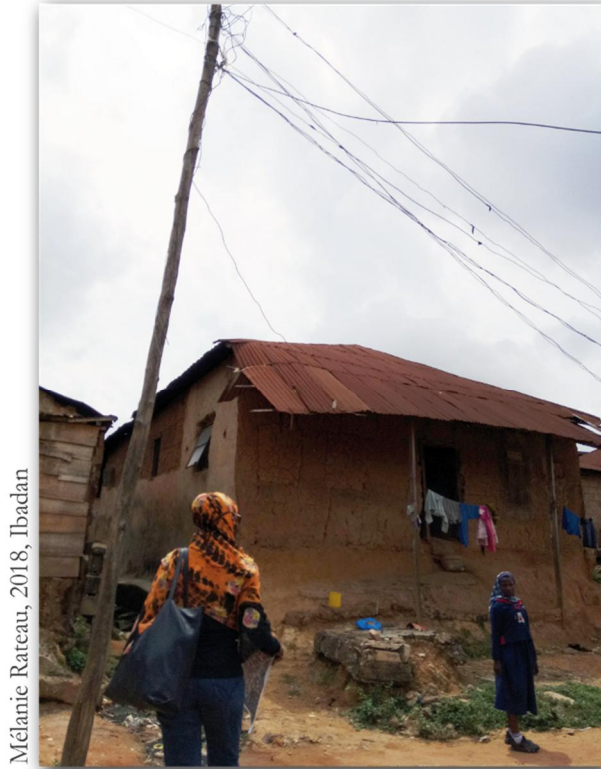
PHOTO 36 : POTEAU ÉLECTRIQUE COMMUNAUTAIRE DU RÉSEAU RAFISTOLÉ D'OJE
