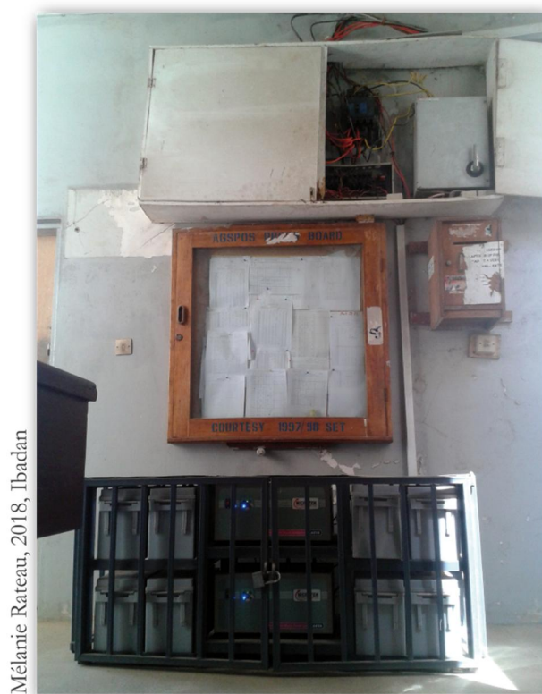
PHOTO 12 : SYSTÈME DE BATTERIES BACK-UP DANS LES COULOIRS DE L'UNIVERSITÉ D'IBADAN
