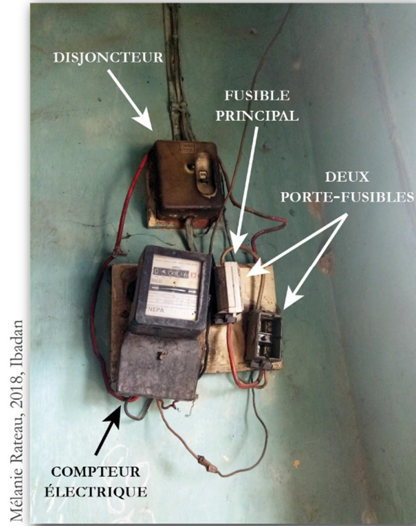
PHOTO 22 : INSTALLATION ÉLECTRIQUE POUR SWITCHER ENTRE DEUX PHASES
