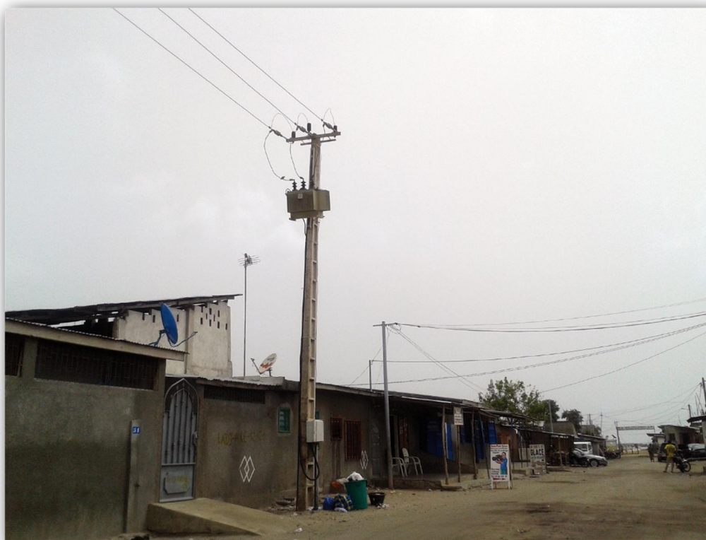
PHOTO 72 : EXTENSION DE LA LIGNE MOYENNE TENSION PAYÉE PAR UN ENTREPRENEUR INDIVIDUEL
