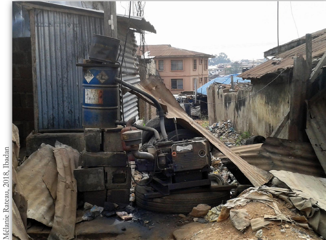
PHOTO 18 : GROUPE ÉLECTROGÈNE BRICOLÉ AVEC UN RÉSERVOIR EXTERNE ADDITIONNEL
