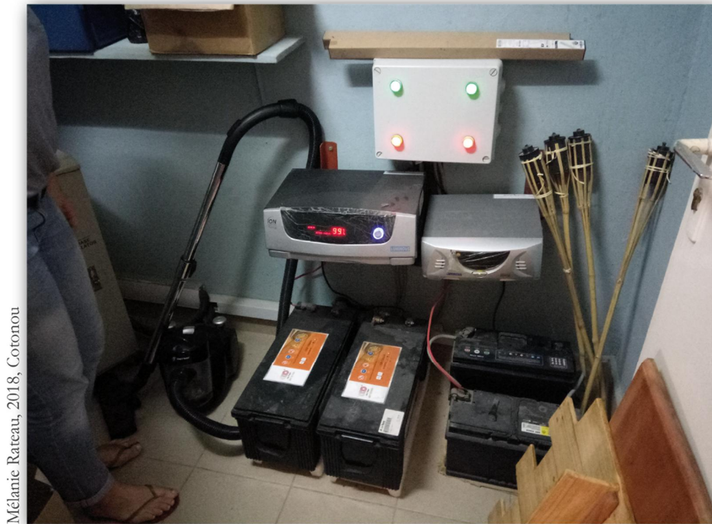
PHOTO 62 : SYSTÈME DE BATTERIES BACK-UP CHEZ UN MÉNAGE À COTONOU
