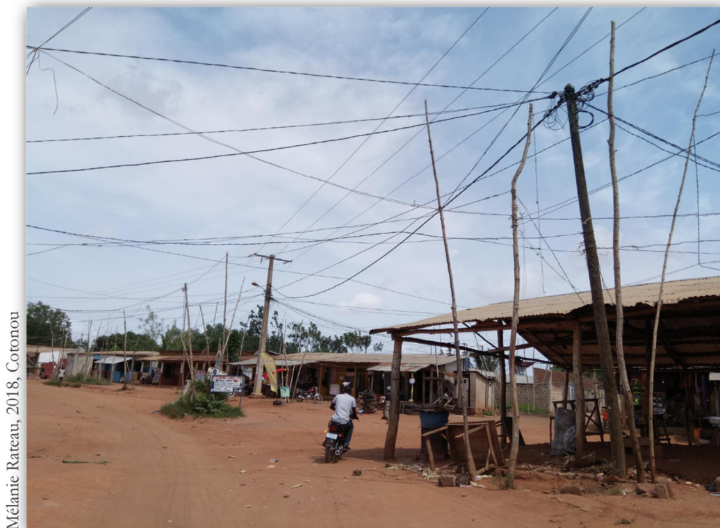
PHOTO 37 : RÉSEAU CONVENTIONNEL ET TOILES D'ARAIGNÉE DANS LE PÉRIURBAIN
