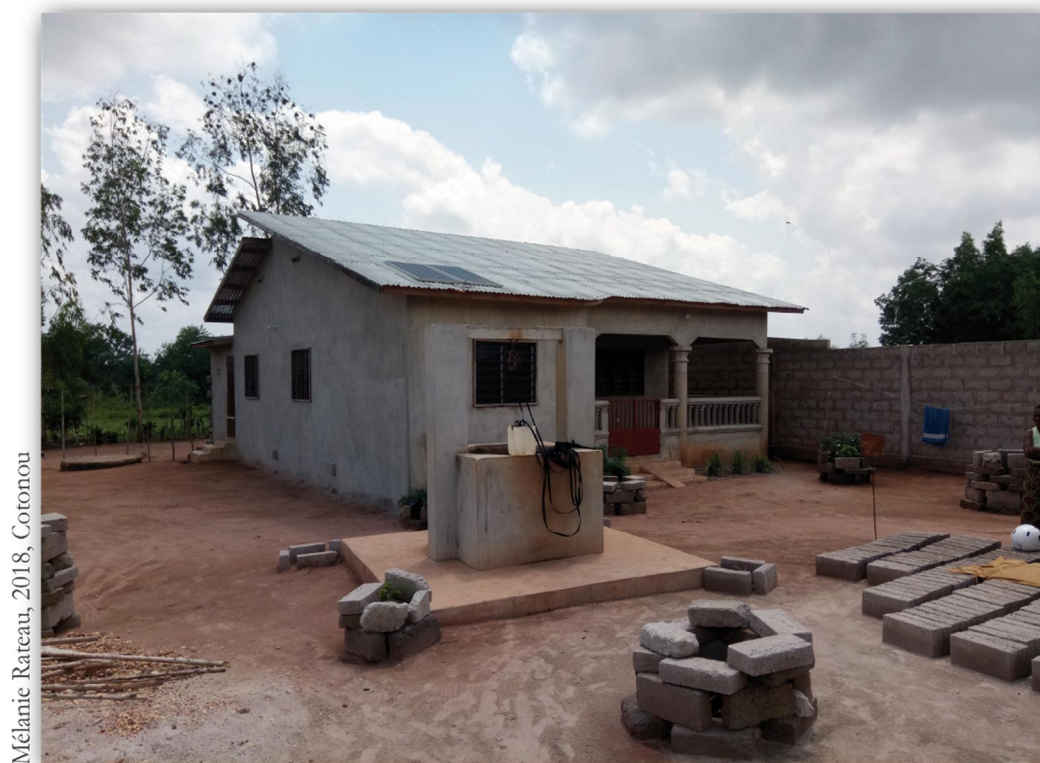
PHOTO 43 : PANNEAUX PHOTOVOLTAÏQUES INSTALLÉS SUR UNE MAISON PÉRIURBAINE
