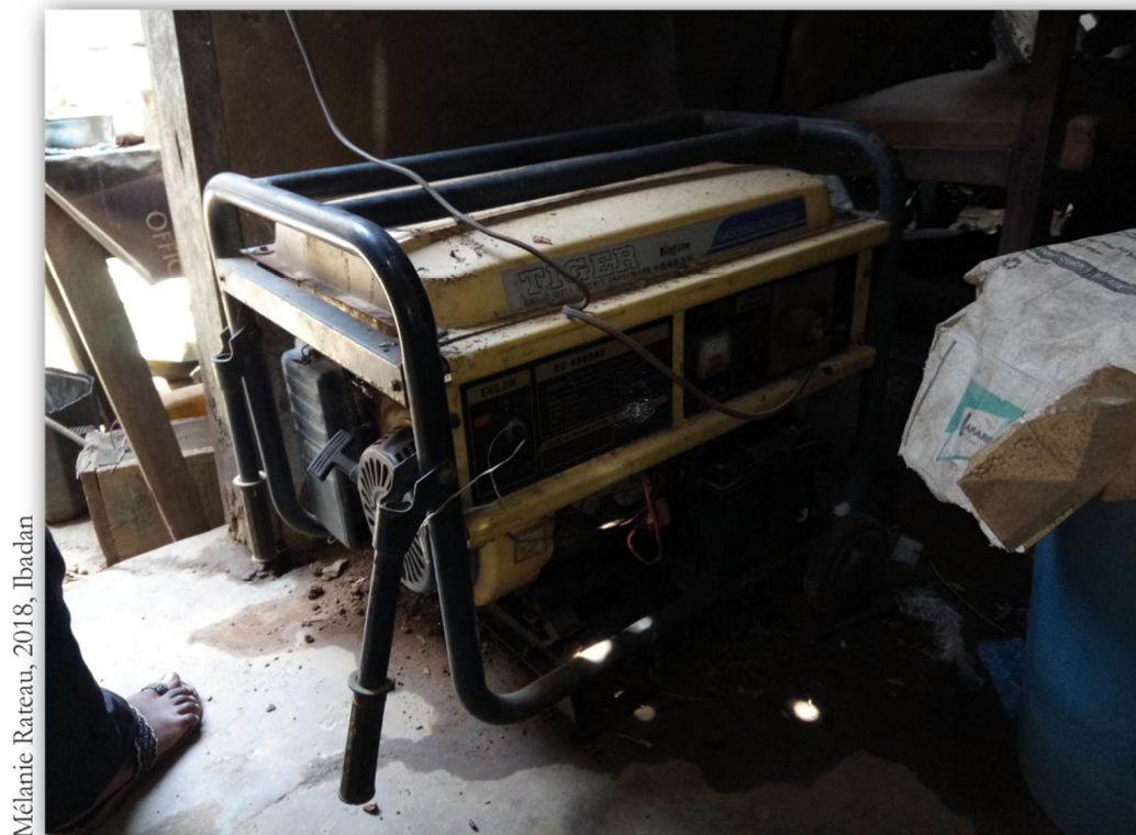
PHOTO 19 : GROUPE ÉLECTROGÈNE INSTALLÉ EN INTÉRIEUR À PROXIMITÉ DES PIÈCES D'HABITATION
