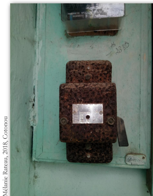
PHOTO 70 : DISJONCTEUR HORS D'ÂGE MAIS TOUJOURS EN FONCTIONNEMENT
