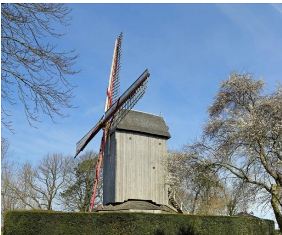
Figure 12. Le moulin de Cassel (Nord) de type « pivot » (Photo par PAT 2013, www.moulins-a-vent.net )
