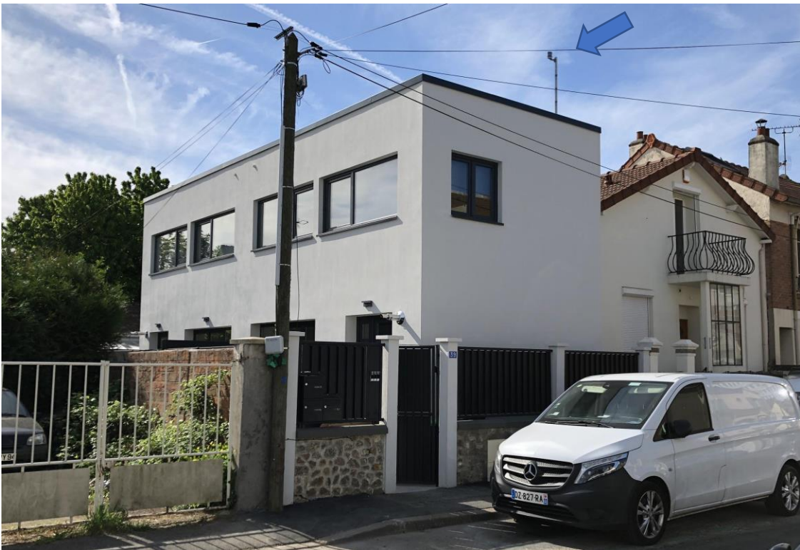
Figure 98. Vue du nouvel anémomètre à une hauteur de 8 mètres au-dessus du sol de la maison Roméra à Arcueil
