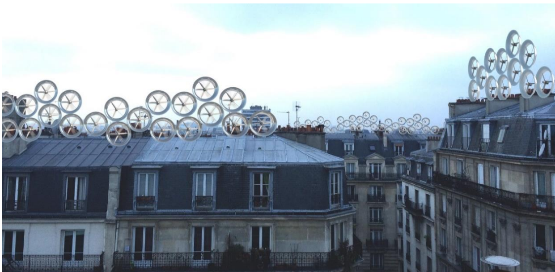
Figure 253. Visualisation de clusters en drapeau (flag) sur un bâtiment parisien. (Horizontaux et verticaux) Ce dispositif permet de capturer les vents induits par l'effet couloir des rues de tissu dense et homogène, mais est trop « étrangère » à l'architecture présente.
