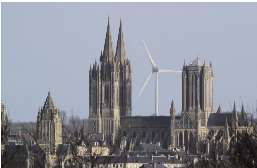
Figure 33. A Coutances en Normandie, une éolienne est située dans l'axe de la cathédrale de la ville et dénature le panorama urbain de la ville 44
