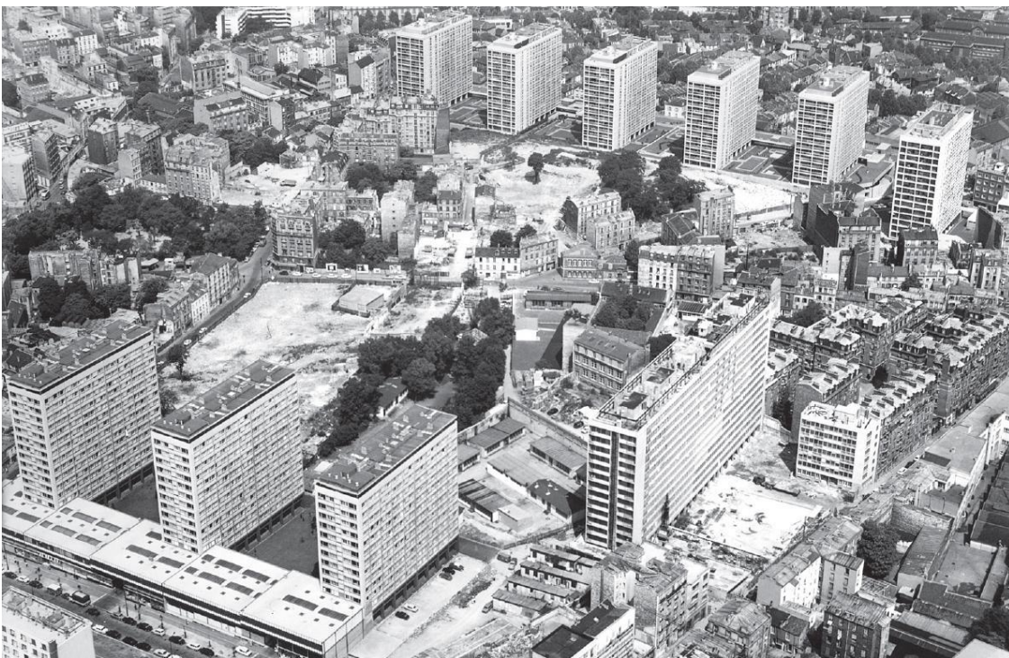
Figure 58. Place des Fêtes (XIX e arrondissement) : grand ensemble en cours de construction, effacement de la trame urbaine existante, 1971. ( https://www.apur.org/fr )
