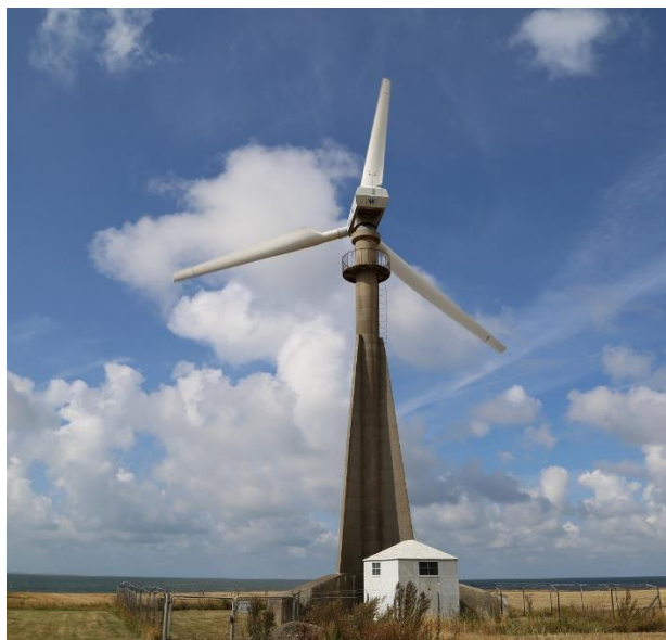
Figure 20. Turbine de Gedser au Danemark, sur un mat en béton armé l'origine des éoliennes actuelles ( source : https://fr.wind-turbine-models.com/ )
