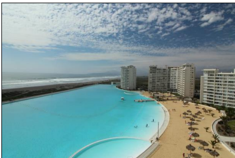
Photographie 7. La lagune artificielle du complexe immobilier Laguna del mar. Source : site internet de promotion du complexe immobilier.
