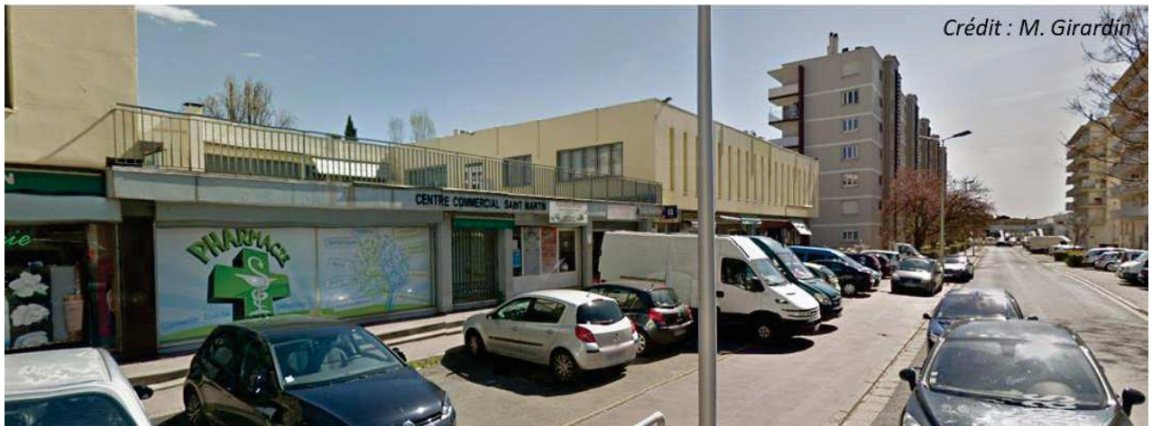
Figure 42 : Centre commercial Saint-Martin en juin 2019
