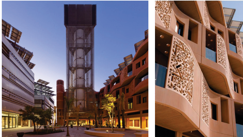
Figure 83 - Masdar City : réinterprétations d'une esthétique traditionnelle. À gauche la tour à vent (crédits : Foster+Partners) ; à droite les façades en béton reprenant des motifs de moucharabiehs (crédits : Duncan Chard).
