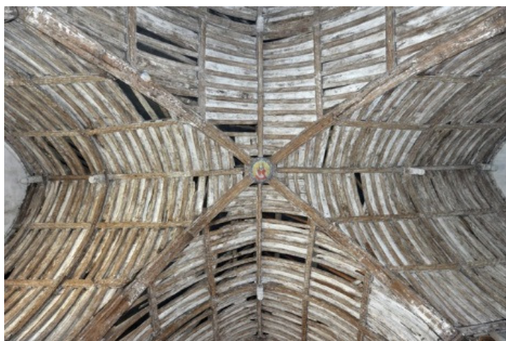
Fig. 70 : Voûte à caisson du transept de l'église de Mesnil-sous-Vienne (Eure), XVIe s., après dégagement de son enduit au plâtre du XIXe s.
