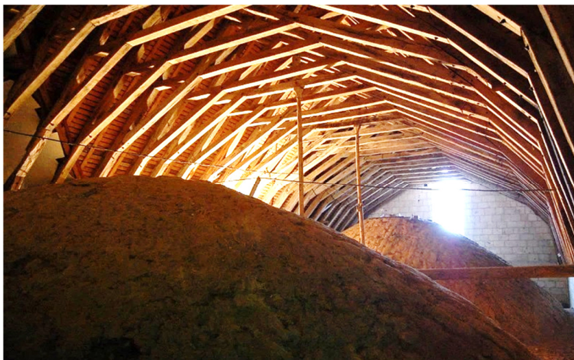
Fig. 79 : Charpente du bras sud de la cathédrale de Poitiers, avec les voûtes domeales typique du gothique angevin, 1222.
