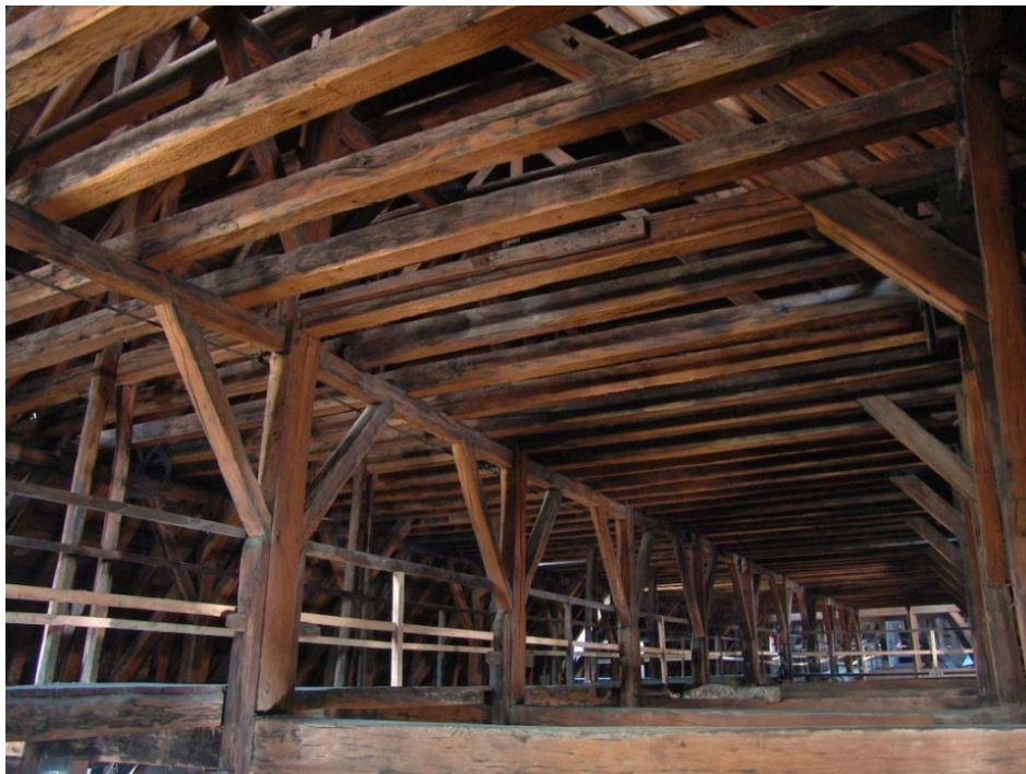
Fig. 84 : Charpente disparue de la nef, cathédrale Notre-Dame de Paris, vers 1215.
