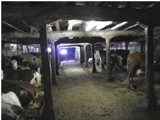
Fig. 44 : Double file de poteaux porteurs pour un plancher de grenier. Maison-étable avec stabulation au rez-de-chaussée et grange à l'étage. Crandelles, Cantal.
