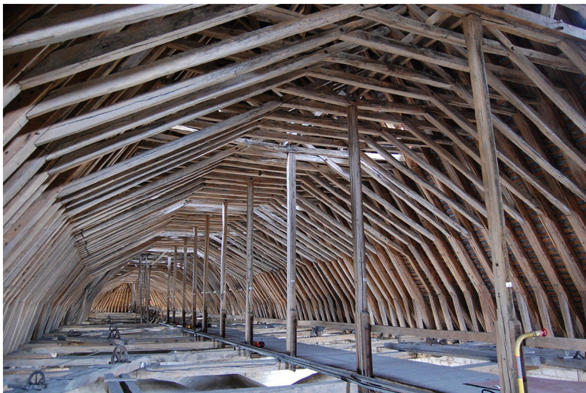
Fig. 82 : Charpente de la cathédrale de Bourges, 1258.
