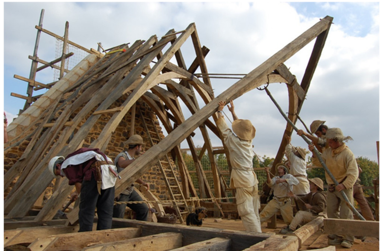
Fig. 60 : Levage manuel d'une ferme de la charpente du logis de Guédelon, 2008.
