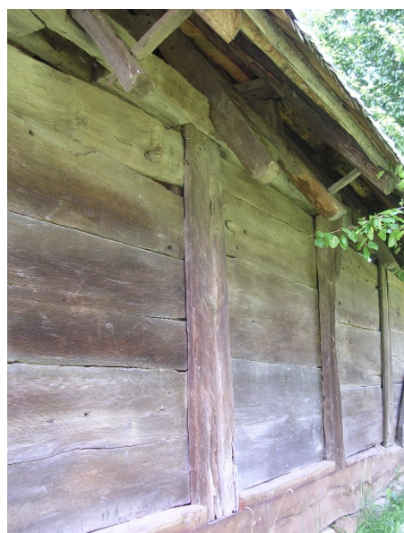
Fig. 51 : Pan de bois à poteaux rainurés et planches bouvetées. Maramures, Roumanie, 2005.
