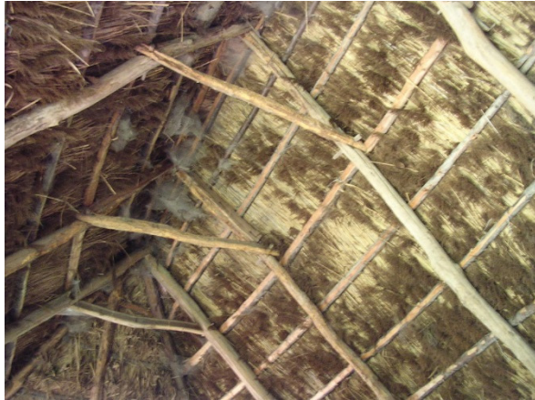
Fig. 25 : Charpente à chevrons-formant-fermes d'une grange du XXe s., avec une indépendance des fermes, des assemblages à mi-bois et des bois à peine équarris, Baia Mare, Roumanie.
