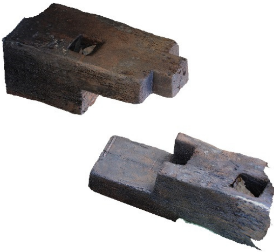
Fig. 24 : Enture droite à tenon-mortaise des sablières basses du caisson 9, avec leurs mortaises de section carrée pour les poteaux.
