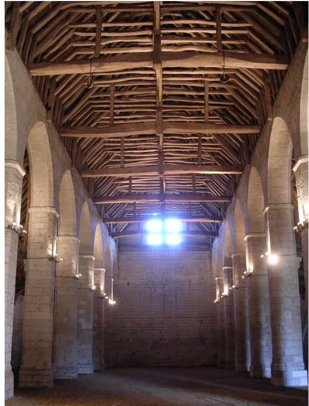
Fig. 72 : Grange Saint-Lazare de Beauvais, 1225.
