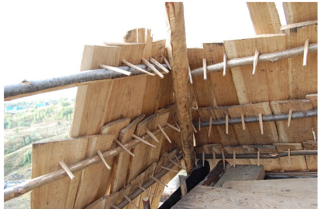
4. Fixation des bardeaux par chevillage
