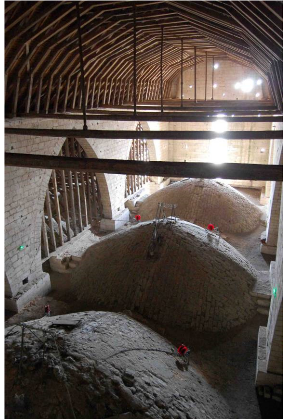
Fig. 78 : Charpente du chœur de la cathédrale de Poitiers, 1222.
