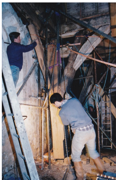
Fig. 4 : Remplacement d'un poteau, 1998
