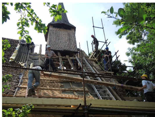
Fig. 5 : Restauration d'une panne, 2014
