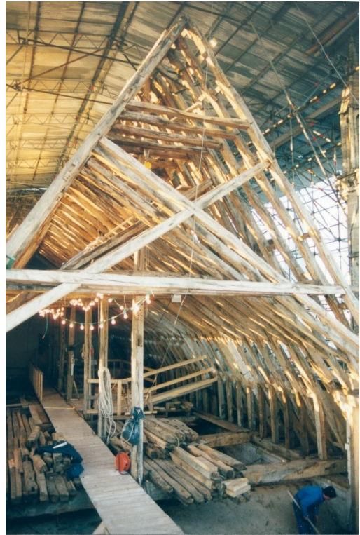
Fig. 76 : Charpente du chœur de la cathédrale de Bayeux, 1225.
