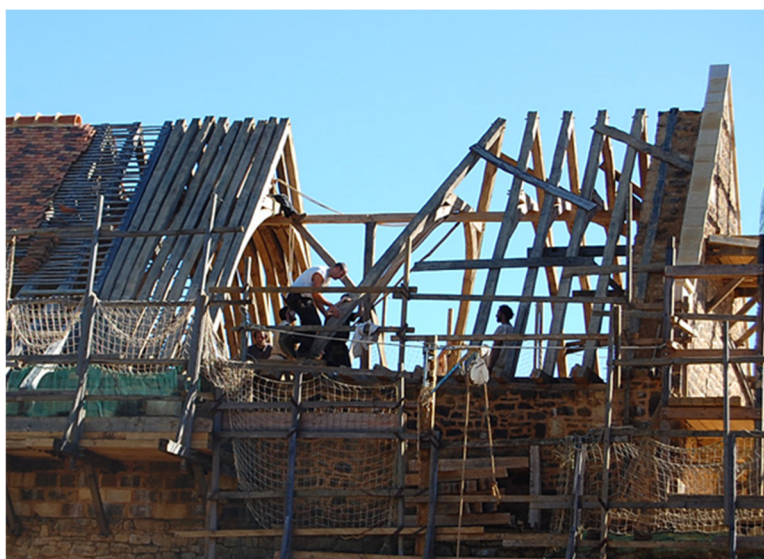
Fig. 61 : Déplacement des fermes sur la glissière dans la dernière travée du logis de Guédelon, 2008.
