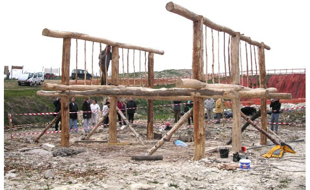
2. Assemblage des trois sommiers du plancher
