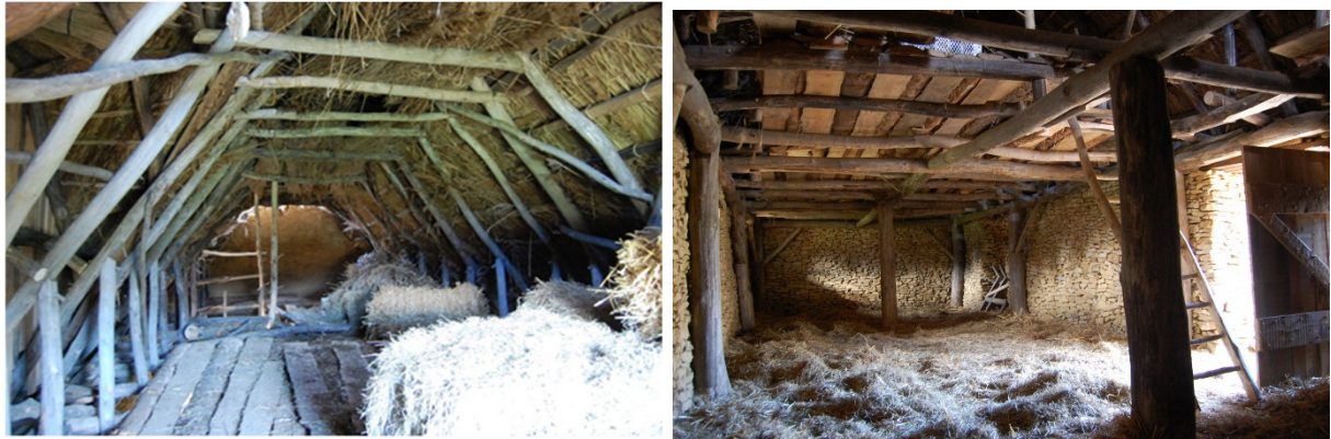
Fig. 16 : Construction expérimentale utilisant le principe d'une charpente à chevrons-formant-fermes et des poteaux axiaux de soutien d'un plafond sur les entrails des fermes. Archéosite d'Ornavik (Cavados).
