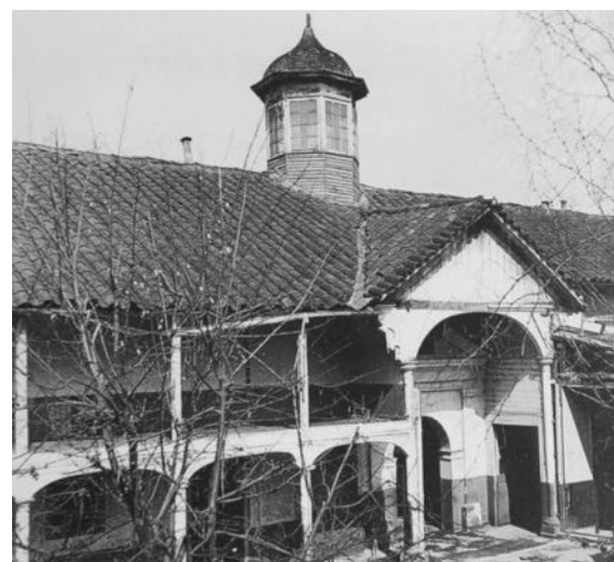
Figure 90: Pórtico de ingreso al Crucero de Avilés, Hospital de San Juan. Anonyme, 1943. Archivo Central Andres Bello, Universidad de Chile, Santiago.
