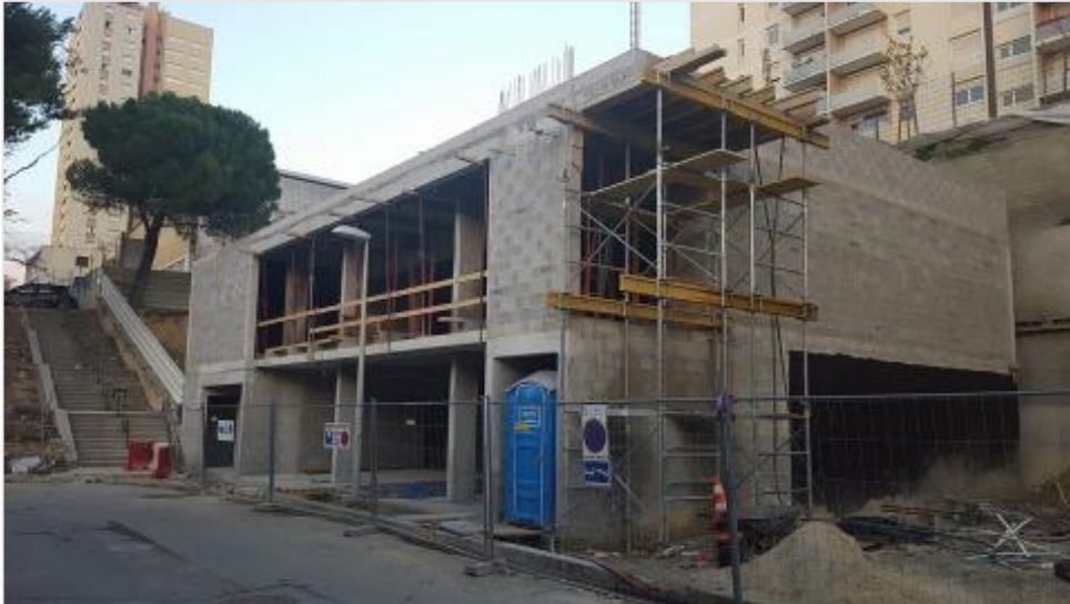
Photographie 16 : Chantier de la mosquée (2016)
