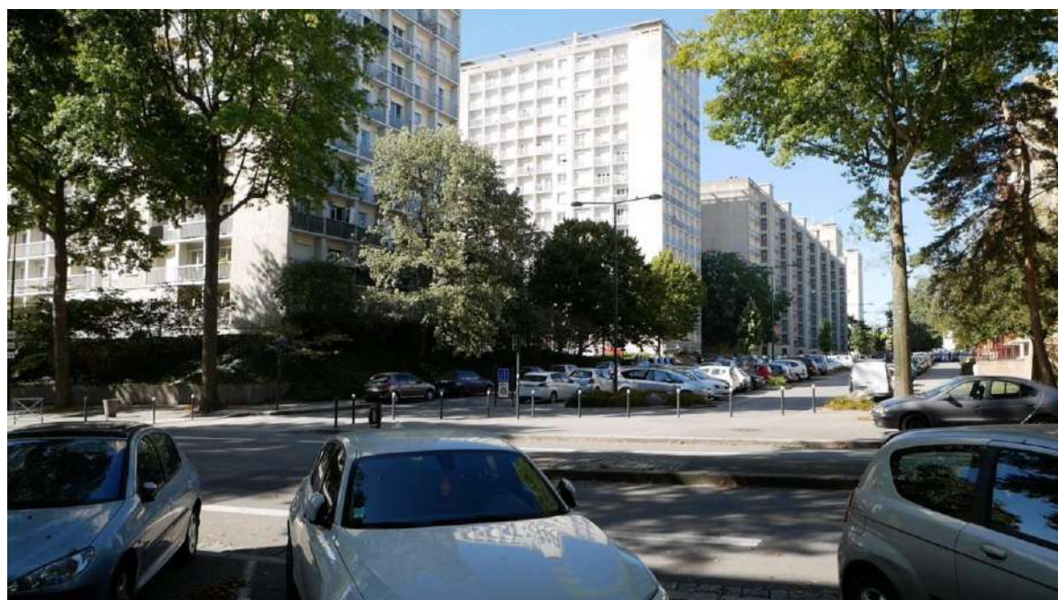
Figure 19. Capture d'écran du film montrant la dalle Kennedy « presque enclavée » derrière les immeubles.
