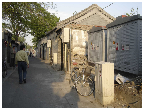
Illustration 22 : L'installation du chauffage électrique dans les hutong (J. Audin, X, juin 2009)
