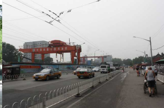
Illustration 13 : Chantier du métro à la Tour du Tambour (Dépit/Proust, X1, août 2012)
