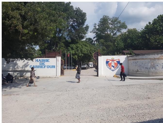
Entrée de la mairie de la commune de Carrefour
