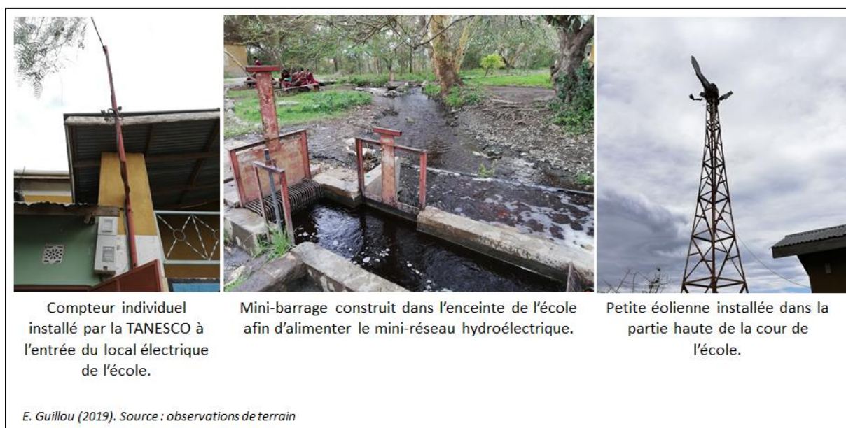
Figure 36 : Quelques sources d'énergie alimentant l'école de Ngare Nanyuki en électricité
