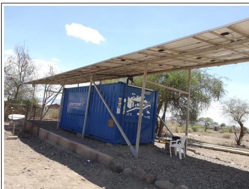
Figure 28 : Une mini-centrale conteneurisée en Tanzanie
