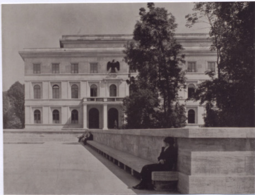
106 Détail du parapet de délimitation de la place, aménagement des bancs le long du parapet, 1937.
