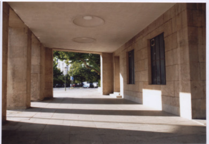
412 Passage traversant : Mehring Damm/Platz der Luftbrücke, 2010.
