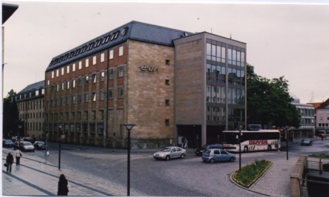
297 Etat du bâtiment, 2005.
