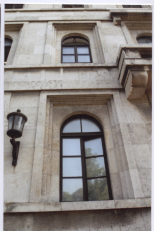
426 Bâtiment du Führer, Munich, les feuillures autour d'une baie, 2008.
