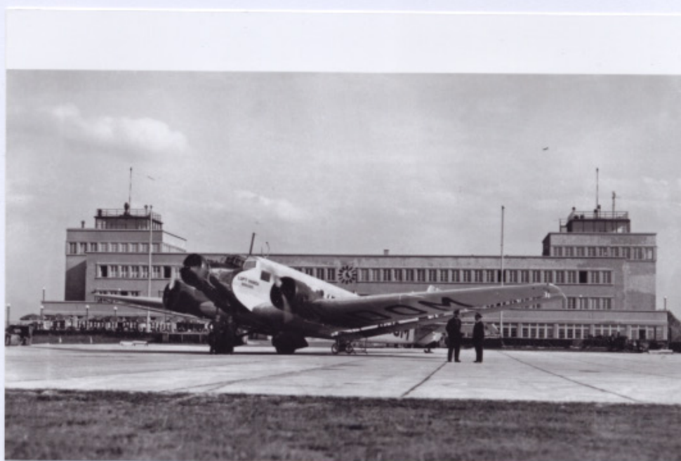
200 Munich-Oberwiesenfeld, terminal côté pistes.
