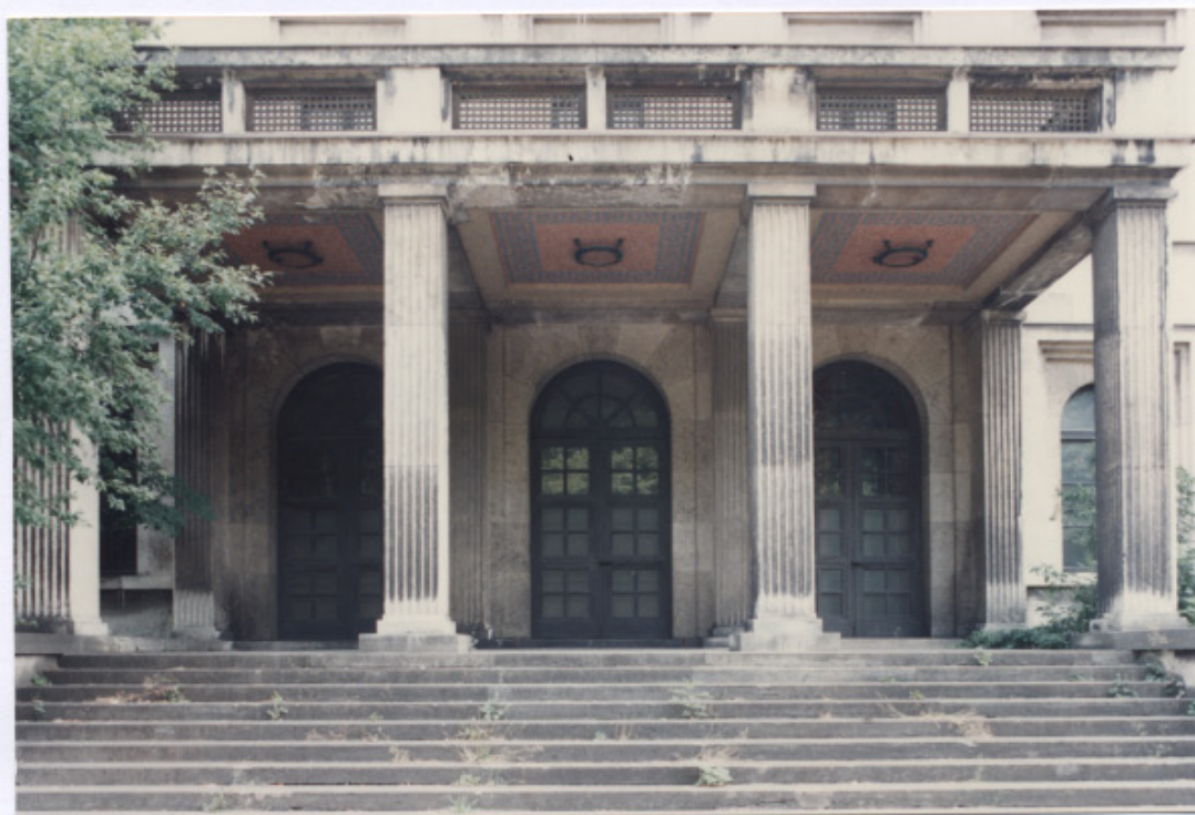
108 Oubliées par la dénazification sont toujours présentes les swastikas des mosaïques du plafond des porches d'accès.
