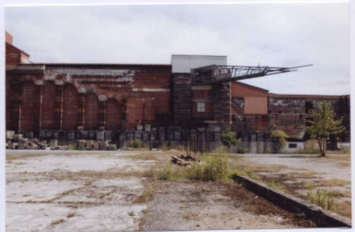
356 La "flèche", quand la structure de métal s'achève et domine la vaste cour du hall des Congrès, 2012.
