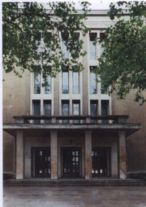
400 Porche d'accès, place Ronde, Tempelhof, état en 2005.
