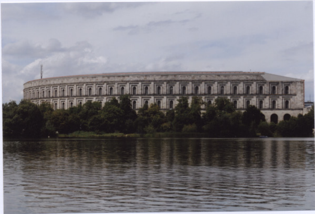
352 La façade sud-est du hall des Congrès en bordure de Dutzenteich, 2012.
