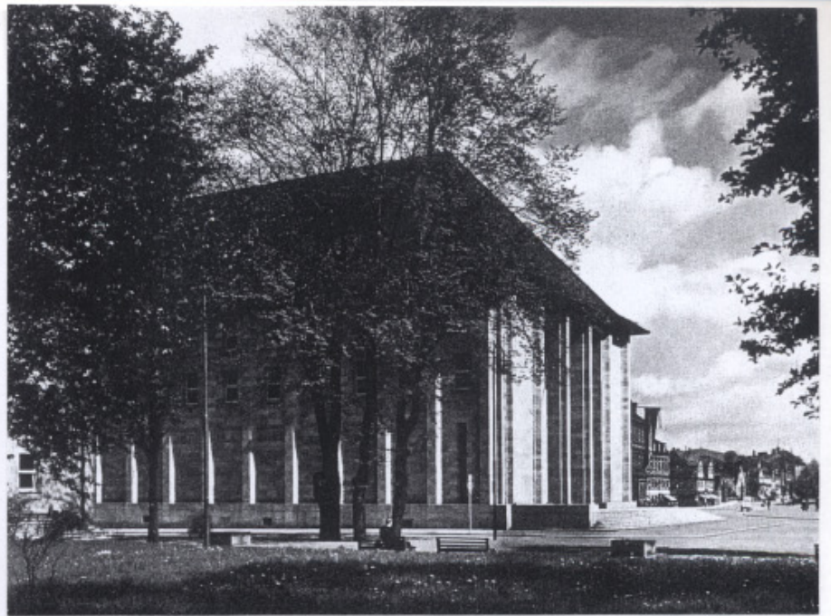
280 Maison de l'Education allemande. Le faitage est à 24,60 m du sol.
