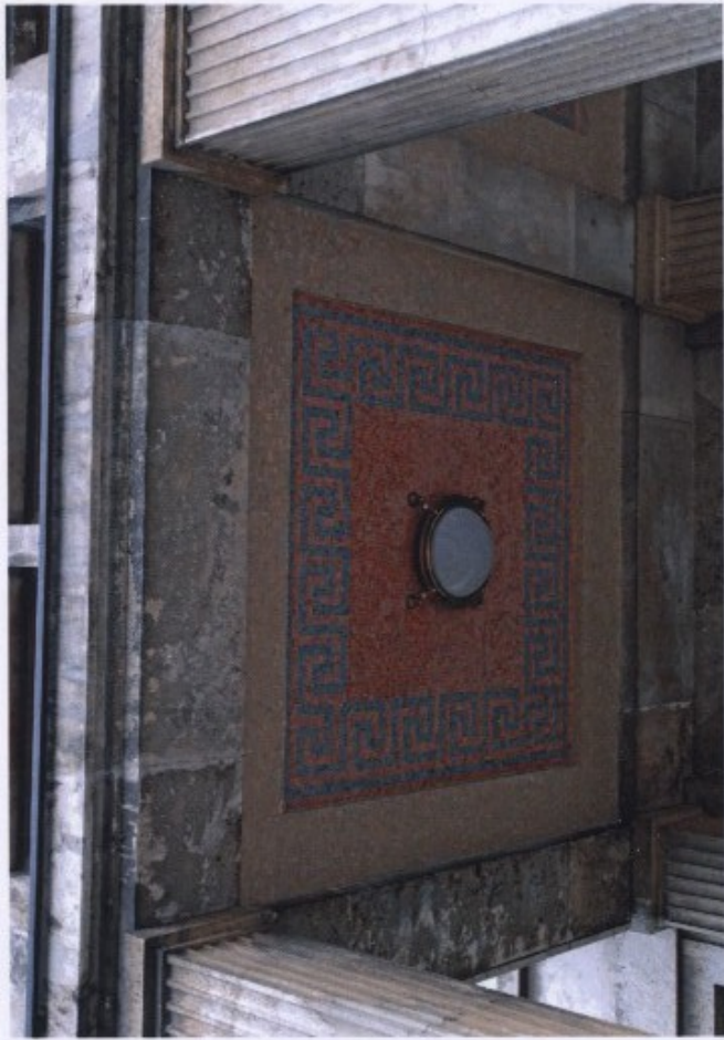
377 Plafond des portiques d'accès, bâtiment du Führer et bâtiment administratif, Arcisstrasse, Munich, 2005-05.
