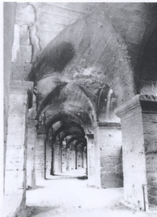
327 File annulaire de voûtes d'arêtes dans les déambuloire du Colisée, Rome.
