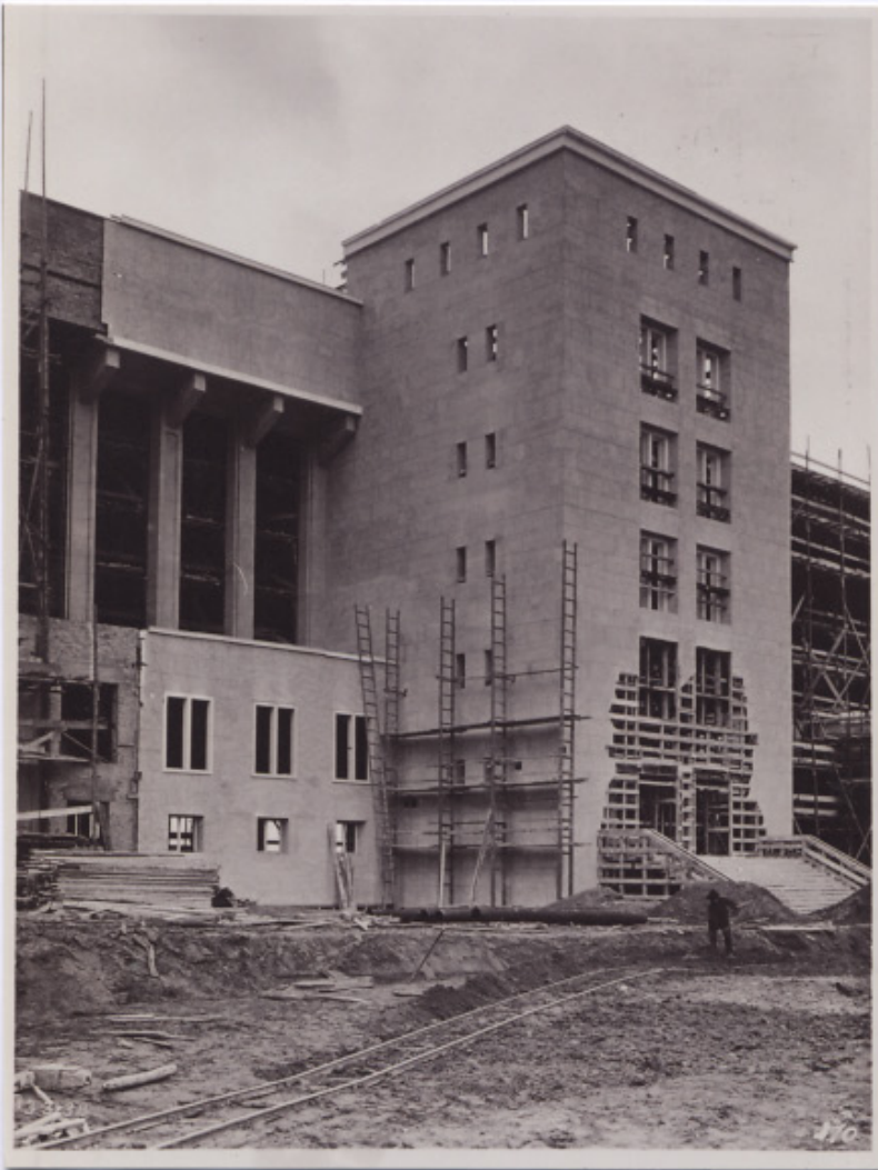
418 Aéroport de Tempelhof, mise en oeuvre pour le tester du revêtement de la façade arrière du bâtiment courbe et d'une tour, 1939.
