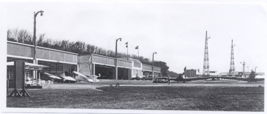
215 Les hangars de P. Mahberg et H. Kosina, 1924.
