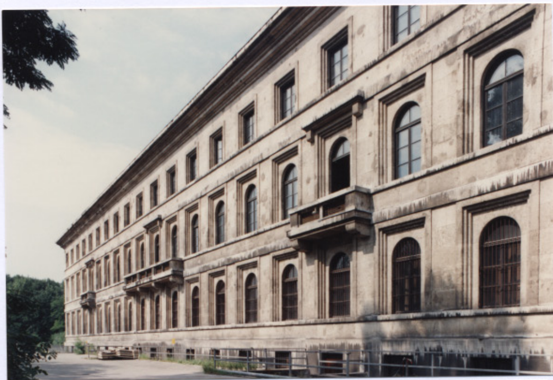
80 Façade arrière. Au centre le grand balcon s'étend sur une largeur correspondant à trois travées, 1995.
