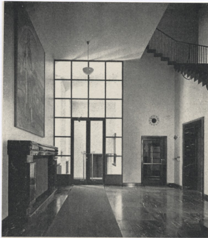
294 Entrée des bureaux avec l'escalier principal, à gauche au mur : le tableau de Oskar Martin.
