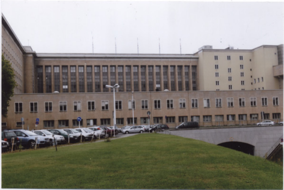
247 Vue de cette même façade au de-là des cours destinées aux livraisons et au fret.
