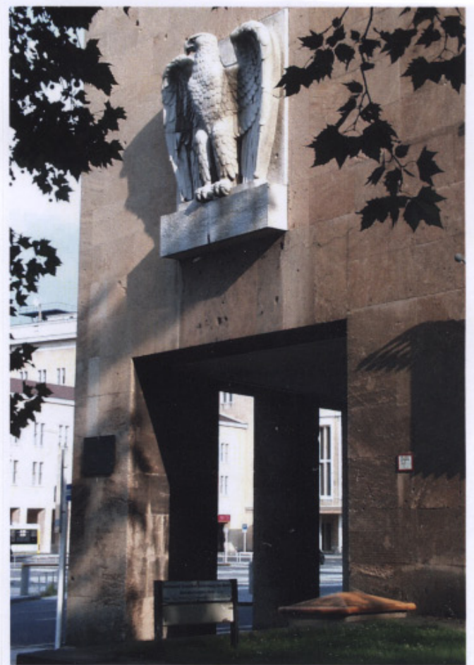
383 Aigle de Walther E. Lemcke, angle d'un des bâtiments de la place Ronde, Tempelhof, 2006.
