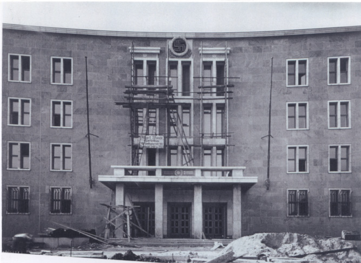
259 Essai de monumentalisation d'un porche en cours de chantier.
