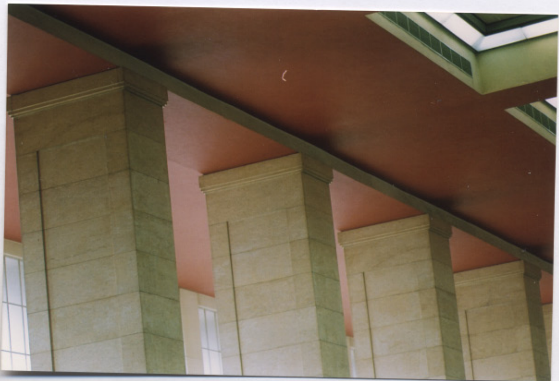
248 Détail des chapiteaux des piliers portant la grande poutre, hall d'enregistrement. 2005.
