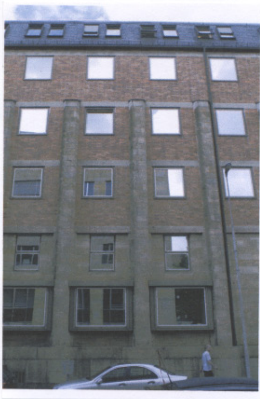
299 Percement des baies, revêtement en brique des murs.
