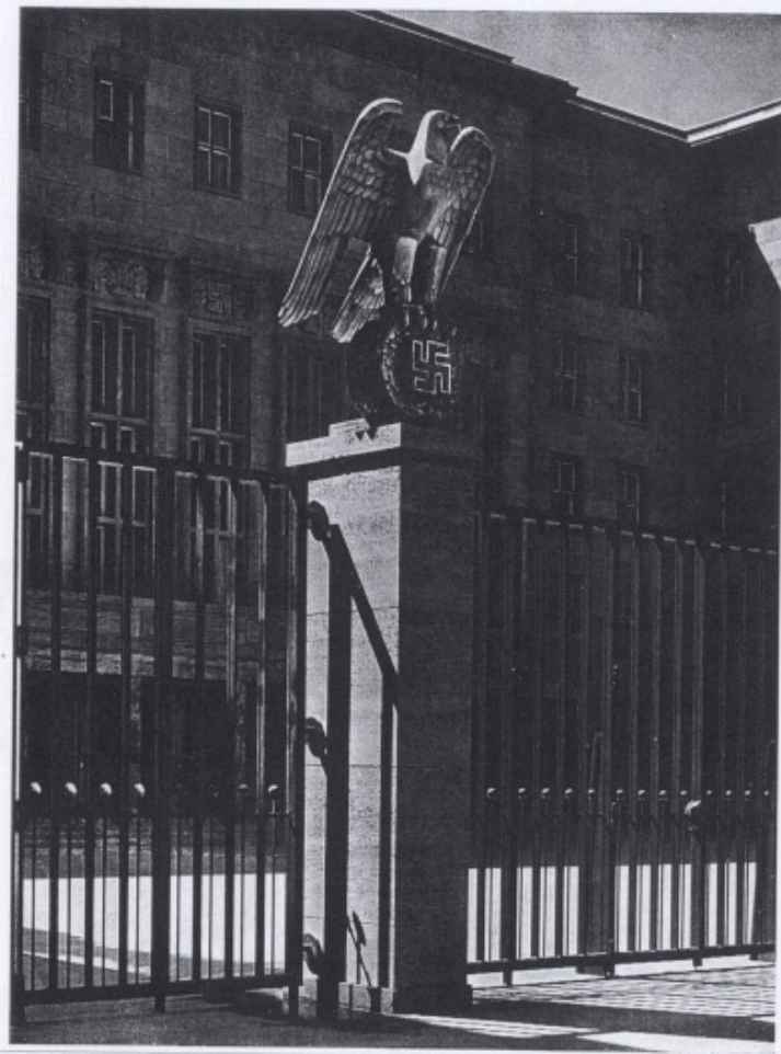
170 Au premier plan l'un des deux aigles de W.E.Lemcke, placés sur grille de la cour d'honneur. A l'arrière on distingue au-dessus des baies de la façade, les décorations de croix gammée et de croix de fer.
