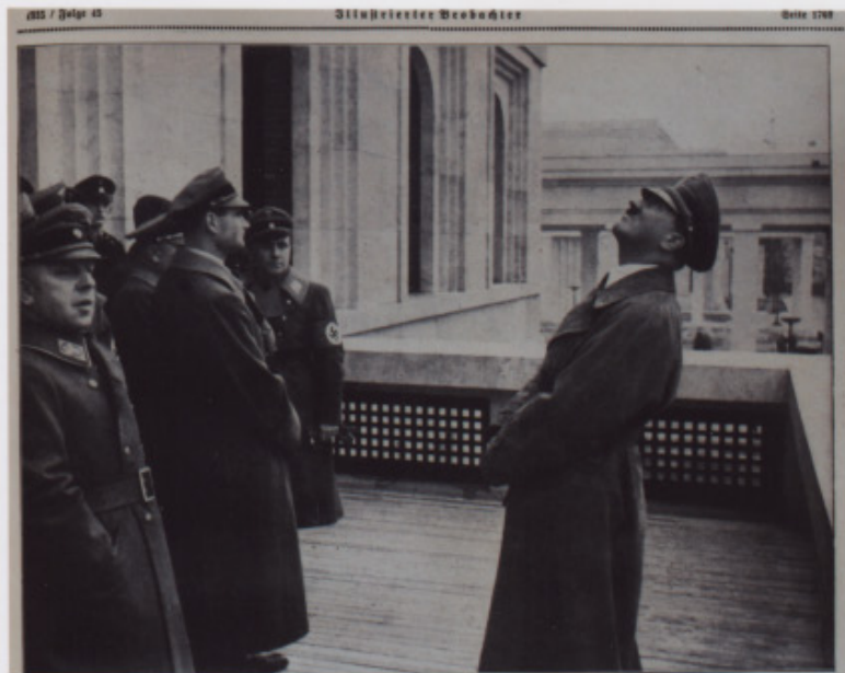
37 Visite de fin de chantier : Hitler sur le "balcon du Führer" au 1er étage du bâtiment du Führer, Munich.
