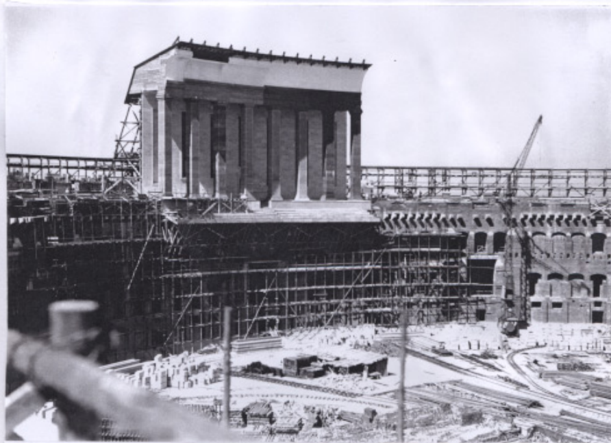
349 Maquette grandeur nature, à l'intérieur du bâtiment avec les éléments décoratifs des pilastres placés en partie haute de la salle des congrès.
