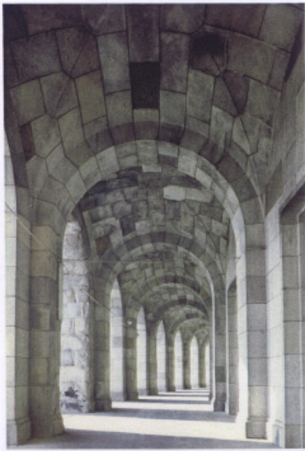
326 Hall des Congrès, galerie du rez-de-chaussée, la voûte d'arête n'a aucun rôle porteur, 1996.
