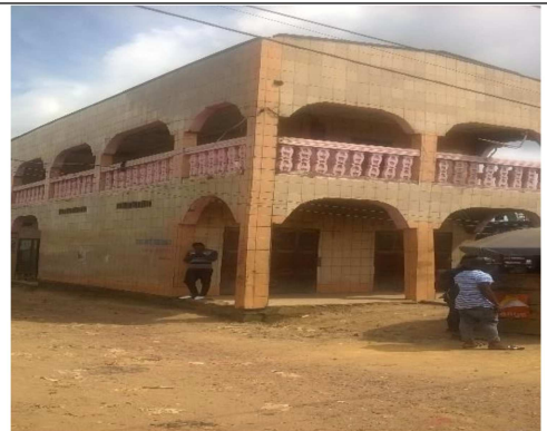
5.5 : 1 ère maison à étage de Kyé-Ossi, construite en 2004.
