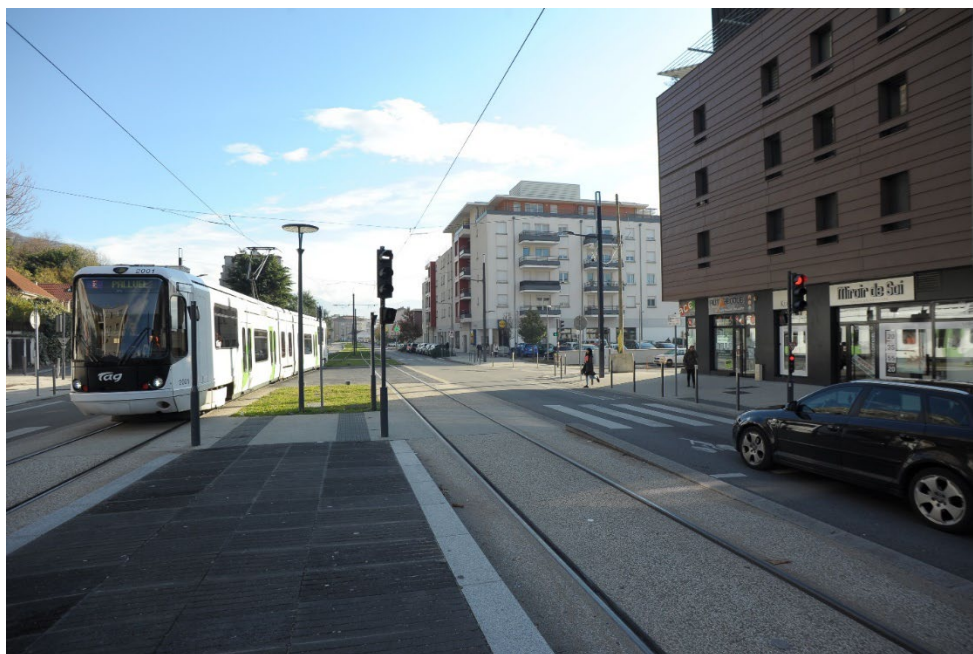
Nouveaux logements autour de l'extension de la ligne E du Tramway de Grenoble. Source : Visite Grenoble juillet 2018.
