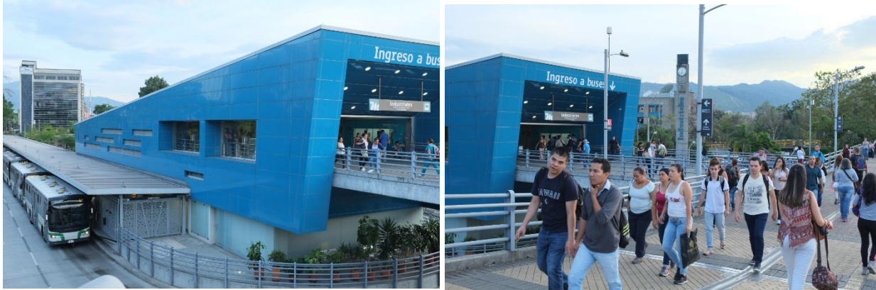
Pôle d'échange métro et bus BRT a la station Industriales à Medellín
