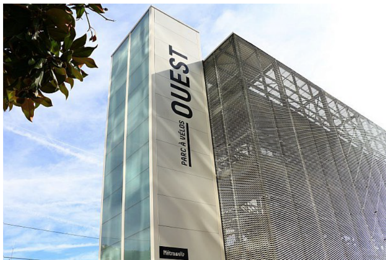
Structure de stationnement vélo à côté de la gare SNCF de Grenoble.
