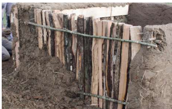
Fig. 5-104 - Construction du parement extérieur du mur nord.
