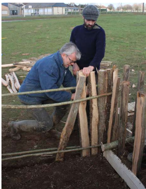
Fig. 5-84 - Installation des poteaux entre les traverses.
