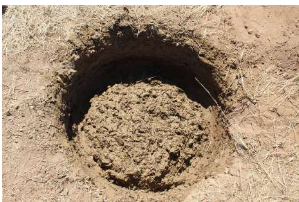
Fig. 5-96 - Préparation d'une terre à bâtir pour enduit en fosse.
