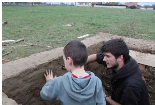
Fig. 5-67 - Lissage d'un enduit en terre avec un des écoliers, Nolan.
