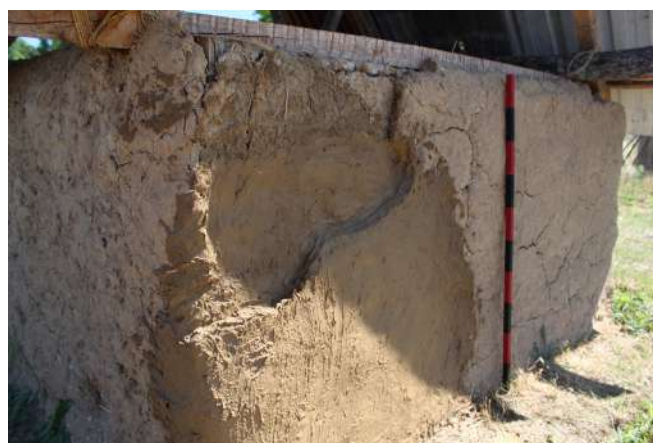
Fig. 5-113 - Pose d'un enduit sur une couche de torchis déjà sèche. Une bonne humidification de la surface est nécessaire.
