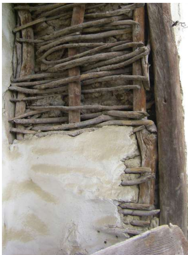
Fig. 4-65 - Clayonnage moderne photographié à Gortalovo (Bulgarie). En partie haute, le torchis et l'enduit sont tombés. En partie basse, on voit que la couche de torchis comble l'espace entre les baguettes, mais que c'est l'enduit qui les recouvre.
