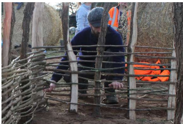
Fig. 5-80 - Construction de l'armature en clayonnage lâche du mur ouest.
