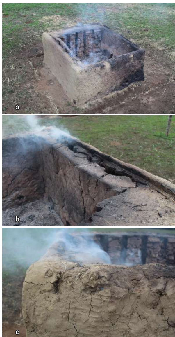
Fig. 5-159 - Buché à 900 min (15h). a. vue générale du bâtiment vers le sud-est ; b. de la fumée se dégage du faîte du mur nord ; c. de même pour le mur ouest.
