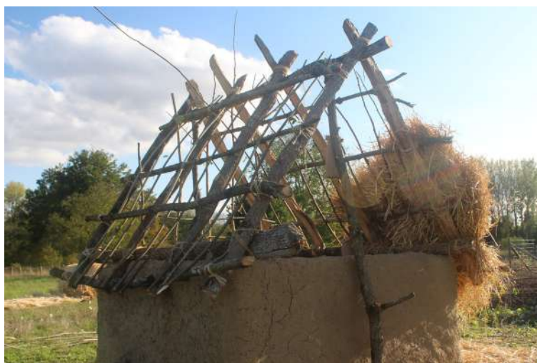
Fig. 5-131 - Vue vers le sud-ouest. Mise en place de perches ou baguettes de noisetier et de bouleau, clayonnées aux liteaux et parallèles aux chevrons.
