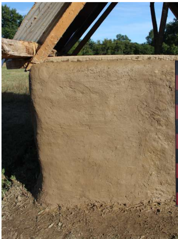
Fig. 5-112 - Enduit après lissage à la main avec ajout d'eau
