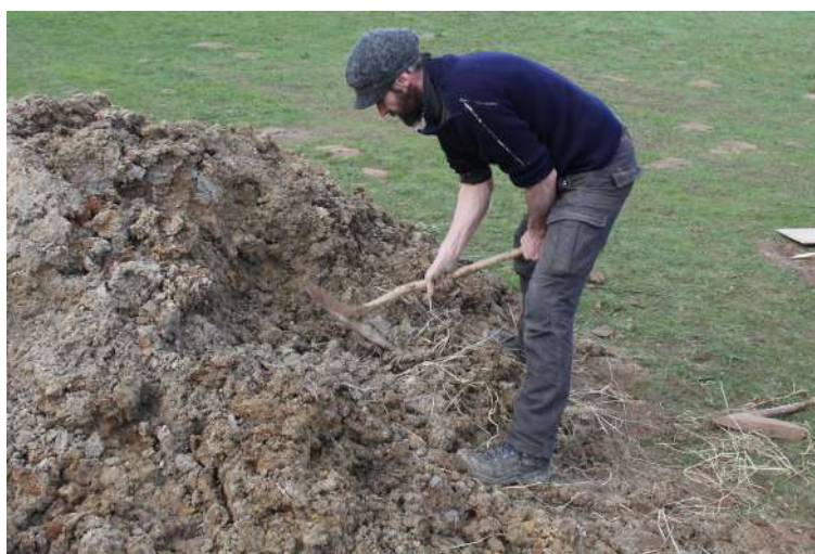
Fig. 5-94 - Fabrication de la terre à bâtir à même le tas de terre argileuse à l'aide d'un pic en bois.
