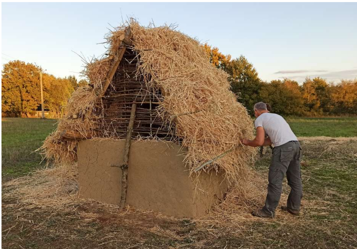
Fig. 5-133 - Maintien de la paille à l'aide de perches brêlées aux liteaux.
