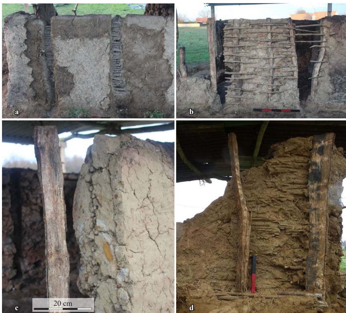
Fig. 5-165 - Démontage des murs en clayonnage. L'intérieur des murs n'a pas brûlé. a. tiers du mur sud prêt à être prélevé après le creusement des parments jusqu'à l'armature de bois ; b. mur ouest après prélèvement du parement extérieur ; c. coupe verticale du mur ouest avant prélèvement ; d. vue des empreintes abîmées du mur sud en cours de démontage.
