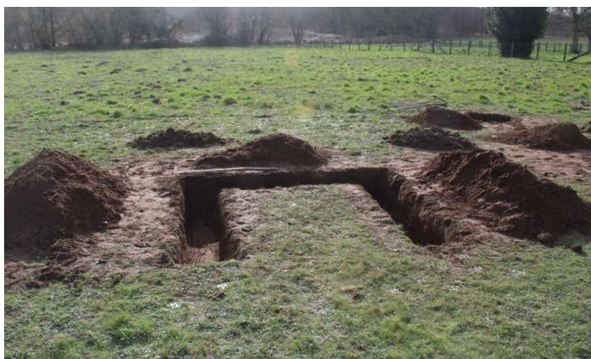
Fig. 5-70 - Vue vers le sud. Creusement des tranchées de fondation des murs terminées. Éch. bâton appointé = 1m.
