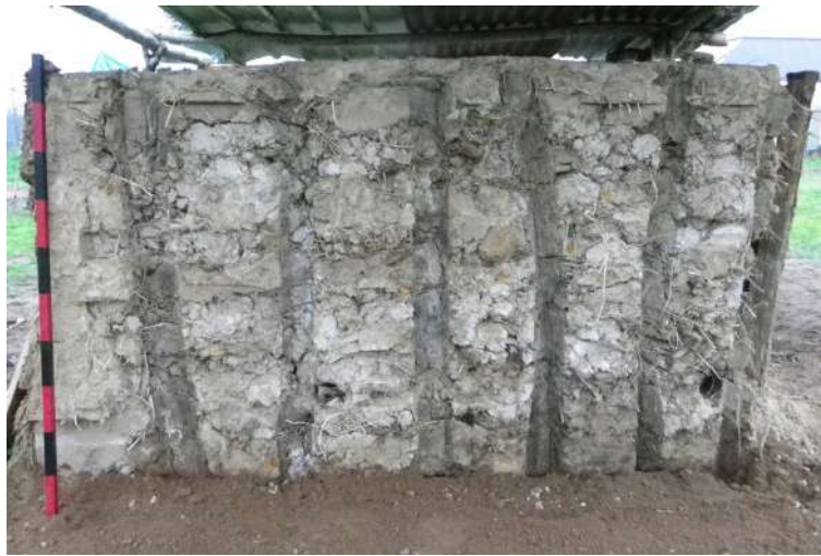
Fig. 5-166 - Parement extérieur du mur est après démontage des enduits et de l'armature en bois. Les empreintes des poteaux et des planches sont bien visibles.
