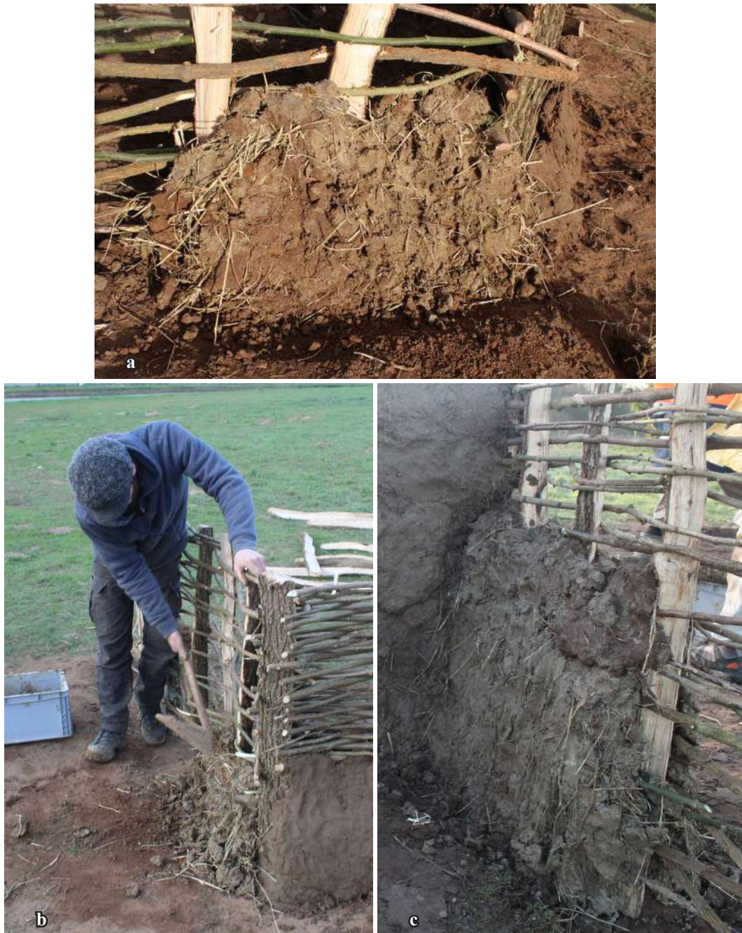
Fig. 5-102 - Application de la terre à bâtir par grosses mottes plaquées contre l'armature en bois. a. deux grosses mottes plaquées contre l'armature en clayonnage lâche ; b. utilisation d'un manche de pioche pour tasser la terre à bâtir ; c. les parements font dès la première application environ 10 cm d'épaisseur.
