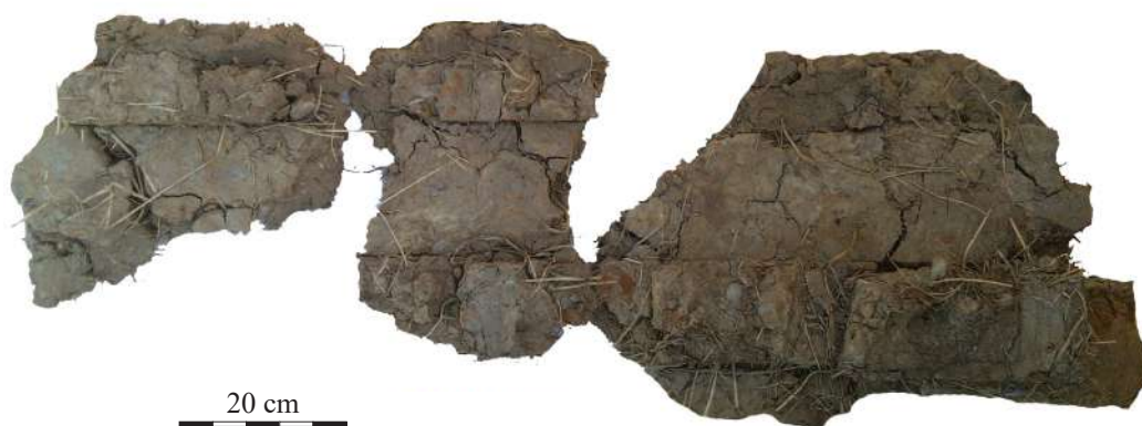
Fig. 5-186 - Enduit extérieur (4-004) du mur est ne présentant aucune trace d'incendie. Éch. 1:10.
