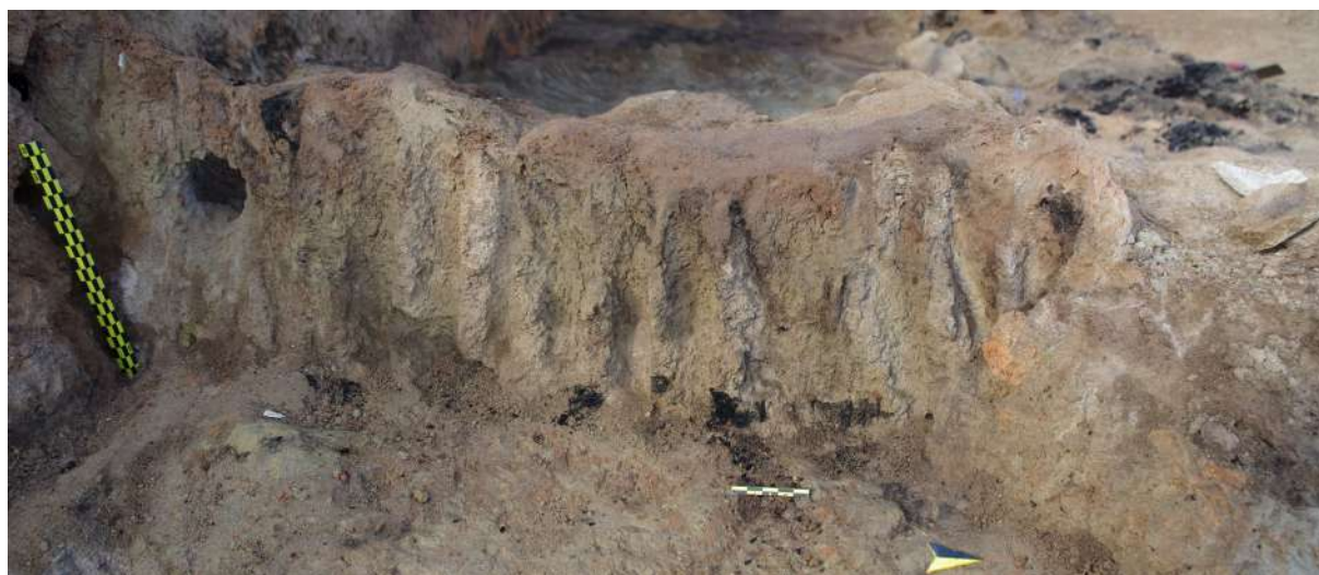
Fig. 4-86 - Portion in situ du mur est présentant une armature en poteaux jointifs. Cliché par A. Chohadzhiev.
