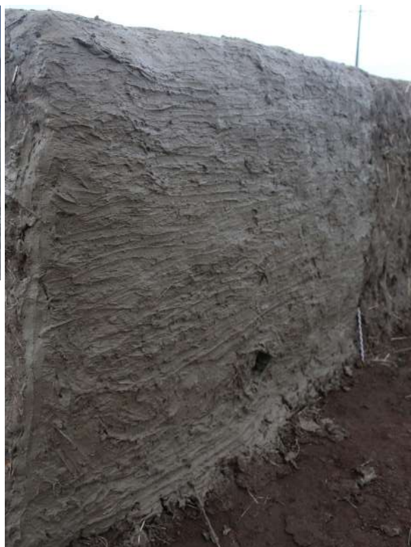
Fig. 5-109 - Parement extérieur du mur est après application d'un badigeon sur l'enduit.
