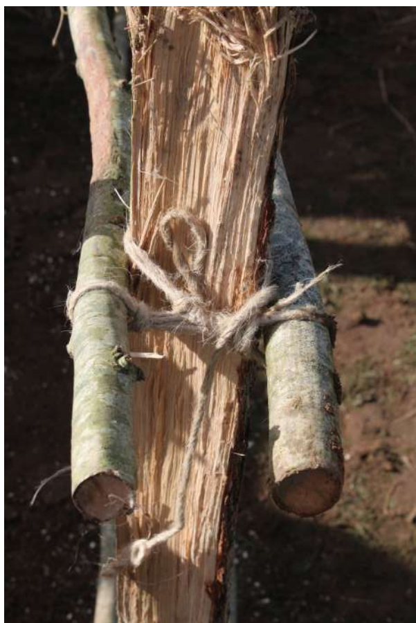
Fig. 5-83 - Brélage des traverses à un des poteaux corniers avec un lien végétal.
