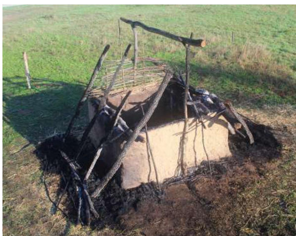
Fig. 5-144 - Vue vers le nord-est du bâtiment juste après l'incendie. Le pignon nord est encore en partie debout. Les extrémités basses des chevrons sont tombées au sol. Les poteaux faitiers et la panne faitière sont presque intacts..
