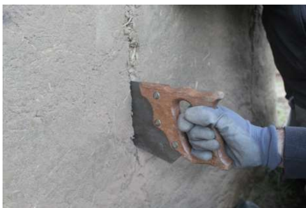
Fig. 5-162 - Découpage des murs à la scie égoïne.
