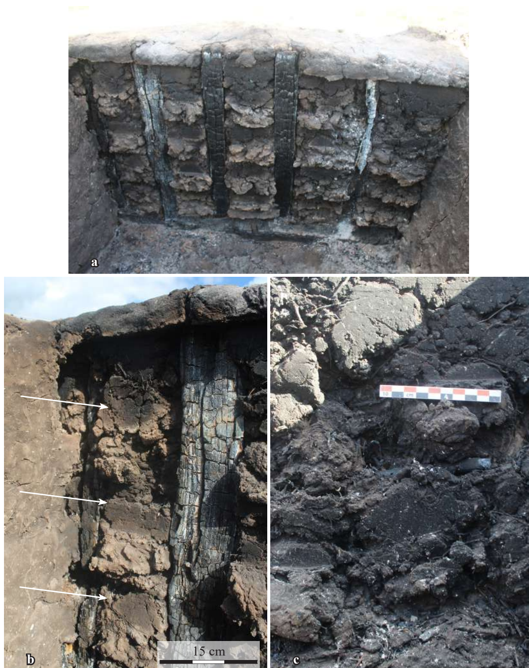
Fig. 5-150 - Parement intérieur du mur est après incendie. a. vue générale du parement, les planches horizontales ont brûlé, les poteaux sont carbonisés. Éch. hauteur du mur = 1 m. ; b. détail sur les empreintes des planches du parement en bois (flèche blanche) ; c. détail sur une baguette de remplissage carbonisée.
