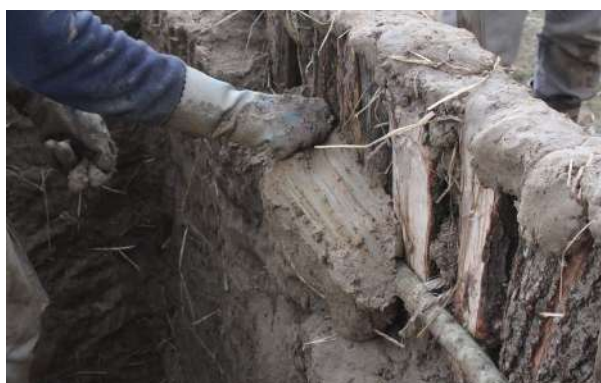
Fig. 5-106 - Application d'une briquette.
