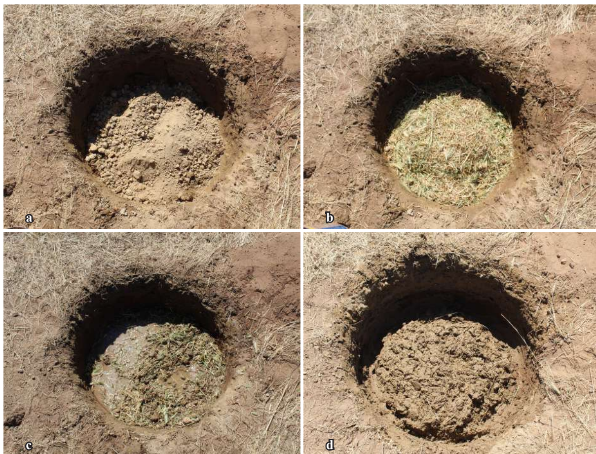
Fig. 5-98 - Préparation d'une terre à bâtir pour enduit avec un dégraissant de pailles fines et courtes. a. terre argileuse ; b. ajout des dégraissants ; c. ajout d'eau ; d. terre à bâtir prête après malaxage.
