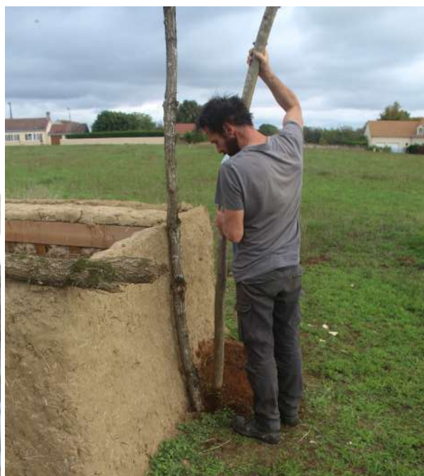
Fig. 5-126 - Tassement du sédiment autour du poteau faîtier sud.
