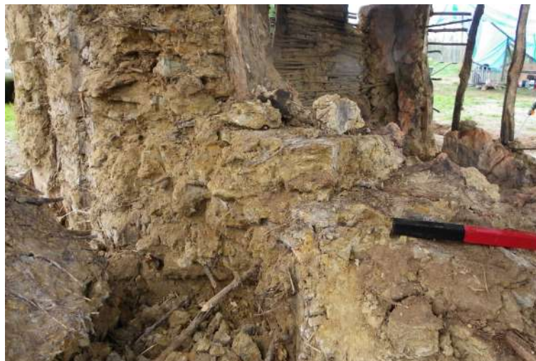
Fig. 5-167 - Démontage du remplissage du mur fait d'une succession de lits de terre tassée.
