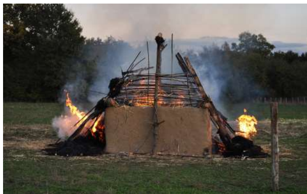
Fig. 5-141 - Incendie à 6min20 : les derniers chevrons encore en place tombent.
