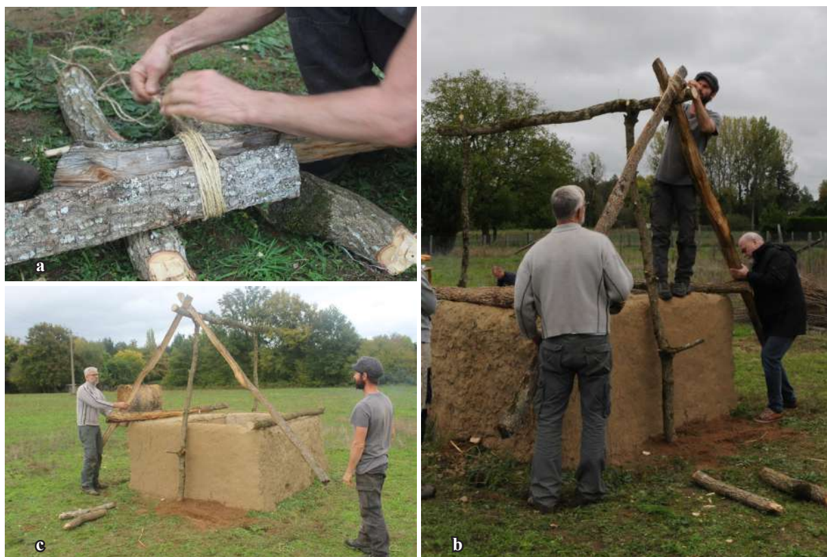
Fig. 5-127 - Mise en place des chevrons. a. tentative d'assemblage au sol ; b. installation des chevrons brêlés au sol, ils ne touchent pas les sablières hautes ; c. installation des chevrons en les brêlant sur la charpente.
