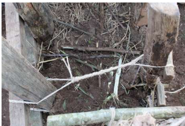
Fig. 5-89 - Exemple de brêlage des planches au niveau des poteaux des parements.
