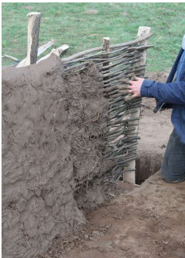
Fig. 5-99 - Application de la terre à bâtir contre l'armature végétale par projection de petites mottes à la main.
