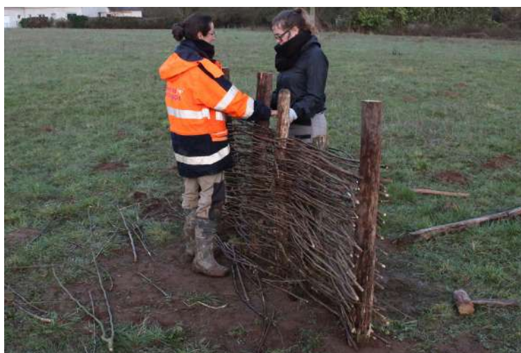
Fig. 5-82 - Construction de l'armature en clayonnage serré du mur n° 5.
