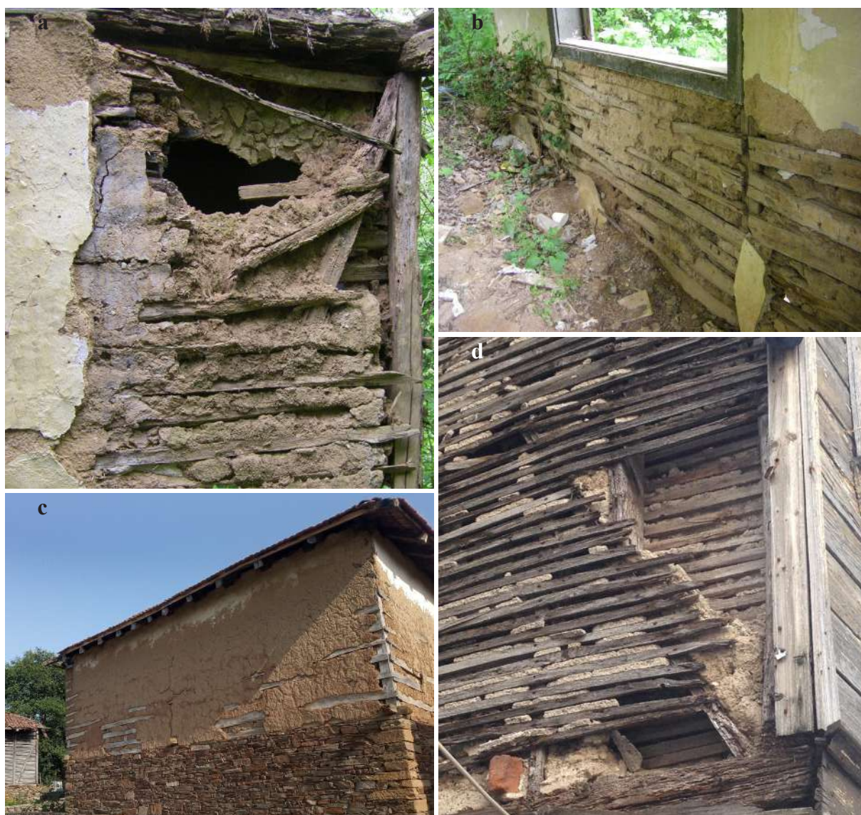
Fig. 4-23 - Exemples de murs construits avec un double parement de bois et un garnissage interne en terre à bâtir. Les parements sont recouverts d'un enduit de terre. Clichés de P. Bacoup (a, b, c) et C. Pagnoux (d). a. et b. Belogradchik (Bulgarie) ; c. Slišane (Serbie) ; d. Kavala (Grèce).
