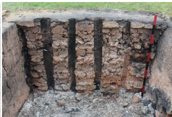
Fig. 5-161 - Parement intérieur du mur est après le buché.
