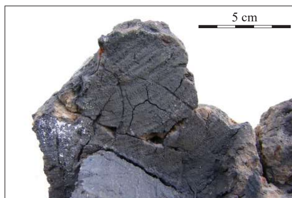
Fig. 5-170 - Détail sur la terre à bâtir recouvrant les abouts des poteaux du mur nord. Ensemble de fragments 1-002.
