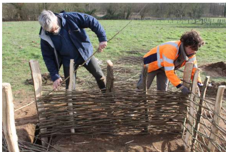
Fig. 5-81 - Construction de l'armature en clayonnage serré du mur sud.
