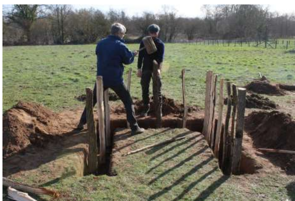
Fig. 5-76 - Mise en place des autres poteaux.
