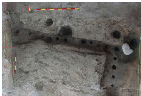
Fig. 4-13 - Vue zénithale des tranchées de fondation de l'angle nord-est du Bâtiment 127. Cliché par A. Chohadzhiev.
