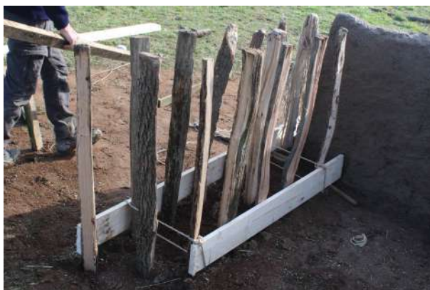
Fig. 5-88 - Mise en place des planches formant le double parement du mur.
