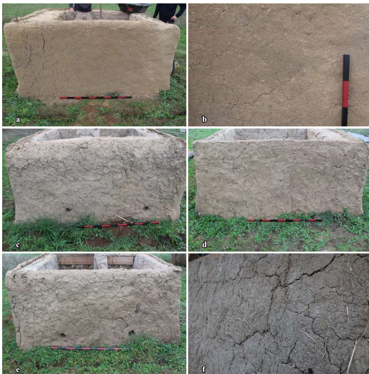
Fig. 5-118 - État des parements extérieurs des murs au moment de la construction de la charpente, juste avant l'incendie, soit 133 jours après la construction des murs et 90 jours après l'application des enduits. a. mur nord présentant une partie est avec des fissures et une partie ouest sans fissure puisque cette dernière a reçu un enduit de finition supplémentaire ; b. détail du parement du mur nord présentant des traces liées à la pluie ; c. mur est ; d. mur sud ; e. mur ouest ; f. détail du parement du mur ouest présentant des traces liées à la pluie.
