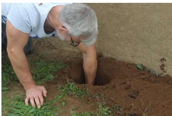
Fig. 5-123 - Creusement du trou pour fonder le poteau faîtier nord du bâtiment expérimental.
