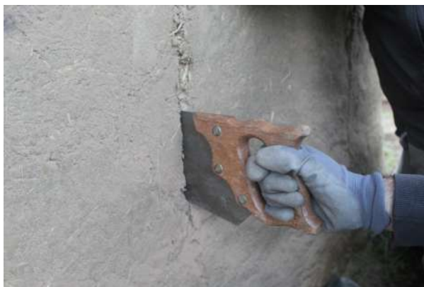
Fig. 5-162 - Découpage des murs à la scie égoïne.
