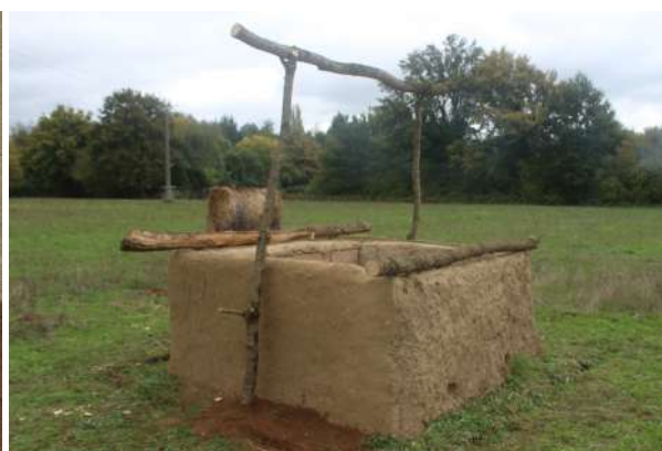
Fig. 5-124 - Vue vers le sud-est des poteaux faîtiers soutenant dans des fourches naturelles la faîtière de niveau.
