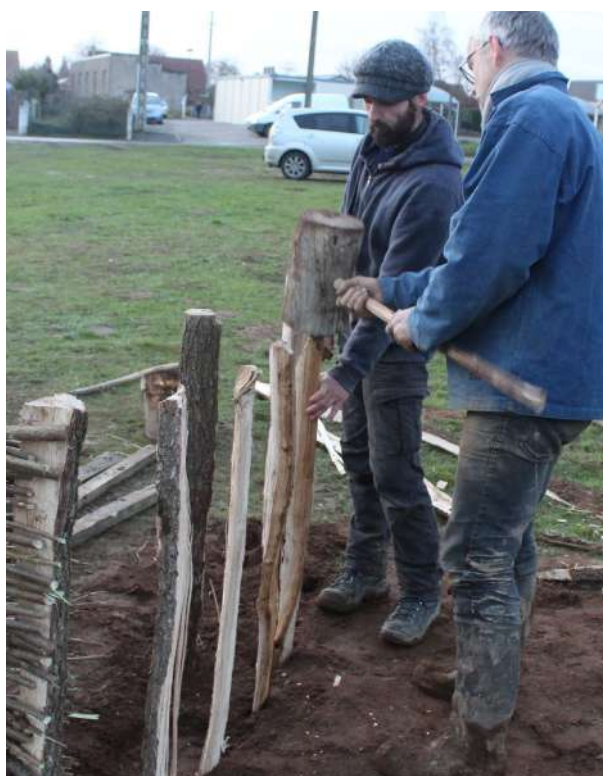
Fig. 5-87 - Installation des poteaux des parements.
