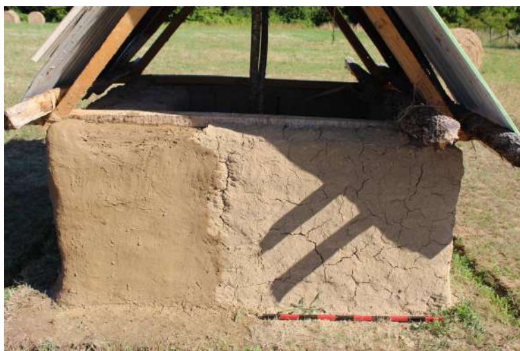
Fig. 5-116 - Parement extérieur du mur nord, réfection de la partie est terminée.
