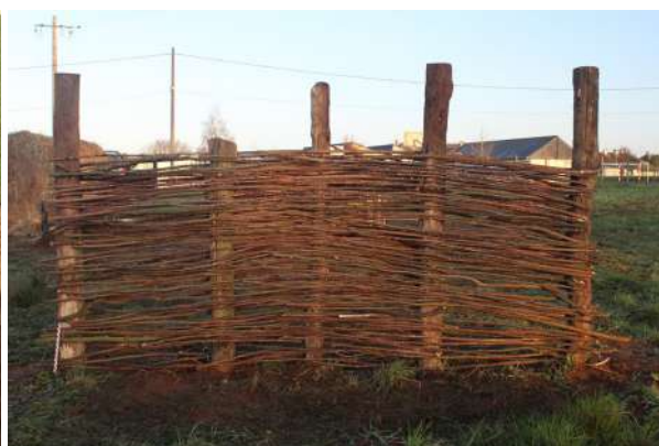
Fig. 5-79 - Armature en clayonnage serré du mur n° 5. Éch. hauteur maximale du clayonnage = 1 m.
