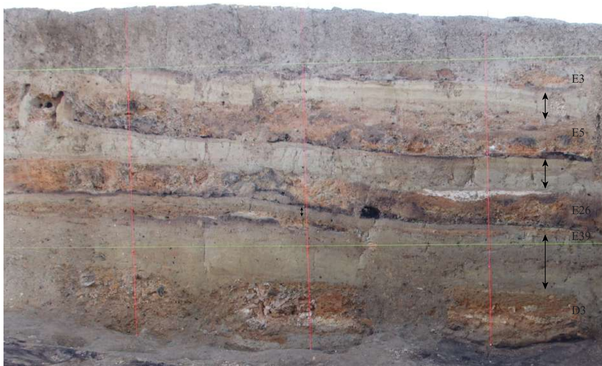
Fig. 4-104 - Profil sud du secteur E. Superposition stratigraphique des couches de destruction des bâtiments entre lesquelles se trouvent des couches de sédiments nivelés. Éch. espace entre fils de même couleur = 1 m. Cliché par A. Chohadzhiev.
