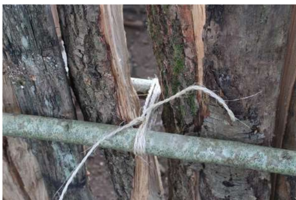
Fig. 5-85 - Lien permettant de serrer les deux traverses l'une vers l'autre.
