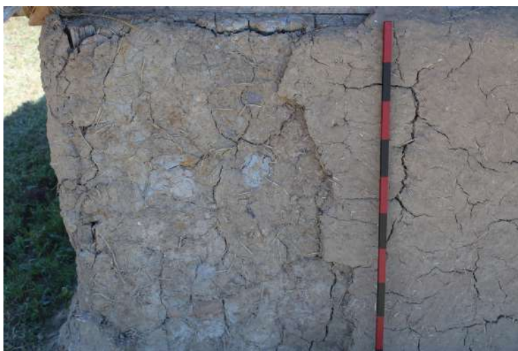
Fig. 5-115 - Parement extérieur du mur nord, l'enduit défectueux a été retiré afin de bien humidifier la couche de torchis et de réutiliser la terre à bâtir retirée.
