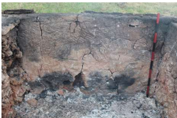
Fig. 5-160 - Parement intérieur du mur sud après le buché.
