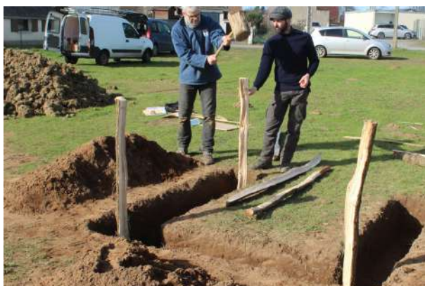
Fig. 5-75 - Mise en place des poteaux corniers.
