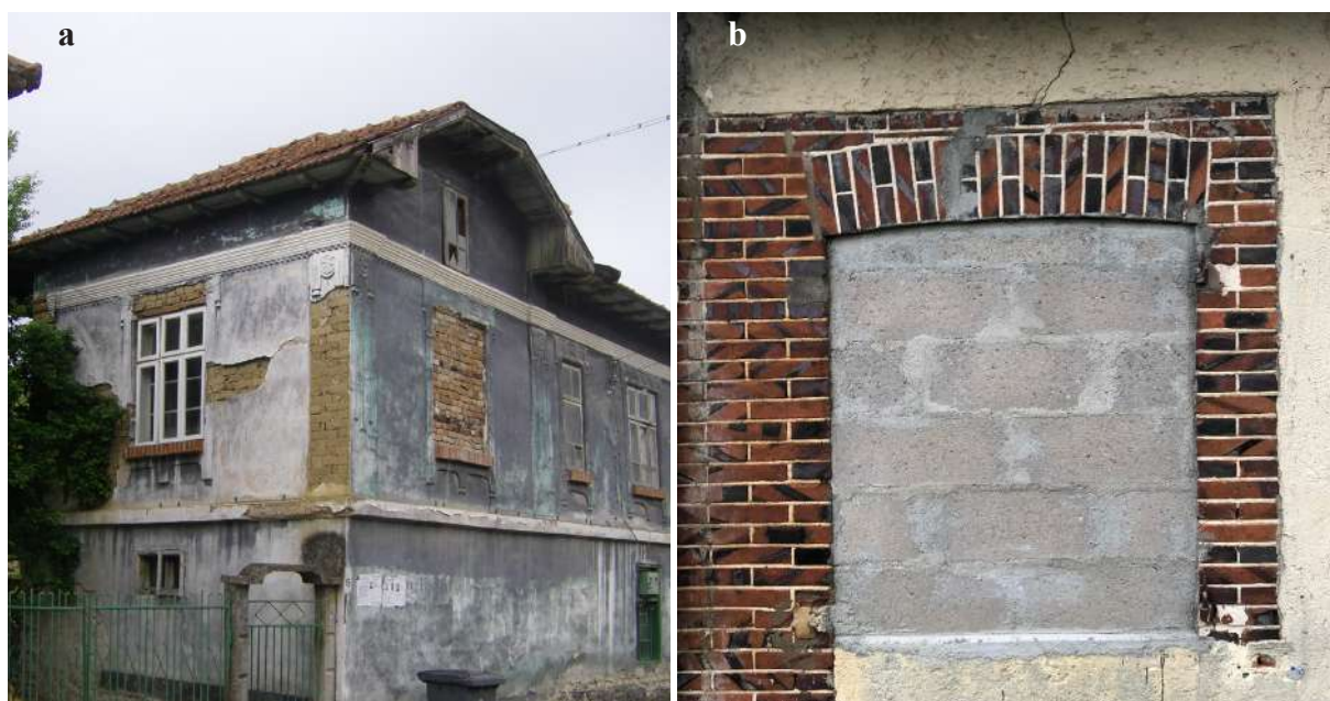
Fig. 4-97 - Comblement d'une ancienne ouverture avec un autre matériau ou une autre technique que ceux utilisés pour construire les murs. Clichés par P. Bacoup et N. Lereau. a. en brique cuite à Gortalovo (Bulgarie, 2019) ; b. en parpaings à Neuilly-sur-Eure (France, 2022).
