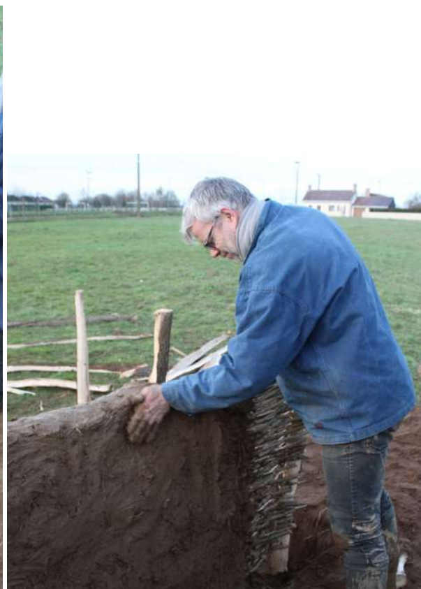
Fig. 5-100 - Tassement et lissage de la couche de torchis formée par projection de petites mottes.
