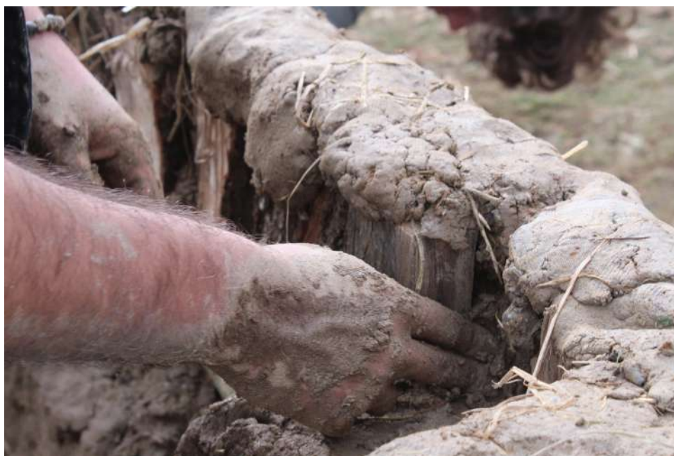
Fig. 5-107 - Mise en place de terre à bâtir entre les poteaux afin de lier les deux parements de terre.
