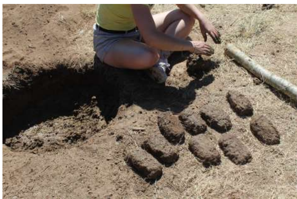
Fig. 5-111 - Préparation de « briquettes » pour réaliser l'enduit du parement extérieur du mur nord.
