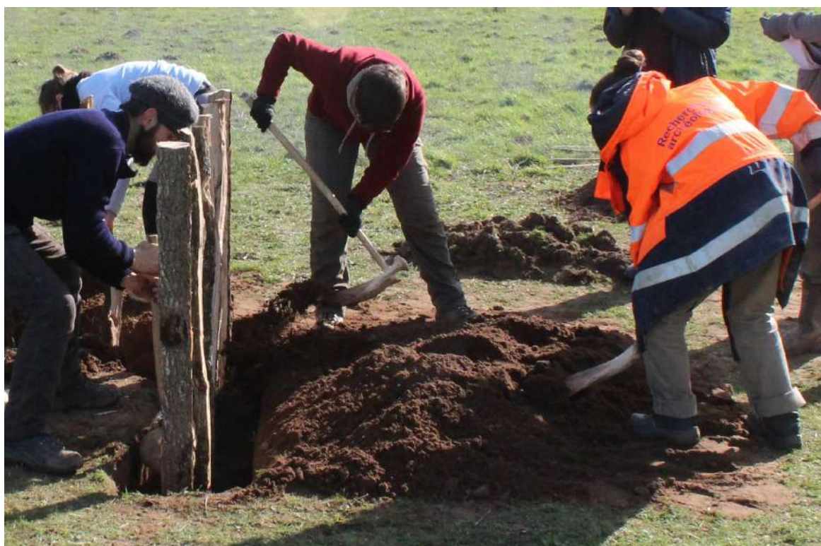
Fig. 5-77 - Comblement des tranchées de fondation après l'installation des poteaux.
