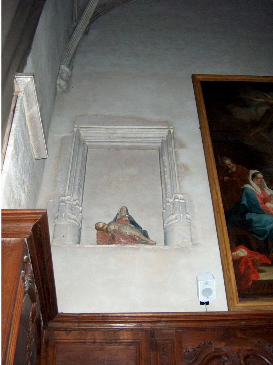
Figure 62 : Pont-de-Vaux, collégiale Notre-Dame, porte donnant sur le jubé disparu (ci-dessus) (cliché 2010), revers de la porte murée (ci-dessous à droite) et escalier permettant d'accéder à l'étage (à gauche), cliché 2014.
