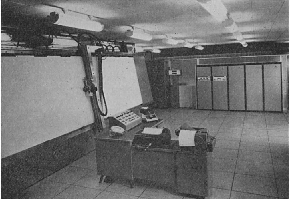
Fig. 3.7 — UNISURF : vue du système de dessin (source : Pierre Bézier, « Example of an Existing System in the Motor Industry: The Unisurf System », *Proceedings of the Royal Society of London. Series A, Mathematical and Physical Sciences*, vol. 321, n° 1545, 1971, p. 212).
