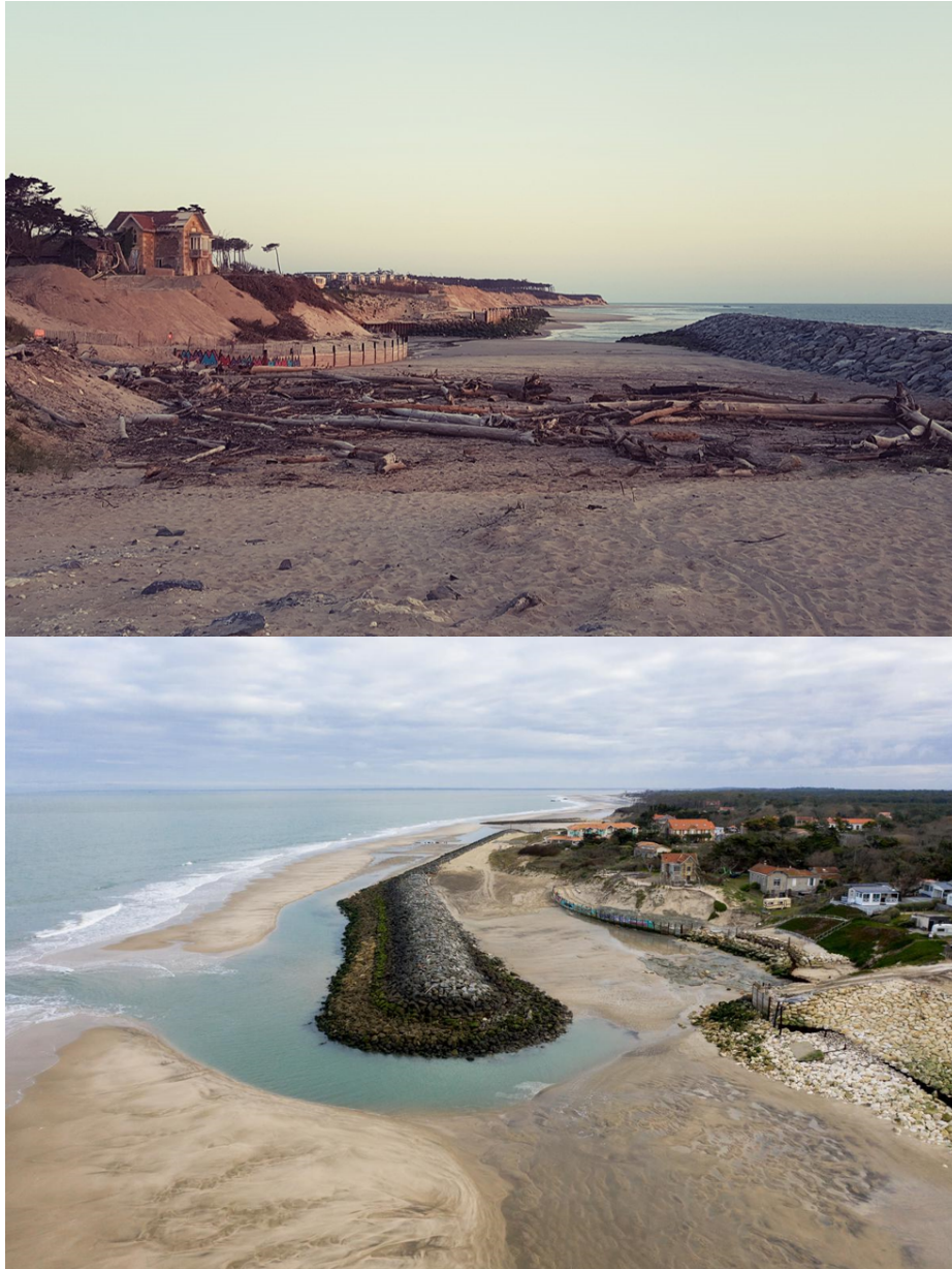
Photographie 12. Le perré longitudinal de la plage de l'Amélie à Soulac-sur-Mer, notamment rallongé pour protéger la villa « Surprise »
