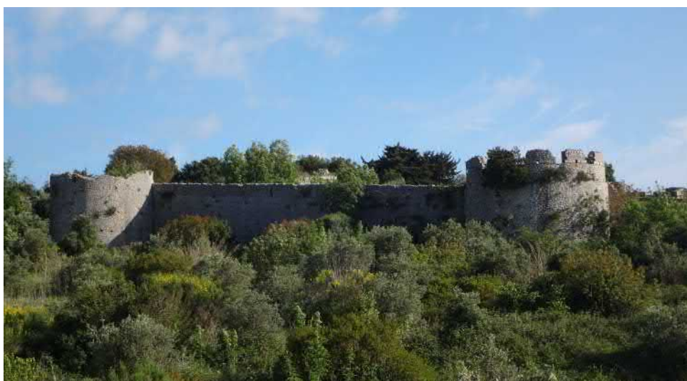
FIG. E.8 – La muraille de Terracine : les tours T1 (à gauche) et T2 (à droite)
