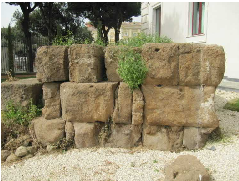
FIG. E.47 – La muraille « servienne » : restes de la porte Querquetulana (?) près de la gare Termini
