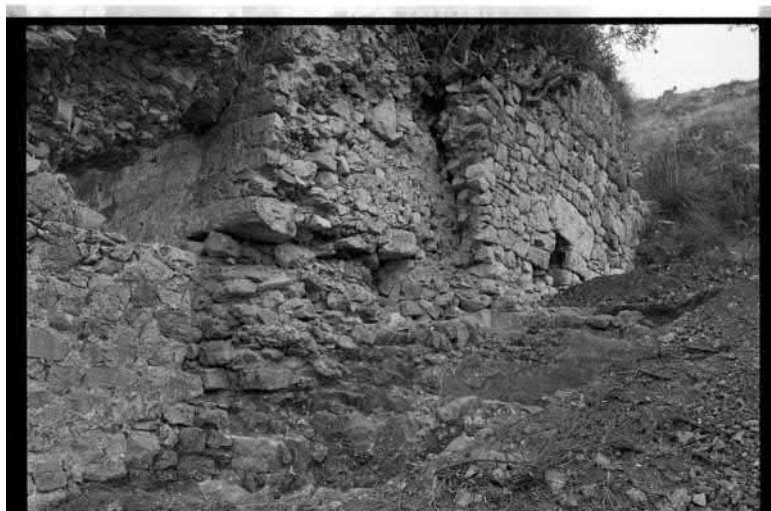
FIG. E.4 – La villa Prato : effondrement du muret de parement à l'angle sud-ouest du podium (photographie H. Broise et X. Lafon, neg. 2187)
