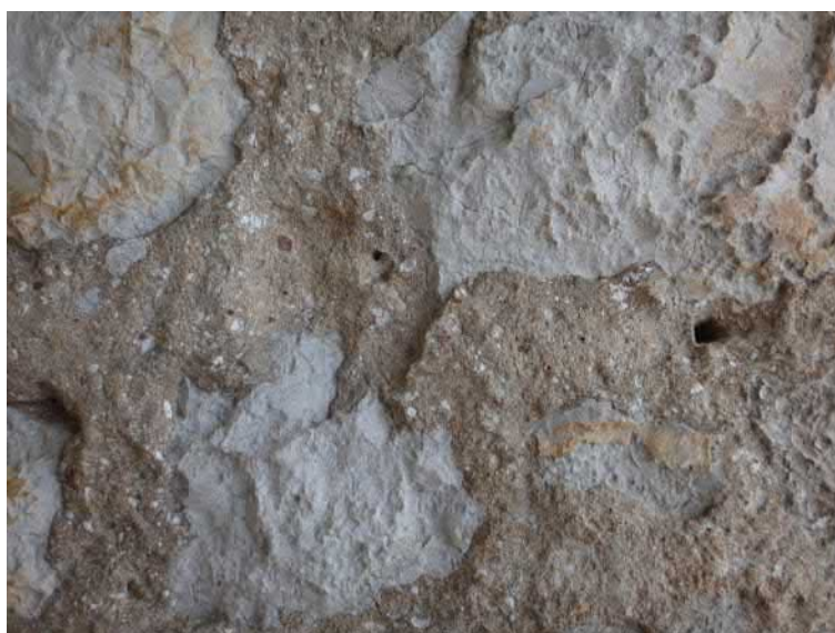
FIG. E.14 – La muraille de Terracine : mortier
