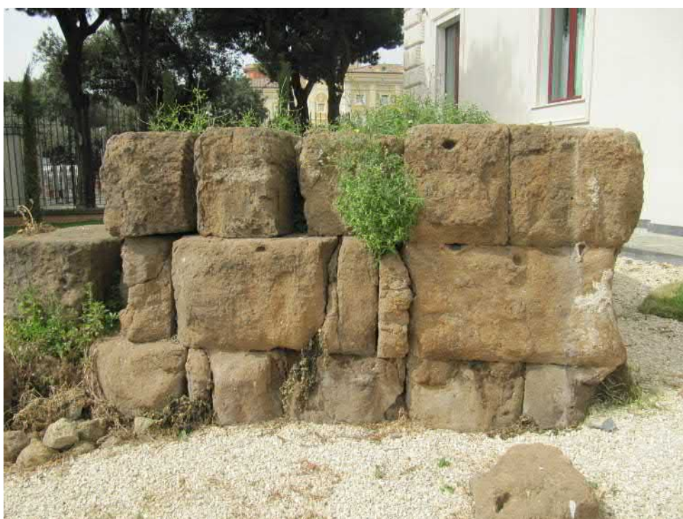
FIG. E.47 – La muraille « servienne » : restes de la porte Querquetulana (?) près de la gare Termini
