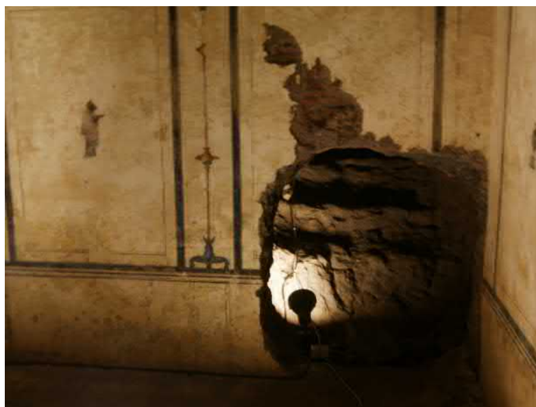
FIG. E.44 – La pyramide de Cestius : maçonnerie interne visible dans un trou de tombaroli (photographie C. Dubois)
