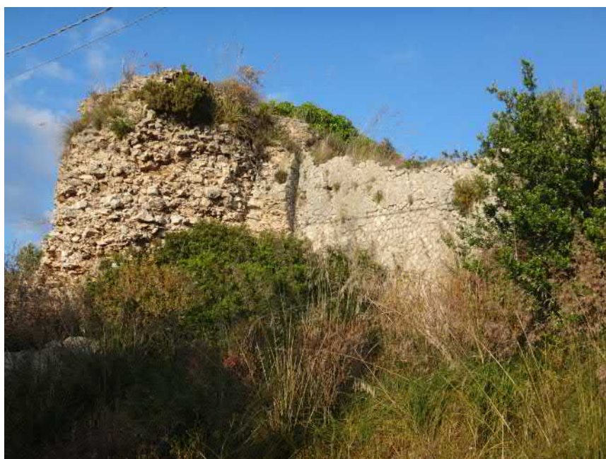
FIG. E.21 – La muraille de Terracine : maçonnerie interne de la tour T8
