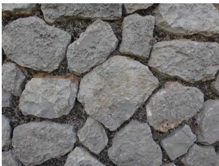
FIG. E.15 – La muraille de Terracine : blocs en remploi dans du mortier moderne
