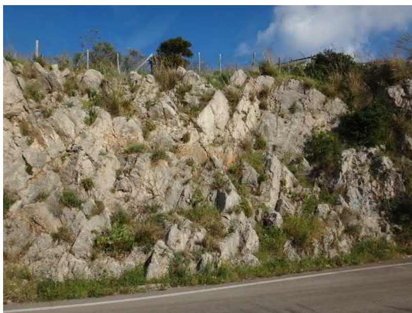
FIG. E.13 – La muraille de Terracine : paroi rocheuse le long de la route menant au sanctuaire
