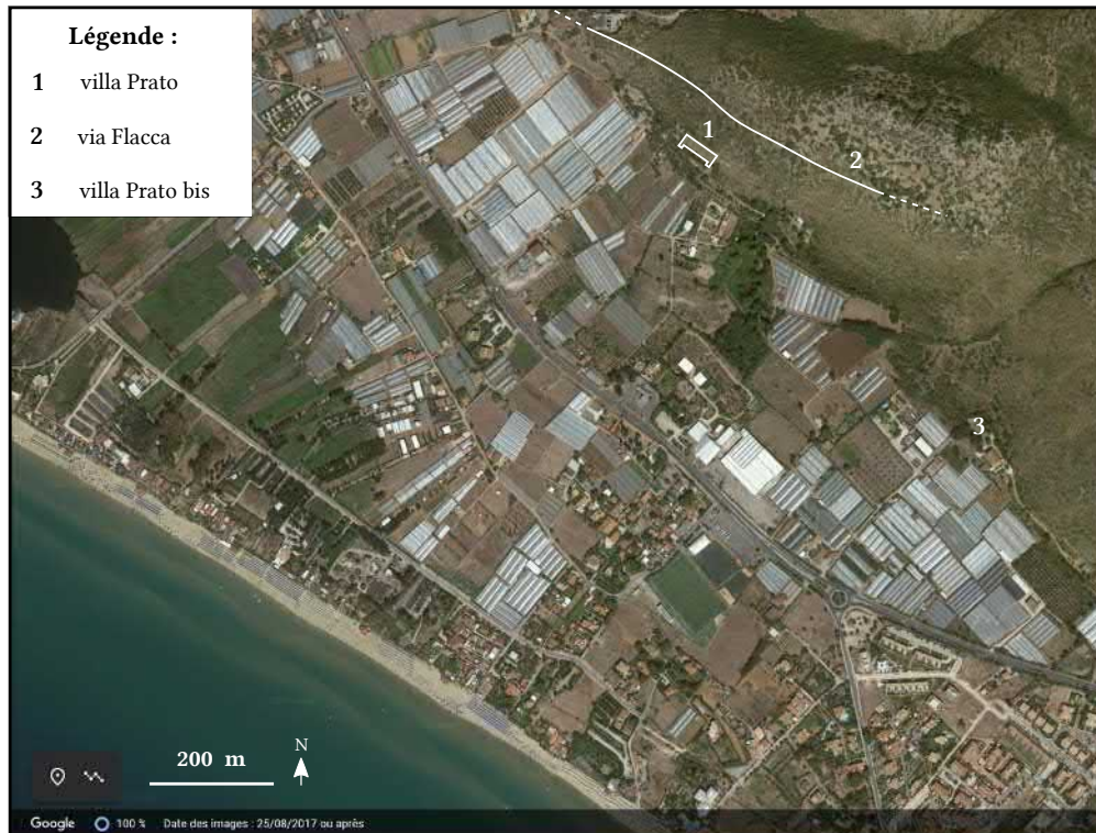
FIG. E.1 – La villa Prato : situation générale (à partir de Google Earth )
