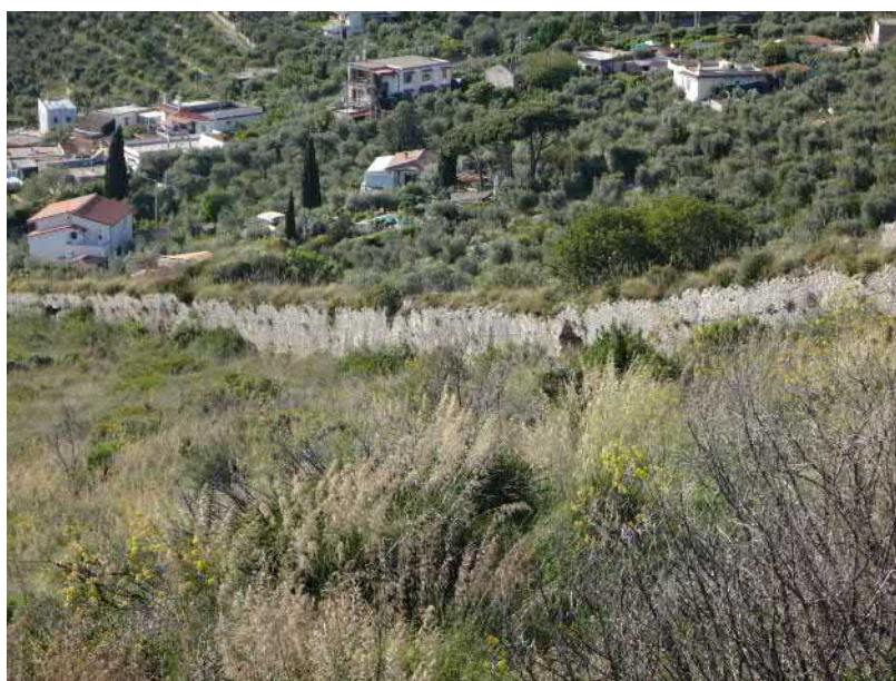
FIG. E.10 – La muraille de Terracine : vue générale au niveau de T5-T6
