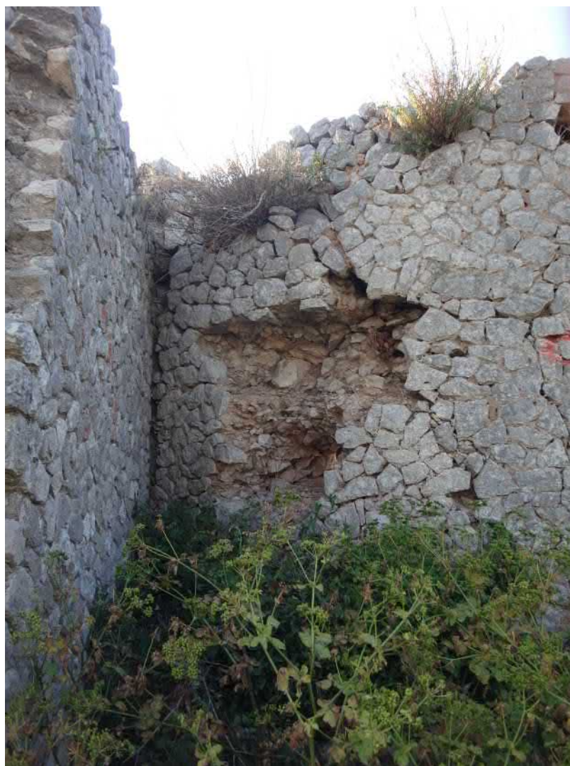
FIG. E.16 – La muraille de Terracine : maçonnerie sud-est de la tour T3
