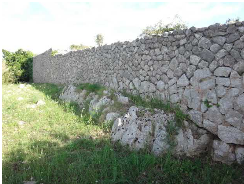
FIG. E.11 – La muraille de Terracine : affleurement de la roche
