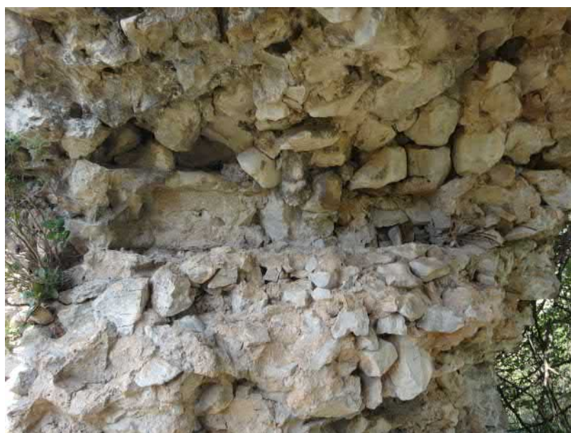
FIG. E.9 – La muraille de Terracine : traces de la porte secondaire entre T5 et T6
