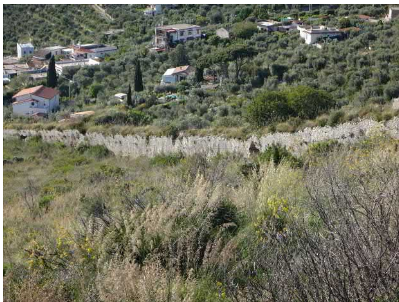
FIG. E.10 – La muraille de Terracine : vue générale au niveau de T5-T6
