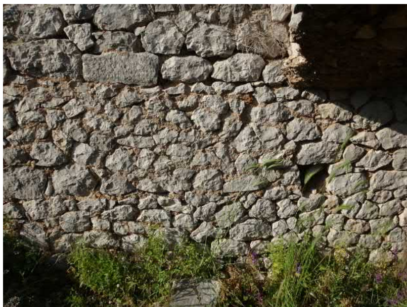
FIG. E.7 – La muraille de Terracine : opus incertum dans le couloir d'entrée du sanctuaire
