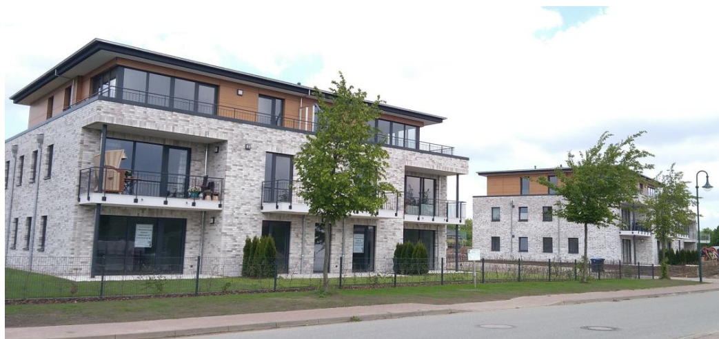
Figure 6.7 - Lotissements en construction à Zarrentin
