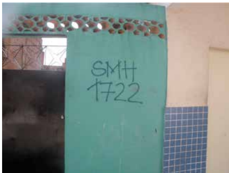
Figura 8 - Marcação da casa a ser demolida. Fonte: Reginensi, 2012.
