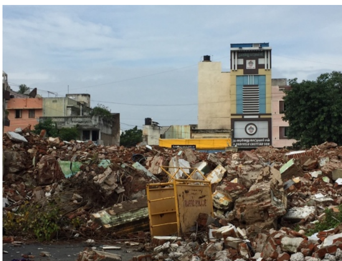
Figure 1 : Ruines de la prison centrale de Pondichéry (nb, 2017)
