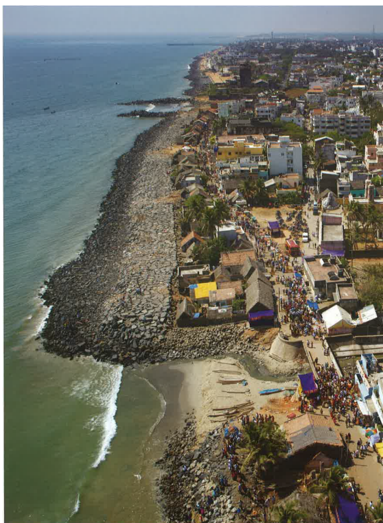
Figure 33 : Vaithikuppam, Pondichéry : enrochements et ancienne route de Madras (Source : Smart City Mission, 2017)
