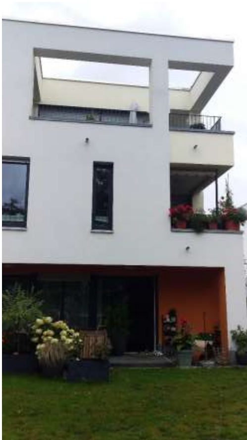
41 Unna, 21/08/2021, MIR. Logements avec espaces privatifs et accessibles
