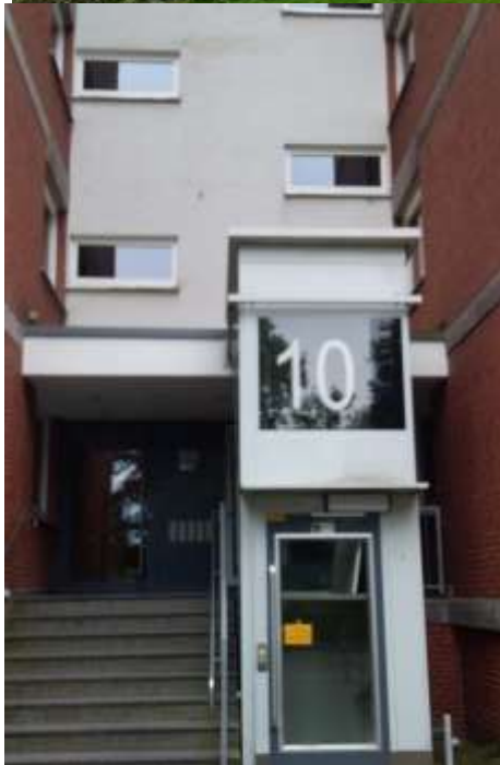
43Dortmund, 18/08/2021, MIR. Adaptation des parties extérieures après réhabilitation
