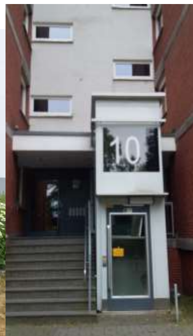
71 Dortmund, 17/08/2021, MIR. Ascenseur après réhabilitation DogeWo21
