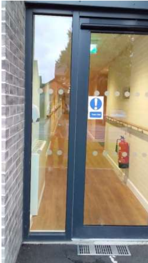
51 Burry, 26/10/2021, MIR. Couloir accessible avec porte indépendante d'appartements
