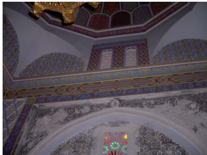
Photo. 3 : Décor de stuc moulé et peint d'époque ottomane de la salle du tombeau partiellement restauré. (© Bulle Tuil )
