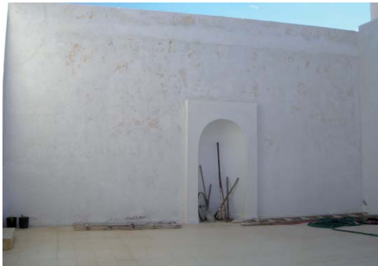
Photo. 4 : Cour- masḡid accolée au mausolée et desservant les espaces annexes utilisés comme maison du gardien. (© Bulle Tui )
