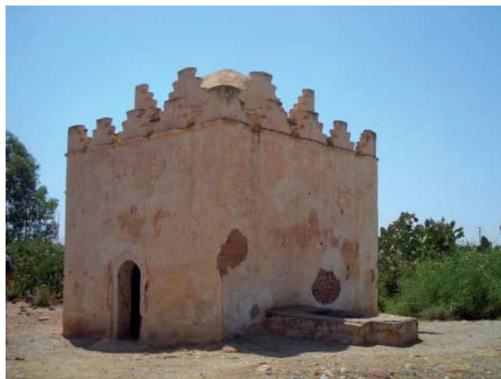
Photo. 1 : Vue extérieure du mausolée de Sīdī al-Hizmīrī (1/A/M). (© Bulle Tuil )
