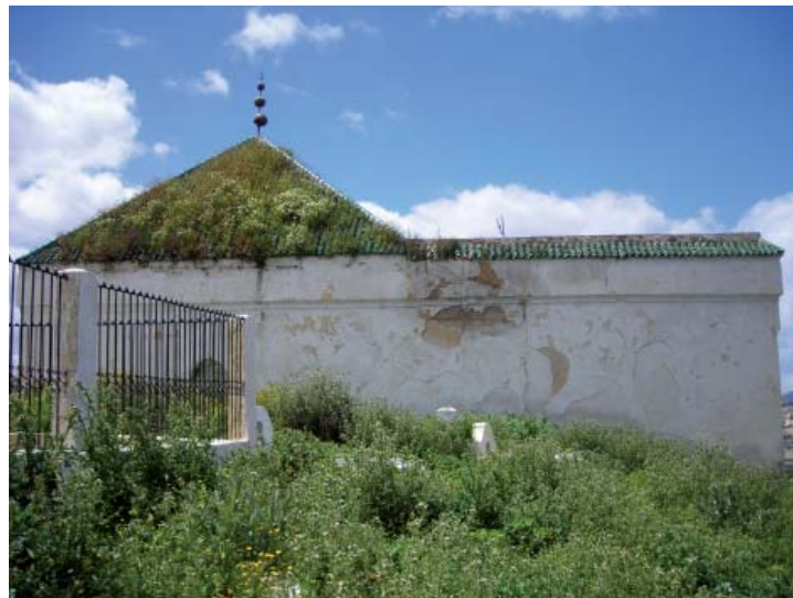
Photo. 1 : Vue extérieure du mausolée de Sīdī Ḥarazem (4/F/M). (© Bulle Tuil)
