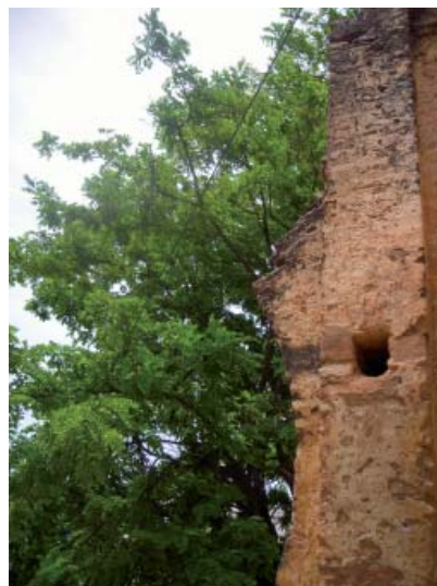
Photo. 3 : Détail du départ d'un arc vers l'Ouest sur le mausolée de Sīdī Ishaq al-Ṭayyār (3/T/A). (© Bulle Tuil )
