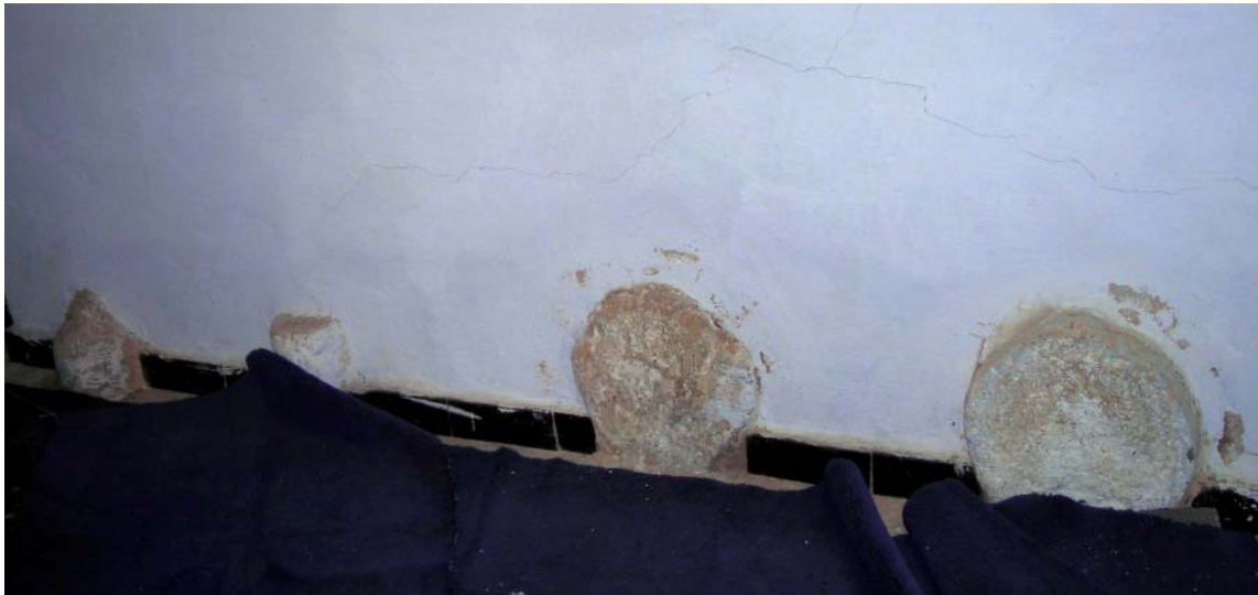
Photo. 1 : Stèles discoïdales et cippes localisés dans le chancel accueillant la sépulture d'Ibn Abī Zayd (3/K/T). (© Bulle Tuil)
