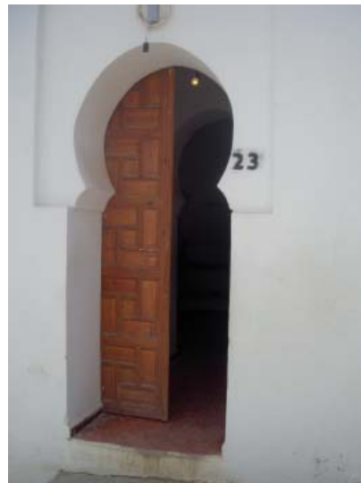
Photo. 3 : Entrée des latrines associées au complexe de Sīdī Abū Madyan (1/T/A). (© Bulle Tuil )
