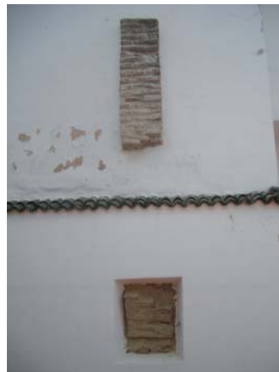
Photo. 4 : Départ d'arc sur le mur nord du vestibule du mausolée. (© Bulle Tuil)
