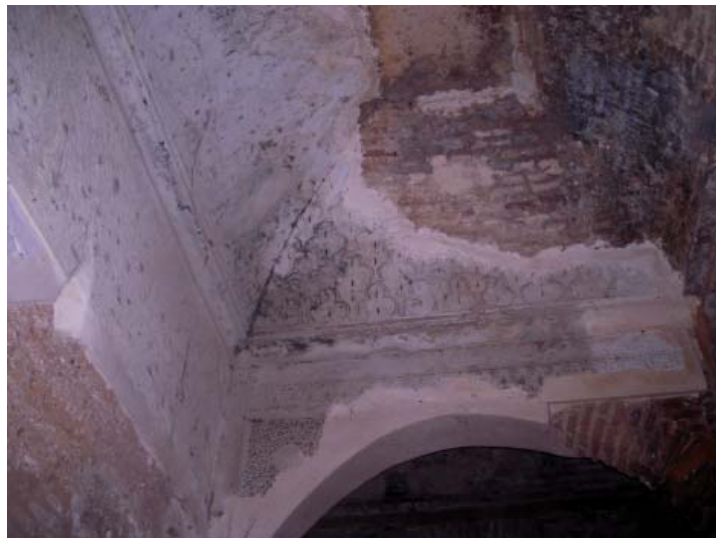
Photo. 5 : Décor en stuc conservé dans la grande pièce Sud du bâtiment 3. (© Bulle Tuil)
