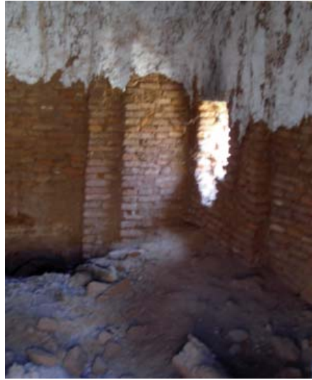
Photo. 1 : Vue intérieure du mausolée de Sīdī Sa‘dūn (2/A/M) présentant son mihrab et sa baie au Sud-ouest. (© Bulle Tuil )
