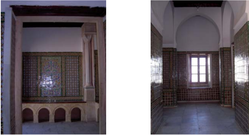
Photo. 1 et 2 : Driba et couloir reliant la madrasa à la cour principale de Sīdī al-Balawī (4/K/T). (© Bulle Tui )
