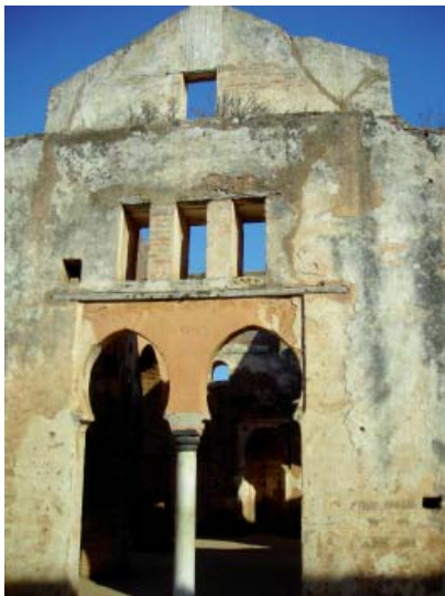
Photo. 3 : Mur pignon de la mosquée. (© Bulle Tuil)
