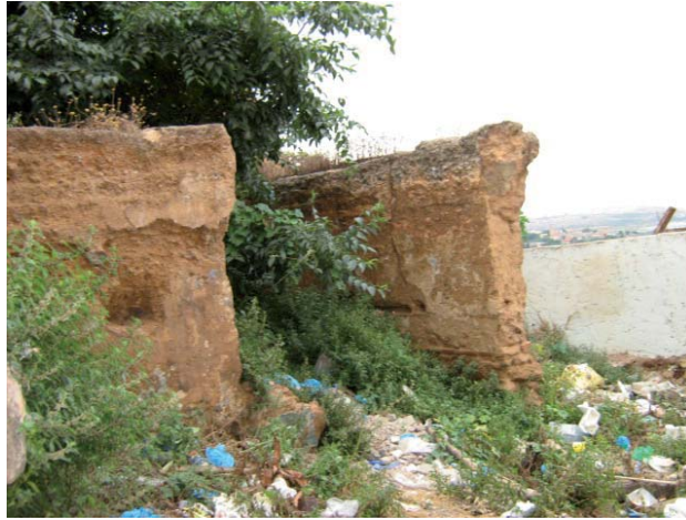
Photo. 1 : Vestiges localisés à l'Est du Dār al-Sulṭān en contrebas. (© Bulle Tuil )
