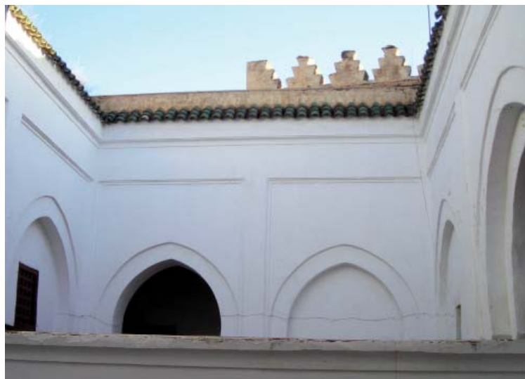
Photo. 2 : Vue de la cour du mausolée de Sīdī Bel 'Arīf (1/M/M). (© Bulle Tuil)
