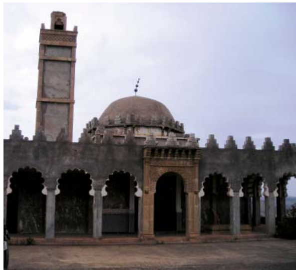
Photo. 1 : Vue générale de l'ensemble dédié à 'Abd Allāh b. Yasīn (1/P) depuis le Sud-est. (© Bulle Tuil )
