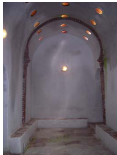
Photo. 6 : Salle chaude des bains. (© Bulle Tui )
