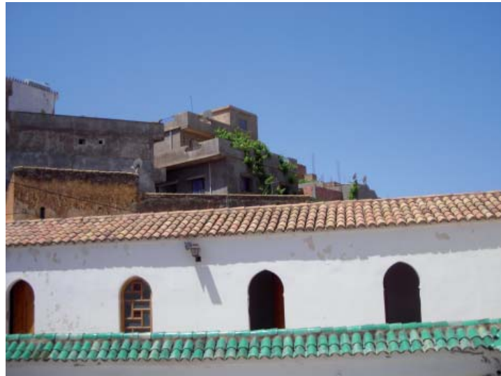
Photo. 1 : Cellules de la madrasa du second niveau, ouvrant sur les toits. (© Bulle Tuil)
