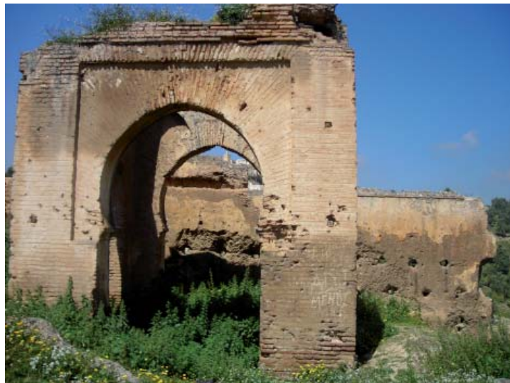
Photo. 2 : Mausolée sur la pente Nord vu depuis l'intérieur de l'enclos. (© Bulle Tuil )
