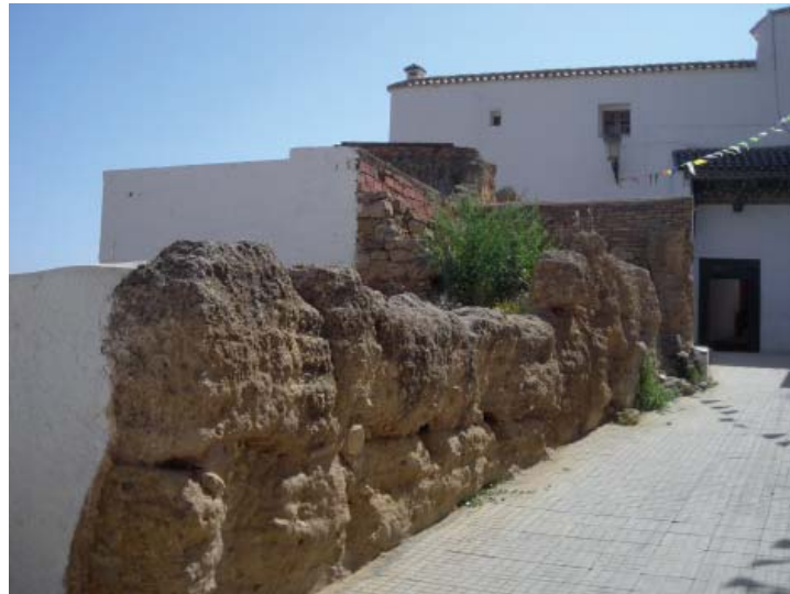
Photo. 1 : Vestiges en pisé suivant l'orientation du Dār al-Sulṭān mais localisés au niveau de l'entrée du sanctuaire. (© Bulle Tuil)
