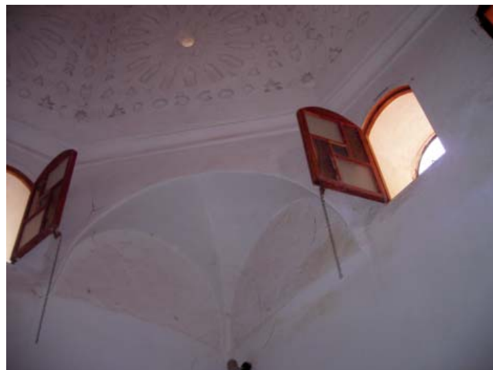
Photo. 3 : Trompe assurant la transition entre l'élévation de la salle centrale et la coupole. (© Bulle Tuil )
