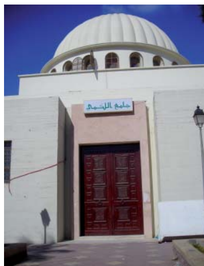
Photo. 4 : Entrée principale de la grande mosquée de Sīdī Bou al-Ḥasan (1/S/T). (© Bulle Tuil )
