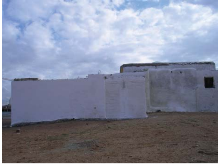
Photo. 1 : Vue extérieure des dépendances de Sīdī al-Dukkālī (1/Sal/M). (© Bulle Tuil )
