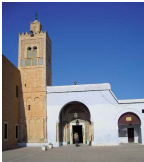
Photo. 2 : Minaret et entrée vers la zāwiya de Sīdī al-Balawī (4/K/T) vus depuis la cour principale. (© Bulle Tuil )
