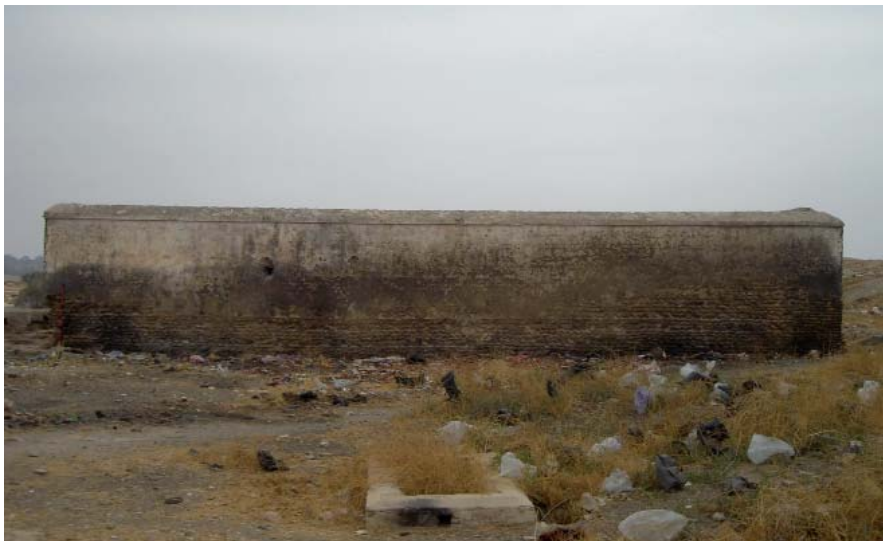
Photo. 1 : Vue générale de la rawḍa d'Ibn 'Abbād (6/F/M) depuis le Nord-est. (© Bulle Tuil )
