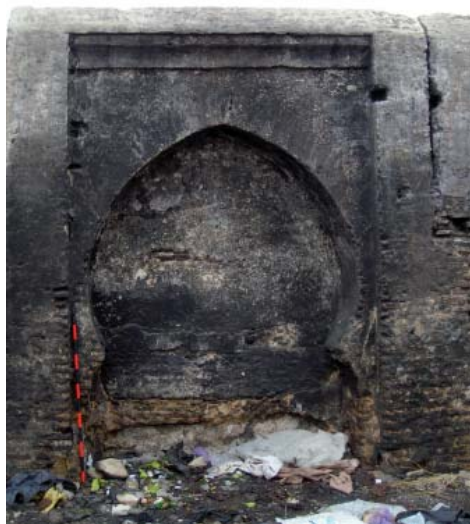
Photo. 3 : Vue intérieure d'une niche de la façade Nord-ouest de la rawḍa d'Ibn 'Abbād (6/F/M). (© Bulle Tuil )
