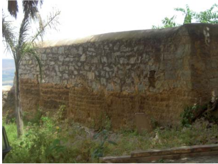
Photo. 1 : Mur Nord-est bordant l'espace arrière de la salle du tombeau, associé à des vestiges au niveau inférieur. (© Bulle Tuil)
