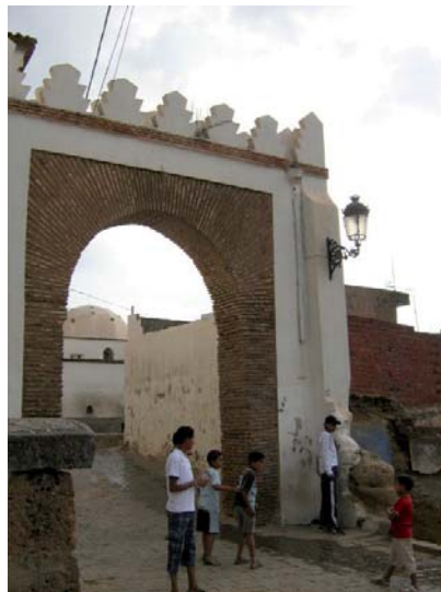
Photo. 2 : Entrée de la rue desservant la mosquée, le cimetière et les latrines associées à la tombe de Sīdī al-Ḥulwī (4/T/A). (© Bulle Tuil )
