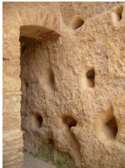
Photo. 4 : Rétrecissement de la pièce Ouest du bâtiment 2. (© Bulle Tuil)
