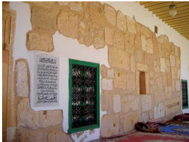
Photo. 2 : Mur sur la cour de la salle du tombeau- masğid de Sīdī Bou Labāba (1/G/T) où sont conservées des portions de l'élévation antérieure. (© Bulle Tuil )
