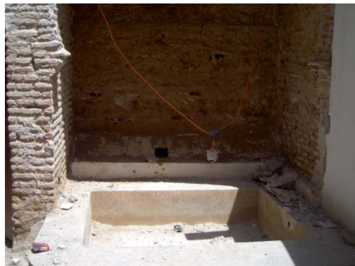
Photo. 4 : Bassin d'ablution des latrines de la madrasa. (© Bulle Tuil)
