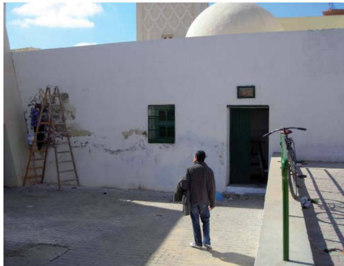
Photo. 1 : Vue générale de la zāwiya de Sīdī Bou al-Ḥasan (1/S/T) et de son entrée. (© Bulle Tuil )
