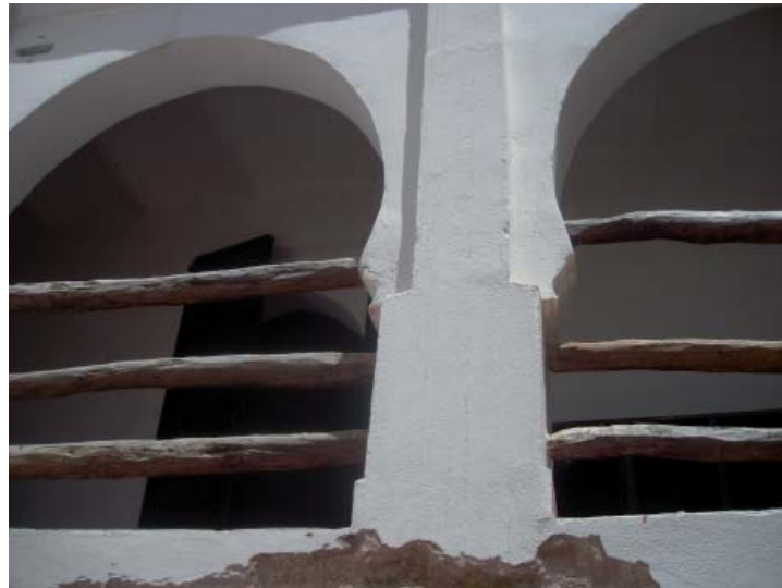
Photo. 1 : Galerie et chambre du second niveau donnant sur la cour, dans l'ancienne maison des gardiens. (© Bulle Tuil )
