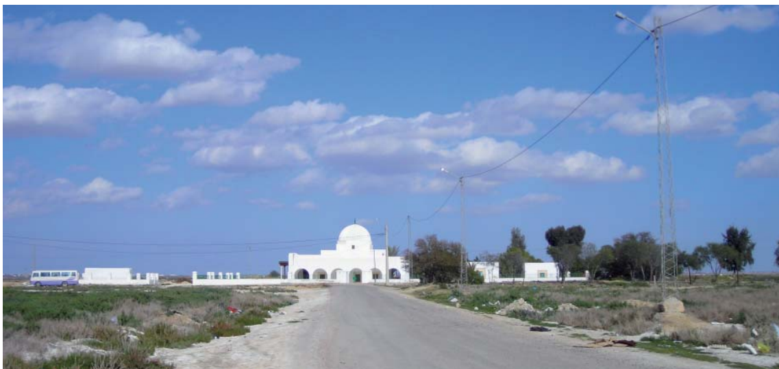
Photo. 1 : Vue générale du mausolée de l'Imām Saḥnūn (1/K/T) depuis le Sud. (© Bulle Tuil )
