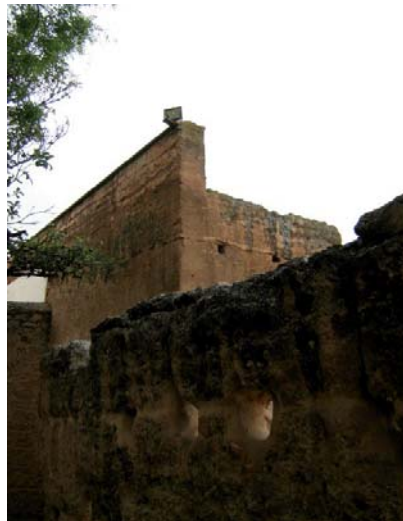
Photo. 3 : Elévation du bâtiment 1 du Dār al-Sulṭān vue depuis le jardin à l'arrière du mausolée. (© Bulle Tuil)
