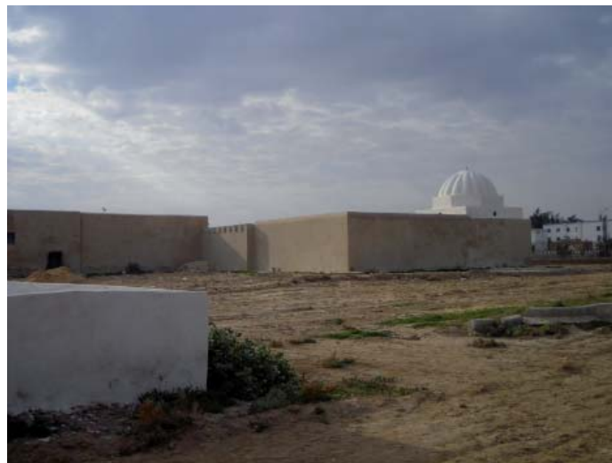
Photo. 1 : Mausolée de Sīdī al-Qābisī (2a/K/T) vu depuis le cimetière Hatbiyya au Nord. (© Bulle Tuil)
