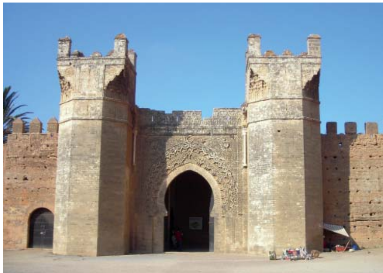
Photo. 1 : Porte monumentale de la nécropole mérinide de Chella (3/P) ouvrant à l'Ouest, surmontée par la dédicace du sultan Abū al-Ḥasan. (© Bulle Tuil )
