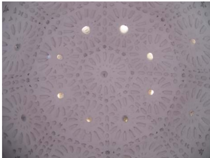
Photo. 2 : Coupole au décor de stuc sculpté surmontant la salle centrale des latrines. (© Bulle Tuil )
