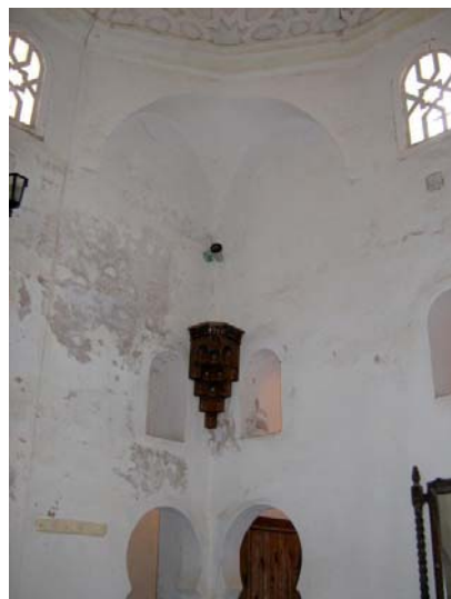
Photo. 4 : Elévation des latrines de la mosquée de Sīdī al-Ḥulwī (4/T/A). (© Bulle Tuil )
