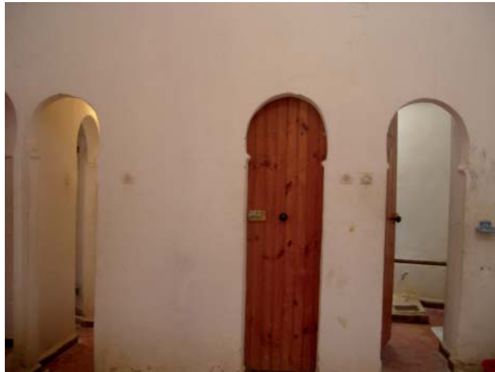
Photo. 1 : Cellules des latrines. (© Bulle Tuil )
