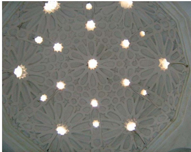
Photo. 1 : Coupole en stuc sculpté surmontant la salle centrale des latrines de la mosquée de Sīdī al-Ḥulwī (4/T/A). (© Bulle Tuil )
