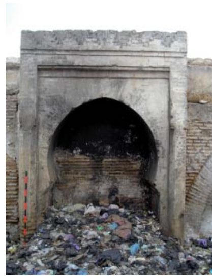
Photo. 3 : Niche surmontée d'une frise de merlons de la paroi Sud-ouest de la rawḍa d'Ibn 'Abbād (6/F/M). (© Bulle Tuil )
