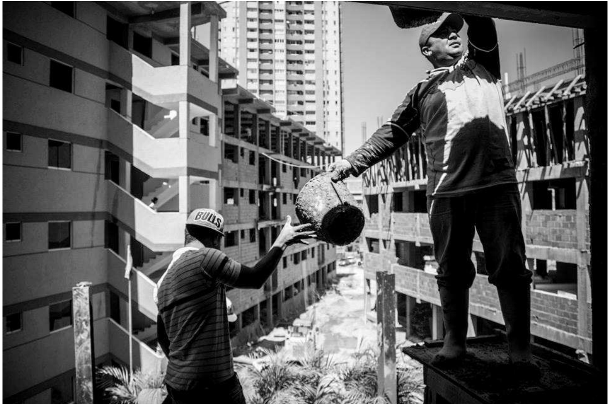
Figure 21 : Travail de construction au campement Kaika-Shi. 24 mars 2015. Crédit photo : Dikó 110
