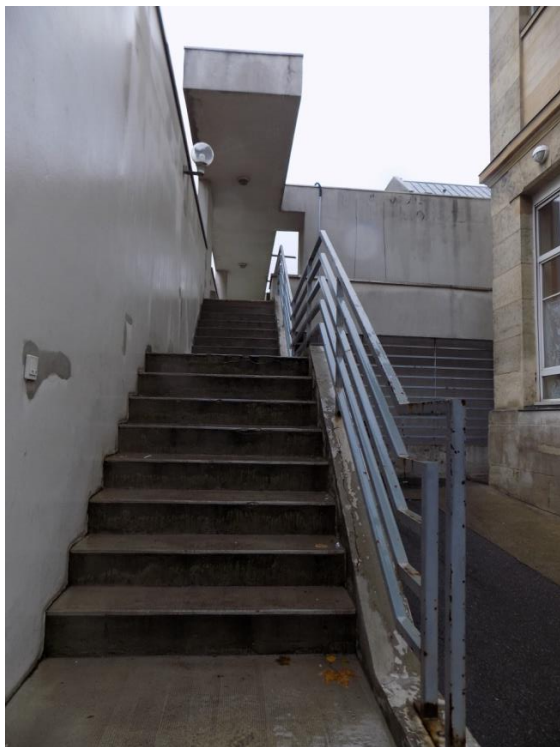
Extérieur du couloir-escalier, photographie, 1981-1985. Cliché Alice Agostini, janvier 2018.
