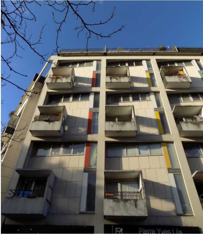
Figure 215 : immeuble entre la rue Charcot et la rue Chevaleret, Paris
