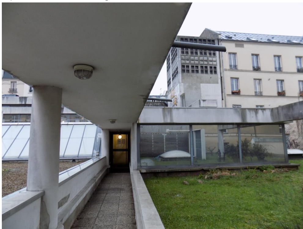
Toit-terrace, photographie, 1981-1985. Cliché Alice Agostini, janvier 2018.
