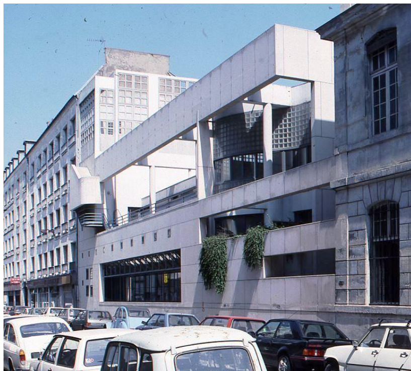
Figure 196 : cuisine de l'hôpital Saint-Antoine, Paris
