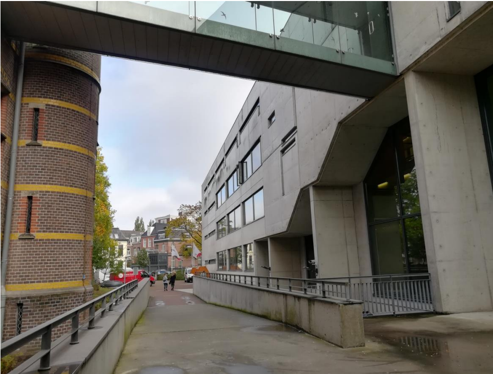
Vue de la façade d'entrée, photographie, 1996-2001. Cliché Alice Agostini, juin 2019.
