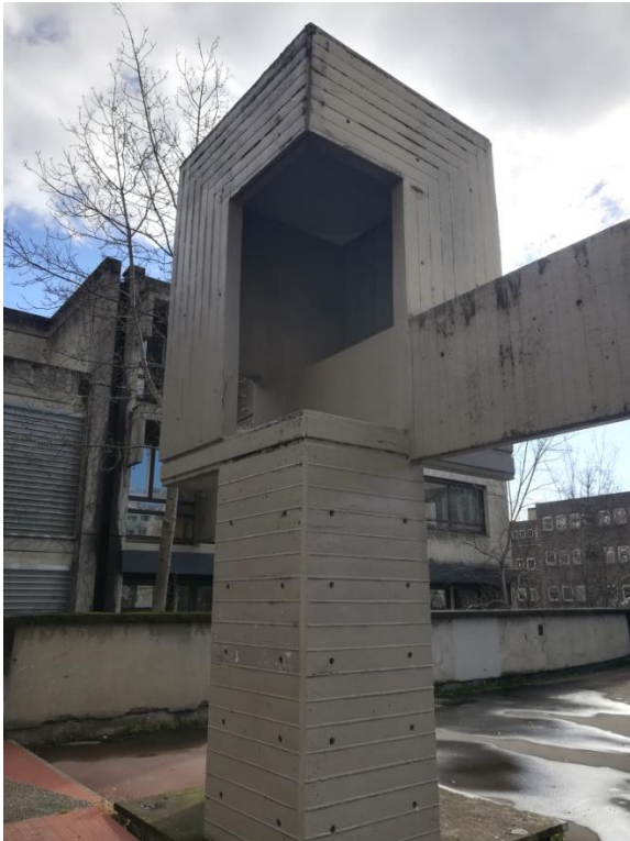
Détail d'un pilier à l'entrées du quartier, photographie, 1971-1976. Cliché Alice Agostini, mars 2020.
