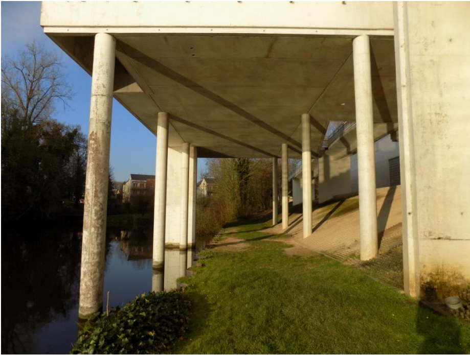
Détail des pilotis, photographie, 1987-1992.
