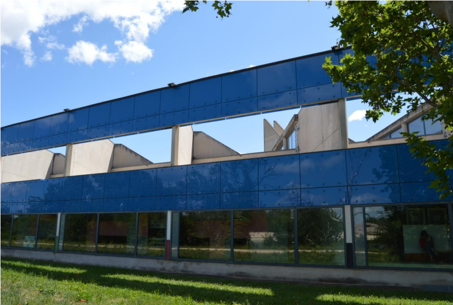
Vue depuis l'extérieur sur les sheds , aile d'exposition, photographie, 1983-1995. Cliché Alice Agostini, juin 2016.
