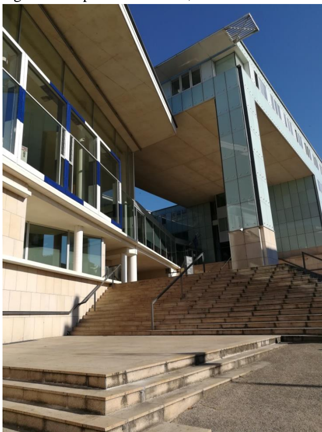
Portique d'entrée, vue de la salle des pas perdus depuis l'extérieur, photographie, 1997-2005. Cliché Alice Agostini, juillet 2020.
