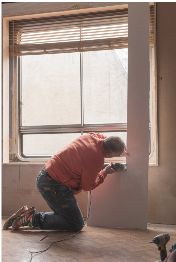
Pose de l'isolant phonique Fermacell © Sabine Serrad, 28 janvier 2020
