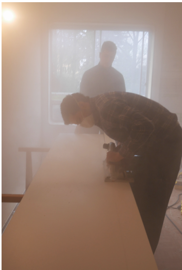
Pose des panneaux Knauf contrapanel © Mathilde Padilla, 25 janvier 2020
