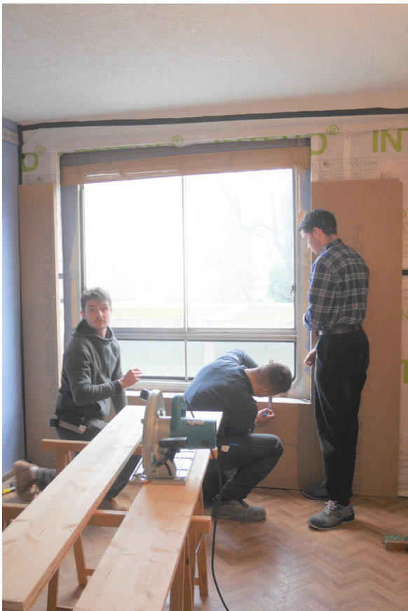
Pose de l'isolant thermique, une couche de 10 cm + frein vapeur + 4 cm © Mathilde Padilla, 25 janvier 2020
