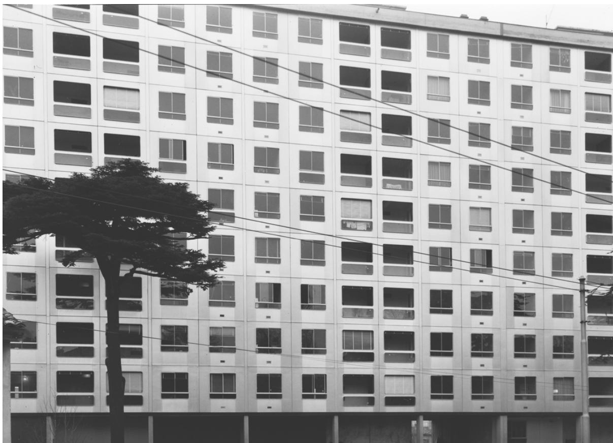
La façade sud de l'immeuble Les Cèdres à sa livraison © Centre Pompidou/MNAM-CCI/Bibliothèque Kandinsky
