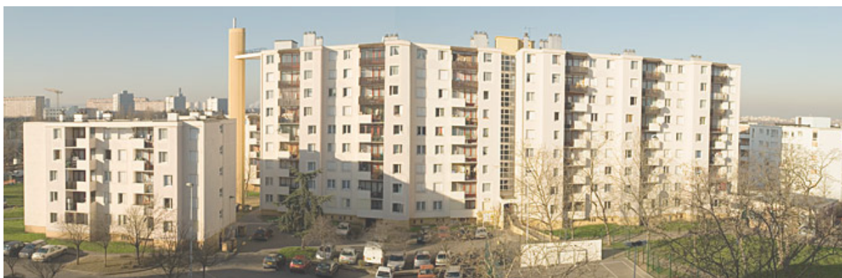
Cité des Paquerettes, Nanterre, Sebillotte, Darras, Kopp et Prouvé, 1961 - après rénovation © OPHLM de Nanterre, s.d.
