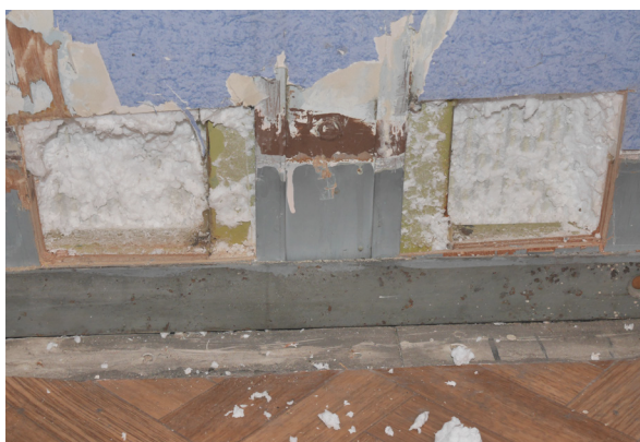
Assemblage vertical entre deux panneaux juxtaposés © Mathilde Padilla, 2019
