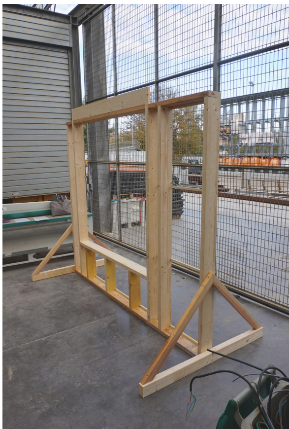
Ossature du prototype double façade © Eddy Giroux, Compagnons du Devoir, novembre 2019
