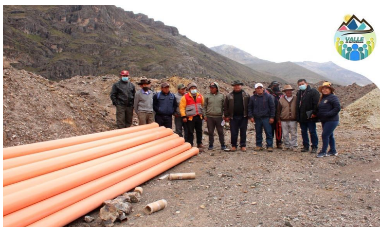
Photo 17 : Autorités de la Municipalité du district de Huanza et de la Communauté paysanne, membres de la communauté et matériel obtenu pour le détournement de l'eau
