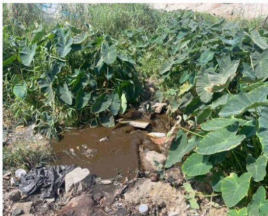
Photo 3 : Le canal d'irrigation reçoit les eaux usées
