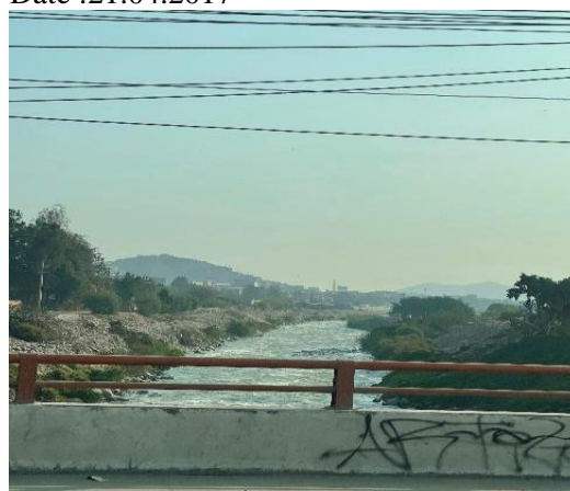
Photo 6 : Chosica, vue de la rivière Rímac depuis le pont Huachipa. Altitude : 380 m au-dessus du niveau de la mer. Date : 24.04.2022
