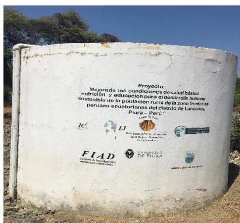
Photo 1 : Noria (puits) dans le hameau Suena el Agua
