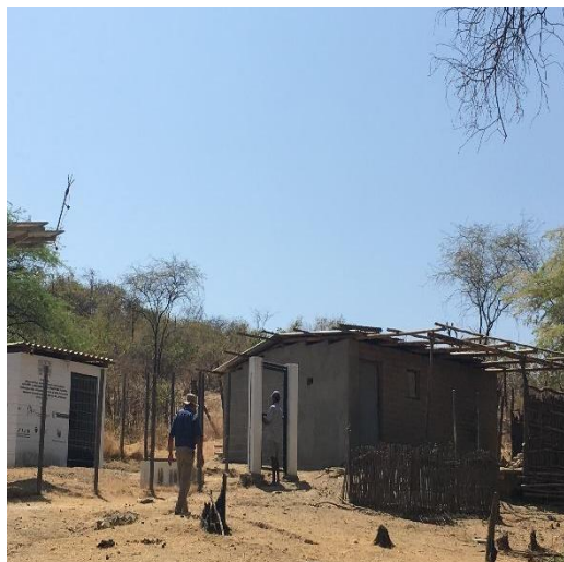
Photo 3 : Poste de contrôle de la JASS à Suena el Agua
