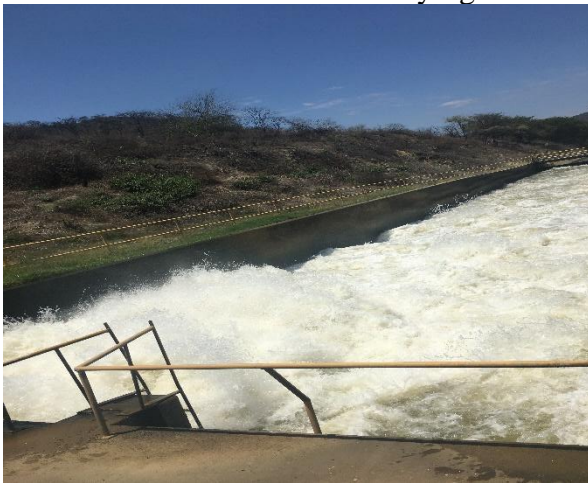
Photo 1 : Déversement des eaux du barrage de San Lorenzo dans le canal de Yuscay (altitude approximative de 235 m au-dessus du niveau de la mer). Date : 01.02.2018
