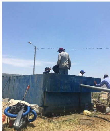
Photo 4 : Des membres de la JASS nettoient le réservoir dans le hameau Playas de Chilaco.
