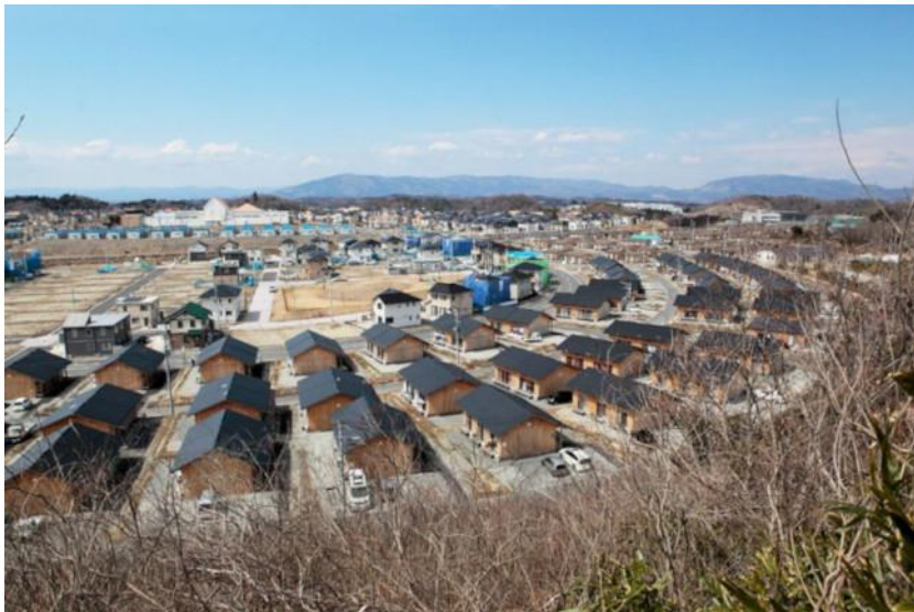
Figure 116. Les logements d'urgence en itakura à Iwaki : Ces logements constitués d'éléments massifs en sugi contribuèrent à la santé mentale des réfugiés. © Nihon itakura kenchiku kyōkai 91
