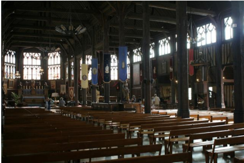
Figure 10. Église Sainte-Catherine de Honfleur : Cette église remplaça celle en pierre, détruite pendant la Guerre de Cent ans. Disposant de peu de moyens, les habitants de la ville utilisèrent le bois en provenance de la forêt de Touques et mirent à contribution leurs connaissances en construction navale. © Office de Tourisme de Honfleur 114
