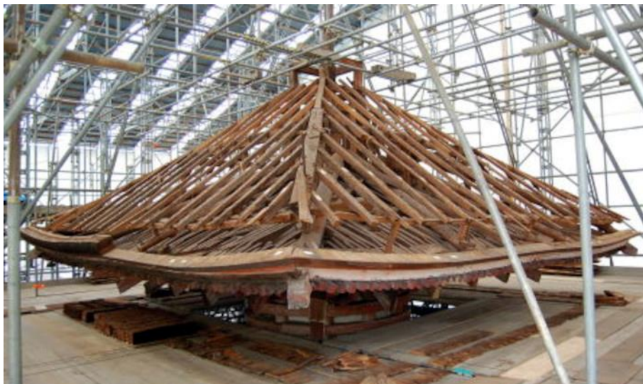
Figure 8. La réparation du tahôtô de Jison-in : En enlevant le toit, il est apparu que certaines pièces de bois s’étaient gravement déformées. Pendant les réparations, une construction temporaire appelée suyane (素屋根) fut érigée pour couvrir le bâtiment et le protéger. © Nishizawa kômuten 110
