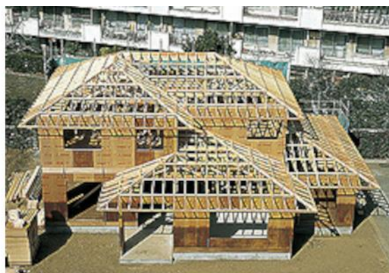
Figure 45. Le processus de construction d'une maison à ossature légère ( platform construction ) : Malgré sa haute productivité, l'ossature légère ne représente qu'environ 10 % de la totalité des constructions de maisons individuelles au Japon 93 . © Association 2x4 94
