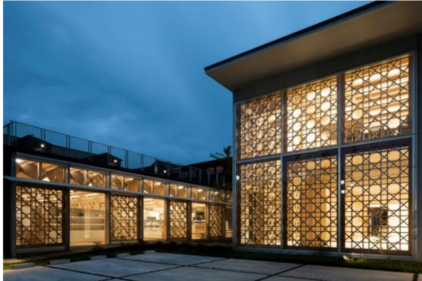
Figure 79. Chambre de commerce de Hannô (2020) : Le travail compétent des charpentiers locaux permet de réaliser la treille en bois minutieuse conçue par l'ingénieur Inayama Masahiko. © Nozawa Masamitsu kenchiku kôbô 153
