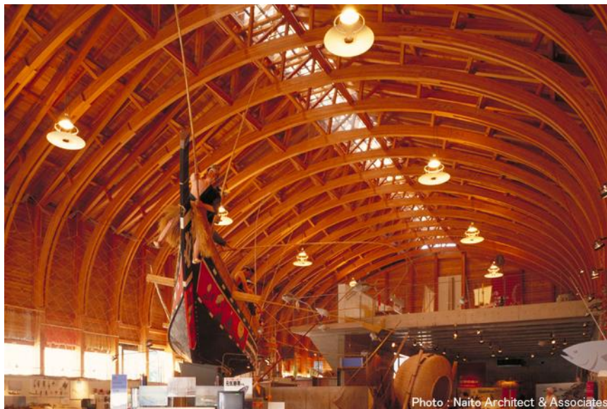
Figure 50. Musée de la Mer (1992) : Ce bâtiment est célèbre en tant qu'exemple de lamellé-collé de grande section, tirant sa force d'expression de la nature du matériau. © Naito Architect & Associates 173 .
