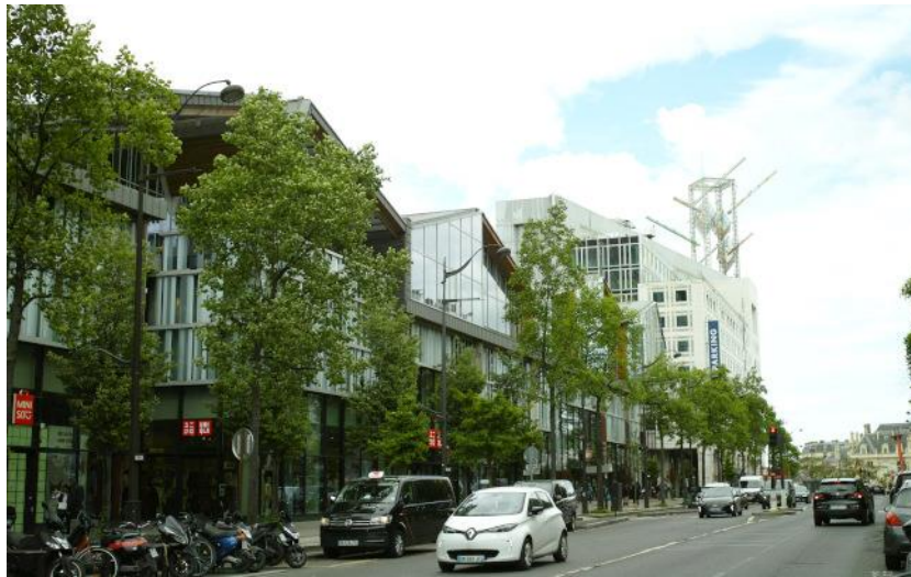
Figure 85. Italik : La structure en bois d'Italik apporte une touche végétale à l'avenue d'Italie, tout en respectant l'alignement des bâtiments minéraux datant des années 1960-70. © Oshima Yukiko, 2024.
