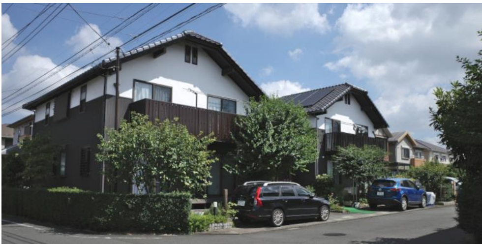
Figure 101. « Maisons à l'odeur de bois » : Ces maisons, s'inspirant de la tradition de la minka , portent un toit en tuile ; la partie supérieure des murs est recouverte de plâtre, tandis que la partie inférieure est revêtue de métal pour lutter contre l'humidité. © Oshima Yukiko, 2020
