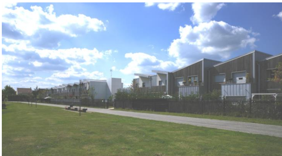
Figure 93. ÉcoQuartier du Sycomore : Sur un terrain intégrant différents types d'espaces verts, des logements en bois de différentes typologies sont construits. © Oshima Yukiko, 2022
