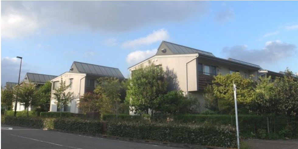
Figure 103. Vues extérieures d'un « domino en bois » : La chaleur solaire est recueillie à la surface du toit. Pour capter efficacement les rayons du soleil en hiver, une partie du toit est inclinée de manière aiguë. © Oshima Yukiko, 2018.
