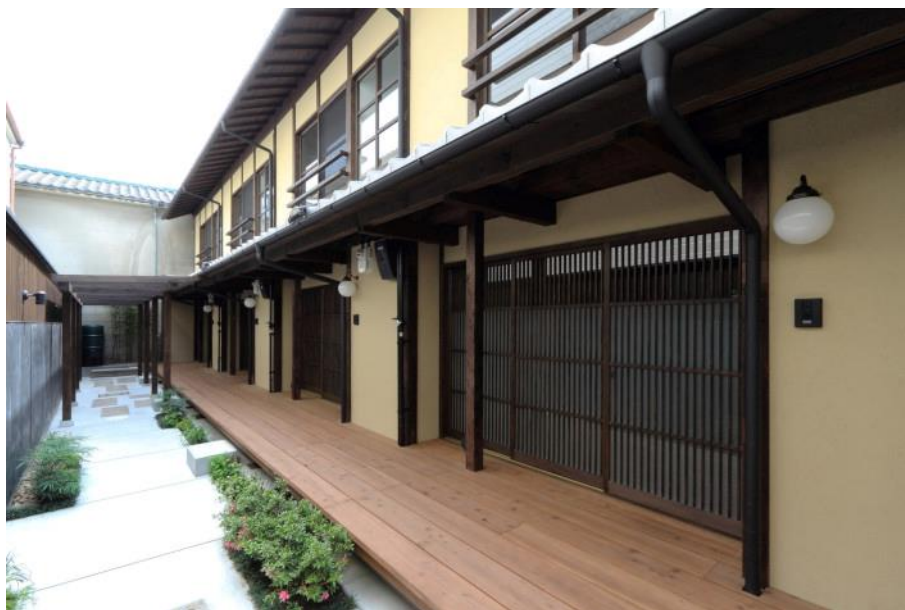
Figure 30. Groupe de machiya à Sarashiyachō (2016) : quatre machiya en face d'une roji ont été rénovées pour l'usage de mères et pères célibataires. © Uoya Shigenori 118
