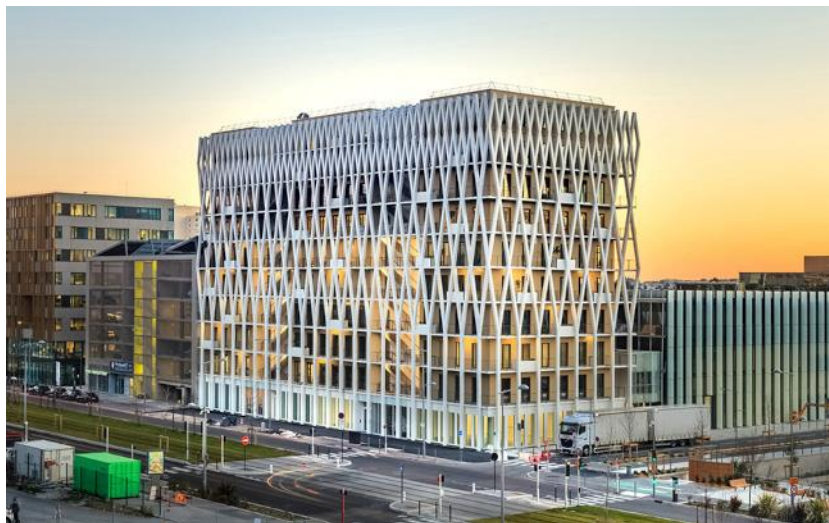
Figure 53. Palazzo Méridia de Nice (2019) : Réalisé à 100 % avec du bois français, cet immeuble de bureaux offre un environnement de travail de qualité, ce qui contribue à sa valeur économique 214 . © Antoine Duhamel Photography 215
