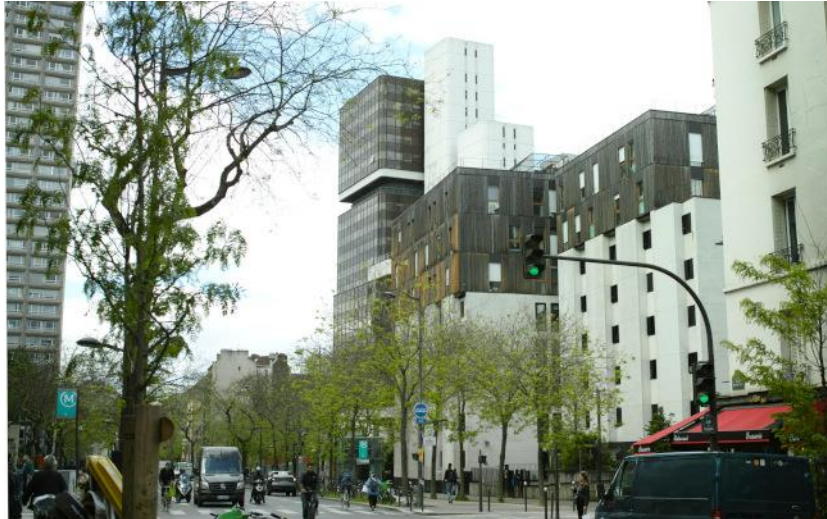
Figure 83. Surélévation du foyer de travailleurs migrants Coallia à Tolbiac : Dans un environnement minéral de Tolbiac, la surélévation revêtue de bois, posée sur un bâtiment blanc, se distingue. © Oshima Yukiko, 2024.
