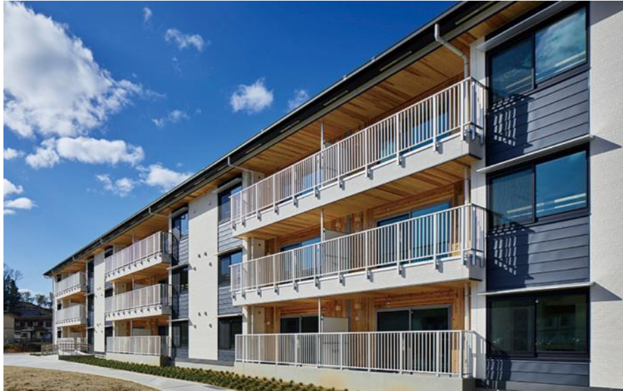
Figure 51. Logements publics pour la reconstruction après le séisme à Iwaki (2018) : Ces immeubles bénéficient de l'avantage du CLT, qui réside dans son utilisation répétitive pour les murs et les dalles ; cette approche n'est cependant pas généralement recherchée au Japon. © Shirai sekki (白井設計) 183
