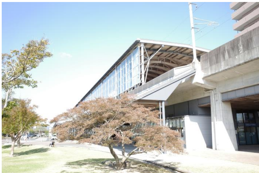
Figure 76. Gare de Hyūga-shi (2009) : Malgré sa faiblesse mécanique, le sugi de Miyazaki demeura l'élément central pour la construction de cette gare située le long d'une ligne ferroviaire aérienne. © Oshima Yukiko, 2023
