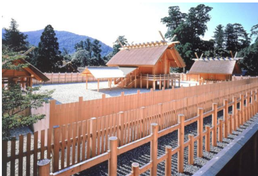
Figure 6. Le shōden de Naikû accompagné de ses autres pavillons et entouré de quatre enceintes de clôture : l'ensemble de ces constructions, qui est refait par le shikinen-sengû , est bâti selon le système hottate (le pied des poteaux est directement enterré) © Ise-Jingû
