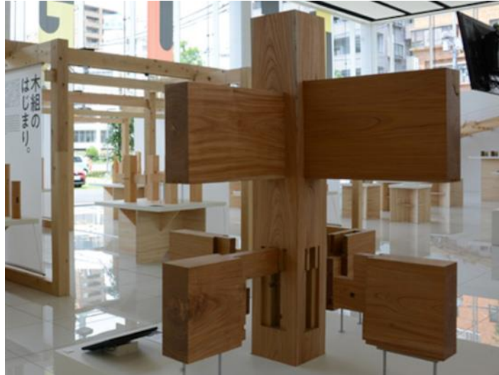
Figure 15. Shihôzashi : Quatre poutres arrivent à même hauteur sur un poteau, ce qui fait diminuer la section du poteau de cette hauteur et fragilise le poteau. Pour l'éviter, les poutres sont installées à différentes hauteurs, mais cette fois cela empêche la transmission des efforts et déstabilise la structure. © Takenaka daiku dôgukan 174
