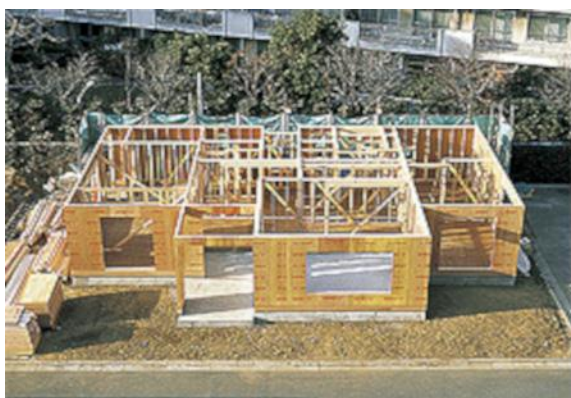
Figure 45. Le processus de construction d'une maison à ossature légère ( platform construction ) : Malgré sa haute productivité, l'ossature légère ne représente qu'environ 10 % de la totalité des constructions de maisons individuelles au Japon 93 . © Association 2x4 94
