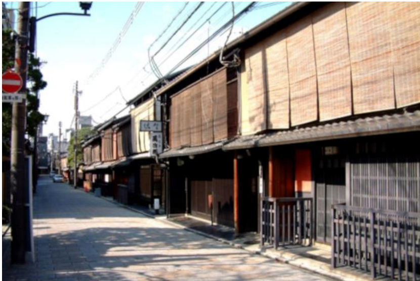
Figure 22. Façade de machiya (Gion shinbashi-dôri 祇園新橋通) : la continuité des façades de machiya avec kôshi et tôrihisashi constitue la scénographie d'un quartier historique. © Gion shôtengai shinkô kumiai 33
