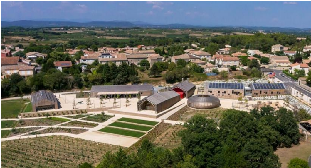
Figure 80. Pôle œnotouristique Viavino (2014) : Pour la construction de ce pôle d'une programmation complexe autour du vin, l'utilisation du bois joue un rôle essentiel. © Atelier Philippe Madec 157
