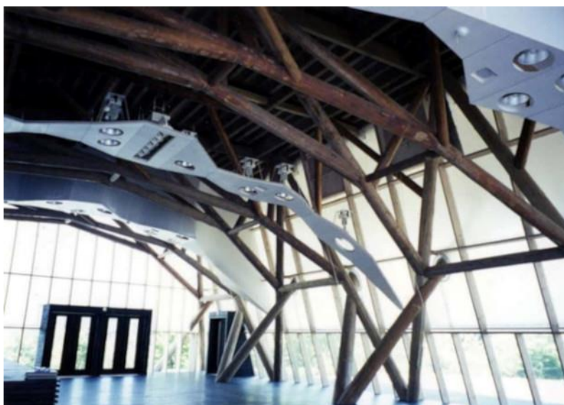
Figure 74. Académie des sciences et de la culture forestières de Gifu (2001) : Les troncs bruts sont combinés directement selon la méthode traditionnelle du hikaritsuke , qui permet d'assembler des éléments de forme irrégulière. © Holzstr 116
