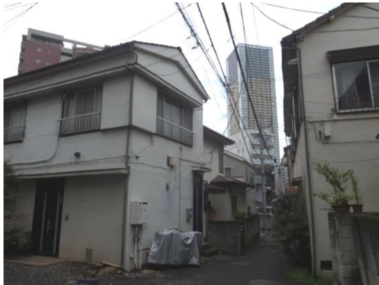
Figure 87. L'Owl Tower derrière de petites maisons en bois dans le mokumitsu à Ikebukuro : Pour remplacer de petites maisons en bois, cette tour de 52 étages fut construite. © Oshima Yukiko, 2018
