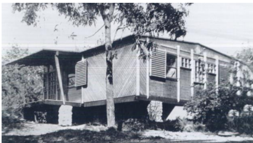
Figure 42. Maison démontable pour le Bureau Central de Construction (1941) : Pour ces maisons construites à Grenoble, les portiques étaient aussi en bois (photo présentée dans Jean Prouvé : architecte des jours meilleurs ) 67 .
