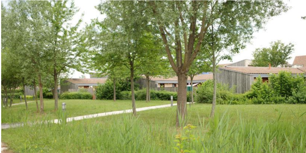
Figure 105. 60 logements sociaux en bois (2012) : Les logements individuels, avec leur revêtement en bois et leur traitement paysager, créent un espace distinct de celui des maisons pavillonnaires environnantes. © Oshima Yukiko, 2022
