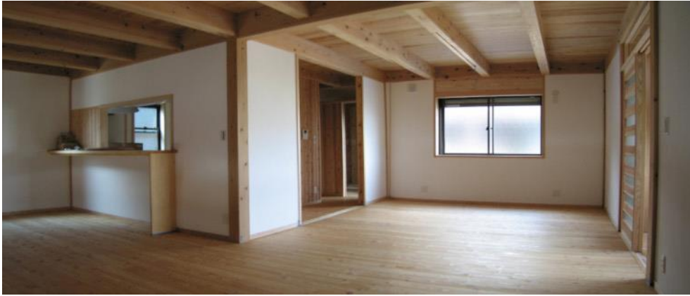
Figure 100. « Maison à l'odeur de bois » (2007) : La structure en bois apparente, montée de manière traditionnelle, détermine le caractère de l'espace. Les acheteurs de ces maisons acceptèrent l'éventuelle apparition de fissures sur les éléments en bois. © Gendai keikaku kenkyûjo 130
