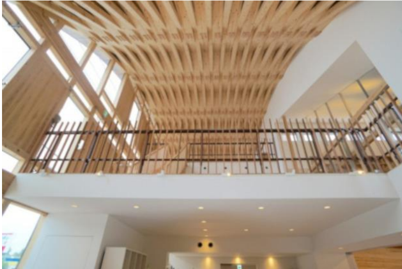
Figure 114. Succursale Saitama-kita d'Aqura Home 82 (2016) : Cet espace de 6×16 mètres, d'une hauteur de 9 mètres, fut réalisé par des éléments en bois standardisés grâce aux informations fournies par l'Association de la technique du pre-cut pour des bâtiments en bois de moyennes et grandes dimensions. © Stroog 83
