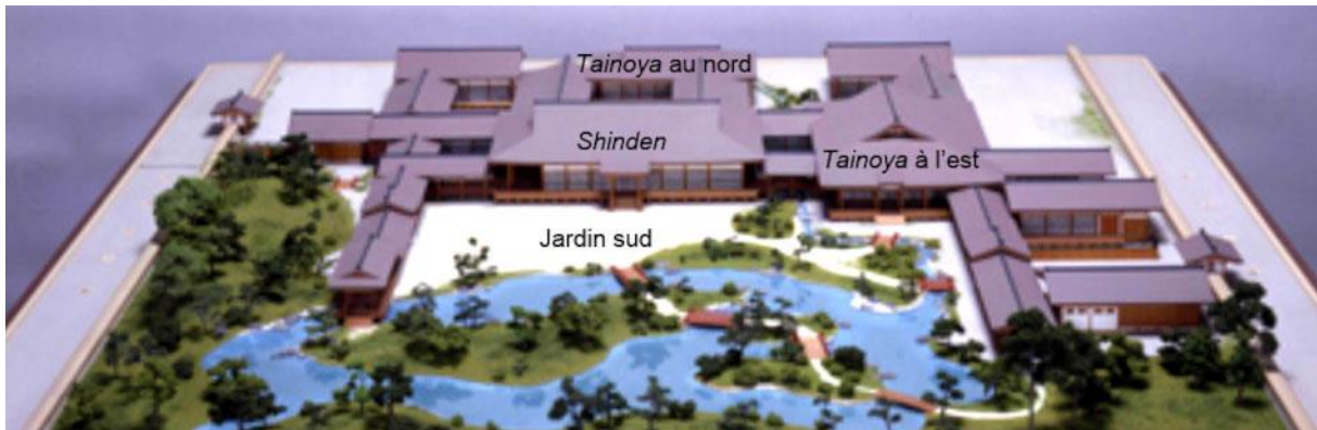
Figure 18. Composition du shinden-zukuri (maquette de Higashisanjōdono) : les bâtiments conservaient une certaine indépendance les uns par rapport aux autres. Cette composition favorisait un contact riche avec l'extérieur. © Kyōto bunka hakubutsukan 10 (les indications sont ajoutées par Oshima Yukiko)
