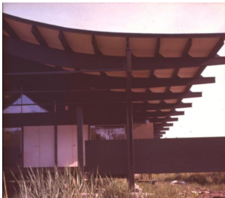
Figure 49. Centre de l'environnement au Teich : Construit sur les bords du Bassin d'Arcachon dans un Parc Naturel, le choix du lamellé-collé fait partie des considérations environnementales. © Pierre Lajus 160
