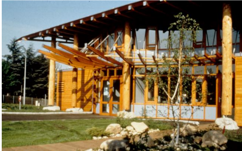
Figure 119. Institut de Résonance Magnétique : La structure en tronc de bois, qui permet de réaliser des images radiographiques de bonne qualité, contribue également à apaiser les patients confrontés à une situation de stress. © Jacques Anglade 134
