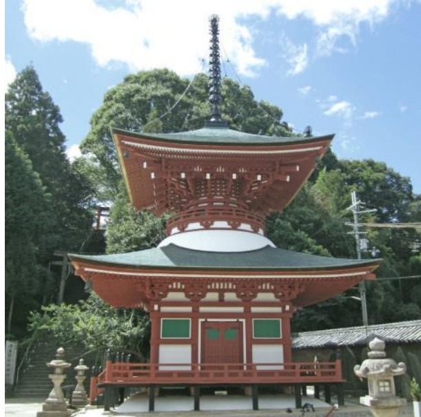
Figure 9. La tahôtô de Jiso-in après réparation : Le tahôtô est une pagode à deux niveaux : le plan de la base forme un carré, tandis que celui de l'étage supérieur est circulaire. Le tahôtô de Jison-in est classé comme bien culturel départemental, dans la préfecture de Wakayama. © Nishizawa kômuten 112
