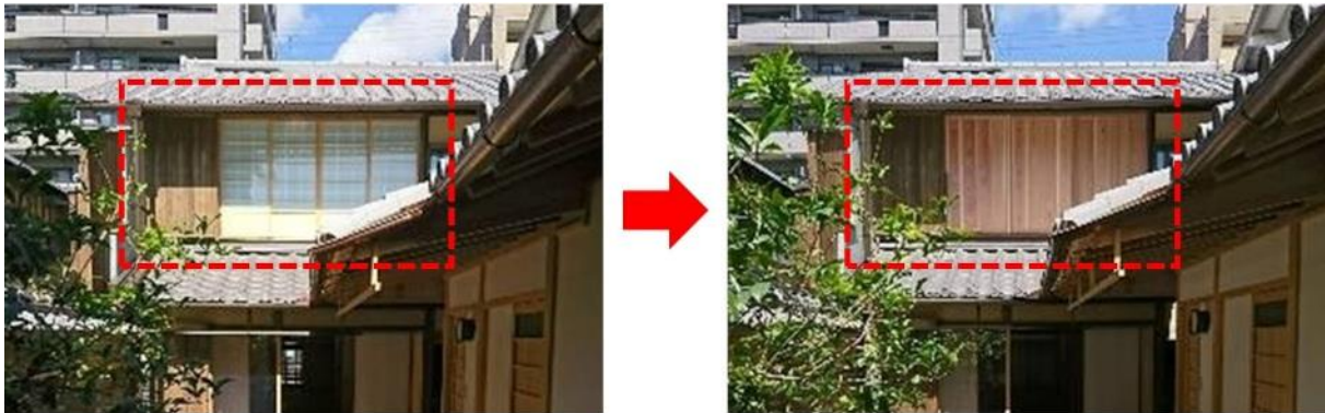
Figure 32. Le volet coupe-feu en bois : En utilisant des planches en bois d'une épaisseur de 30 millimètres, ce volet résiste au feu pendant 30 minutes. © Ville de Kyôto 145
