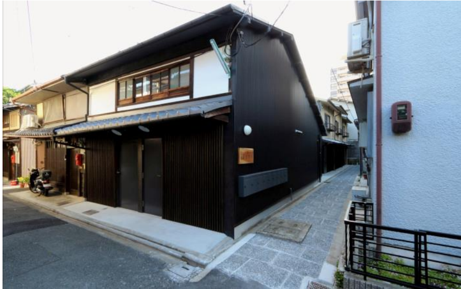
Figure 31. Logement en colocation à Jûyonkenchô (2014) © Uoya Shigenori 121
