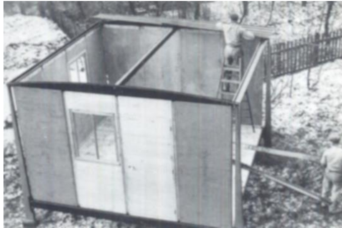
Figure 41. Baraque démontable militaire (1939) : Jean Prouvé conçut plusieurs systèmes de logements préfabriqués utilisant le bois (photo présentée dans Jean Prouvé : œuvre complète. Volume 2, 1934-1944 ) 64 .
