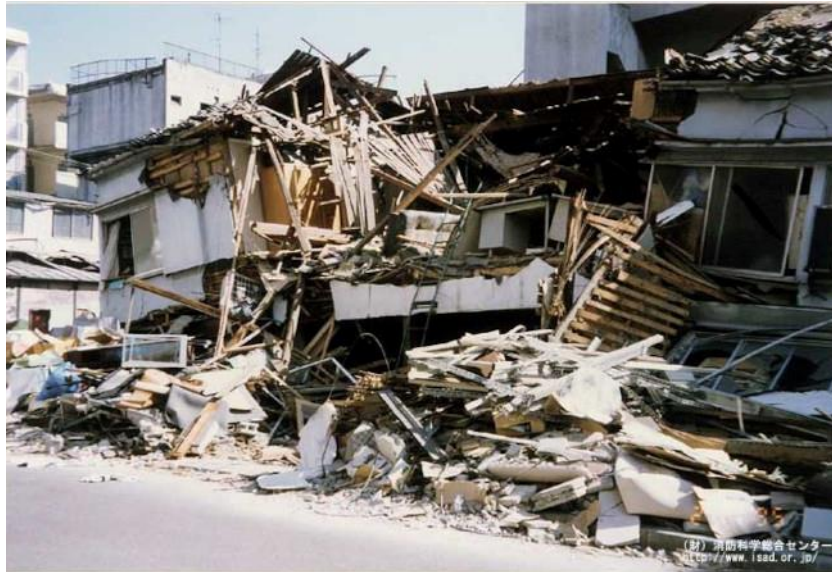
Figure 52. Des maisons en bois détruites par le séisme de Kôbe (1995) : Cette catastrophe, qui entraîna d'importants dégâts, donna l'occasion de réviser l'architecture au Japon. © Centre de science de la sécurité incendie 197
