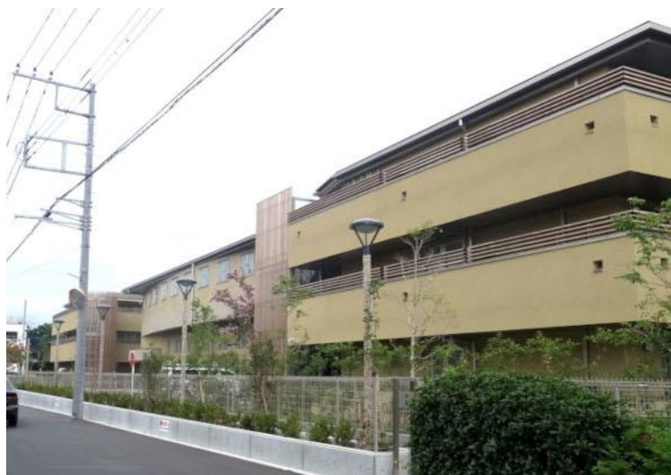
Figure 88. Hidamari no sato Kiyose (2017) : Bien que traditionnellement ce type de bâtiment soit construit en béton armé, la tendance à encourager la construction en bois permet la réalisation du projet. © Oshima Yukiko, 2017
