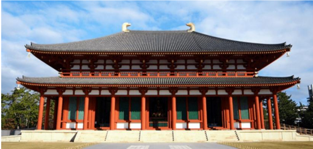
Figure 7. Le Chûkondô du Kôfuku-ji : Selon des recherches archéologiques et historiques, le bâtiment d'origine du VIII e siècle, d'une surface de 36,6 mètres sur 23 mètres et d'une hauteur de 21,2 mètres, fut reconstruit. © Kôfuku-ji 97
