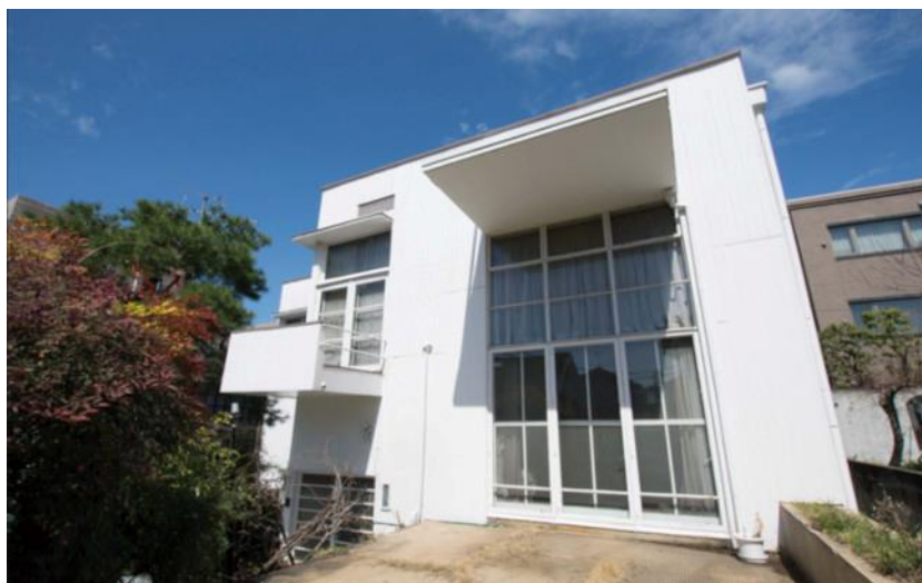
Figure 39. Maison de Tsuchiura Kameki (1935) : Cette maison constitue un rare témoignage existant du mouvement de Trockenbau au Japon. © Fugo Hitoshi 晋後均 43
