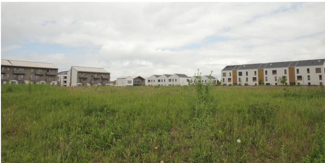
Figure 98. ZAC du Chêne-Saint-Fiacre : Des immeubles de R+1 et R+2 construits en bois destinés à des logements collectifs constituent l'élément principal de cette zone. © Oshima Yukiko, 2022
