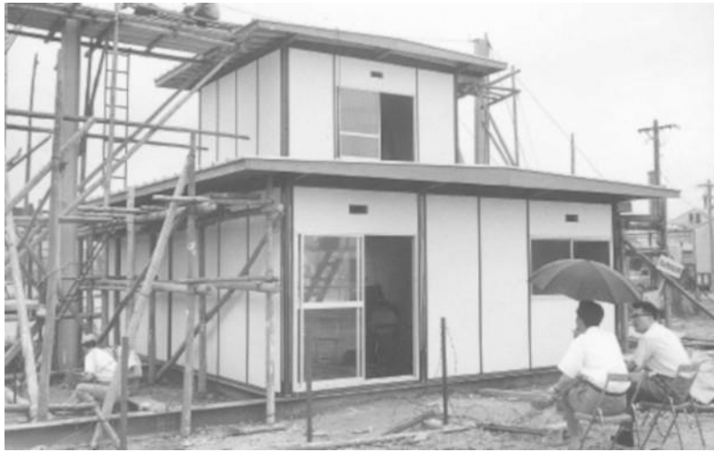
Figure 44. Logement type R2N National ナショナル住宅 R2N 型 (1965) : Mis en vente par Matsushita denkô, actuel Panasonic, il constitue le premier modèle de maison préfabriquée au Japon à deux étages. © PanaHome Corporation 85
