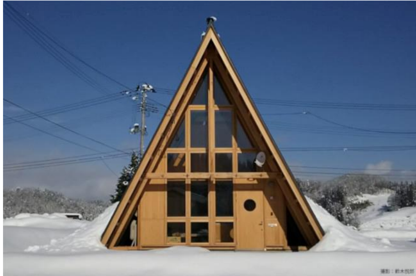
Figure 71. Yukimakura (2017) : Afin de soulager les habitants du travail pénible de déneigement, Seno Kazuhiro opta pour une forme de toiture pointue pour ce logement public à Yamagata. © Seno Kazuhiro 103
