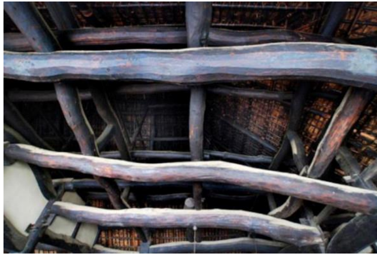
Figure 21. Des poutres d'une minka , maison Nakayama : des pièces de bois tordues furent combinées de manière à augmenter la solidité en fonction de la sécheresse du bois, ce qui fut rendu possible grâce à la grande compétence des charpentiers. © Kankô Ibaraki 30
