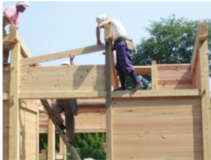
Figure 115. Chantier en itakura : La simplicité de cette méthode permet la réversibilité, autorisant le démontage et le remontage, ce qui rend les matériaux réutilisables. © Nihon itakura kenchiku kyôkai 89
