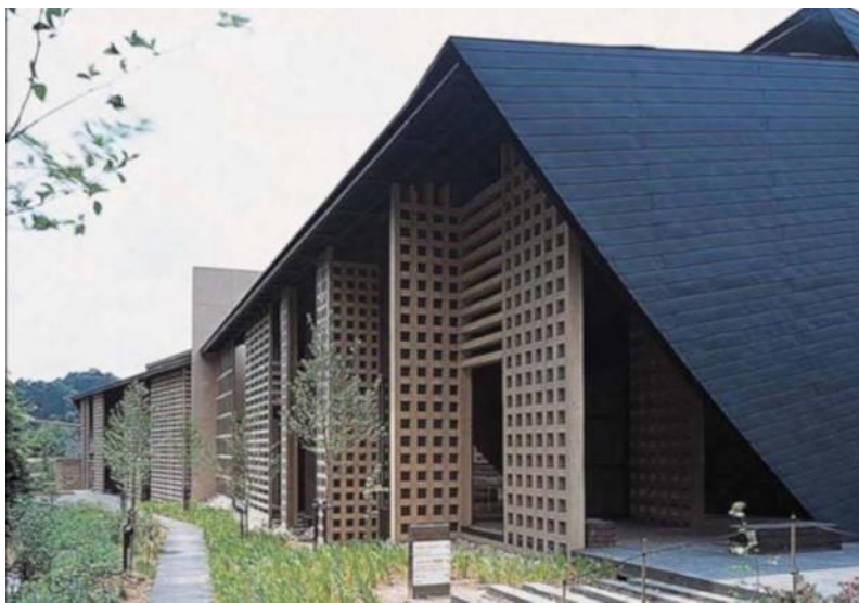
Figure 73. Académie des sciences et de la culture forestières de Gifu (2001) : Les treillis en bois, fabriqués avec des bois de petite taille, jouent un rôle déterminant dans l'apparence visuelle des bâtiments. © Holzstr 113
