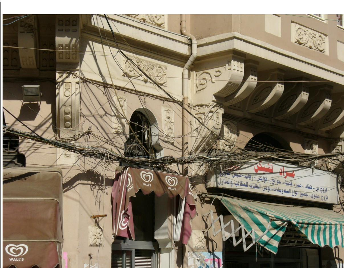
Figure 1 : Enchevêtrements de fils électriques de générateurs à Beyrouth © E. Verdeil
