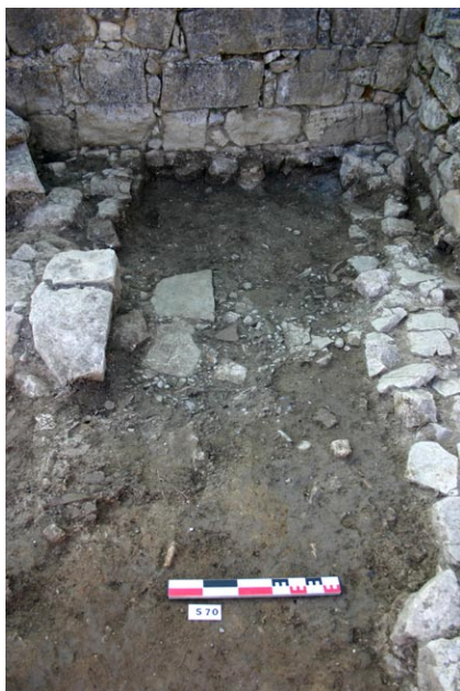
Fig. 63 : Vue depuis le nord de la ruelle nord-sud passant sous le rempart MR71007, après fouille du radier de moellons 75069 servant de nivellement avant la construction du rempart
