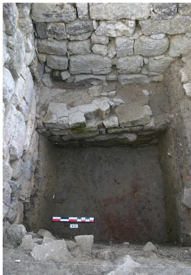
Fig. 14 : Le mur MR71026 par rapport aux murs MR71012 et MR71013, vu de l'est
