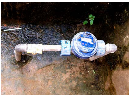
Figure 8: Installation d'un compteur individuel dans le favela Prado Lopez (Photo MS2005)
