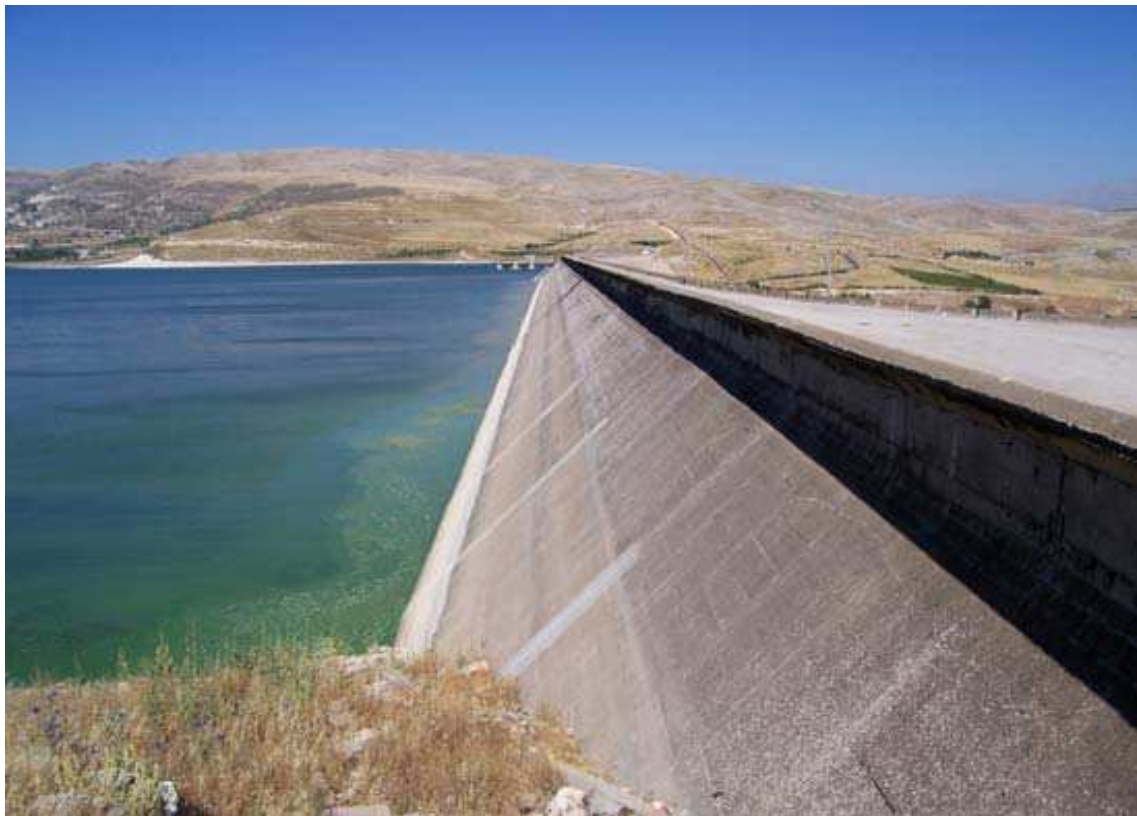
Photo 2 : Un exemple de barrage : le barrage de Qaraoun, Beqaa (Liban).
