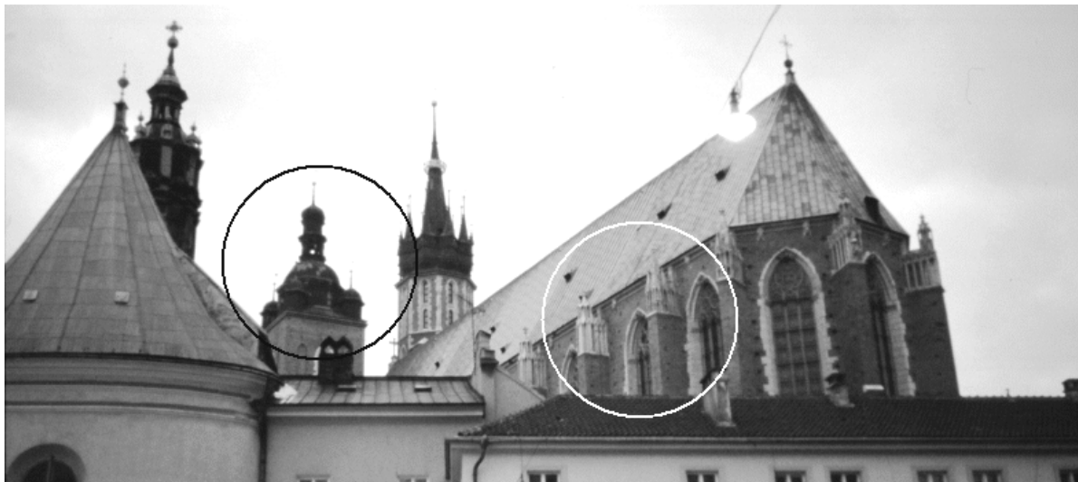
Figure 3 : Un édifice placé sous l'étiquette « église basilicale gothique » par Z.Dmochowski (1956). On observe cerclés sur l'image l'absence d'arc boutant (blanc), dispositif constructif pourtant éminemment gothique, et la présence d'un dôme baroque sur la tour sud (noir). [Kościół Mariacki, Cracovie, phot. J.Y.Blaise, 2004 ]
