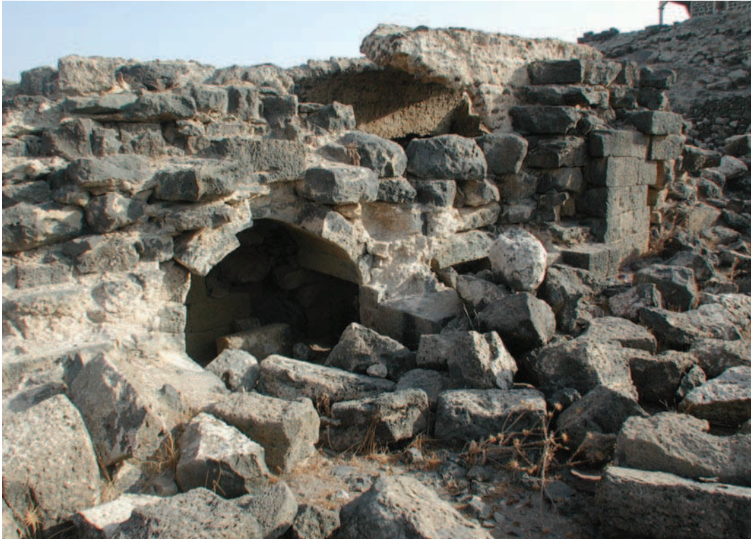
Fig. 15 façade intérieure nord de A, au centre la voûte clavée du vestibule B, avant la fouille.
