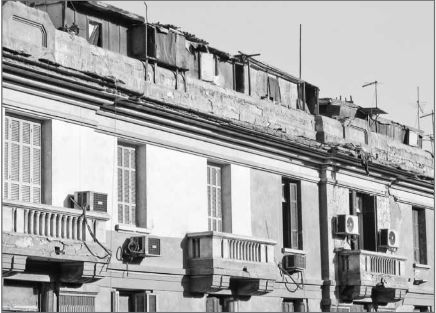
13. Habitations surnuméraires (forme de squats) sur le toit d'un immeuble de la rue al-Fadl, Centre-Ville, Le Caire, 6 octobre 2004 (16h01).
