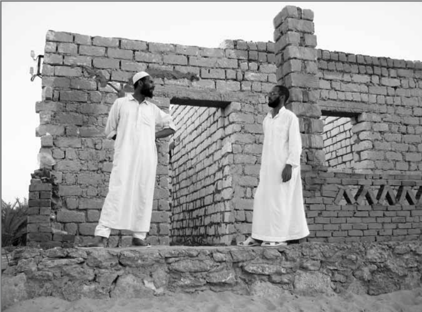
20. Propriétaire et voisin discutant des travaux devant une maison en cours de construction, en moellon calcaire, quartier Ramel, Siwa, 3 juin 2005 (20h10).
