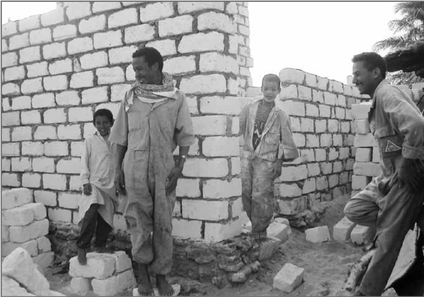
9. Jeune équipe de maçons (occasionnels), aidant à la construction d'une extension en moellon d'une vieille habitation, Aghurmi, Siwa, 10 janvier 2004 (15h39).
