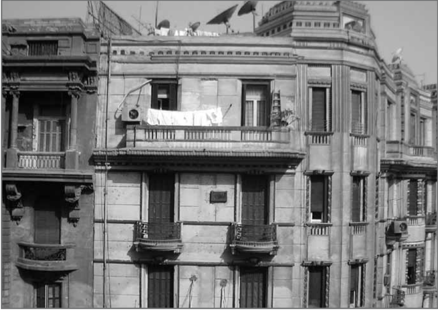
11. Immeuble de la rue Talaat Harb, dont beaucoup des appartements sont vacants, Centre-Ville, Le Caire, 19 juin 2004 (9h16).
