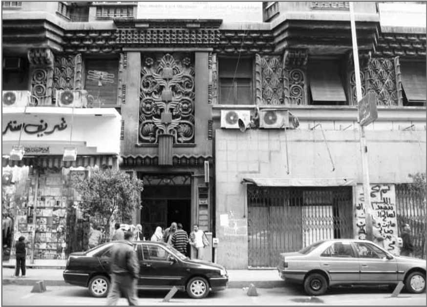
23. Détail d'architecture d'un immeuble khédivial et ajouts des commerces, rue Sherif, Centre-Ville, Le Caire, 15 février 2007 (16h36).
