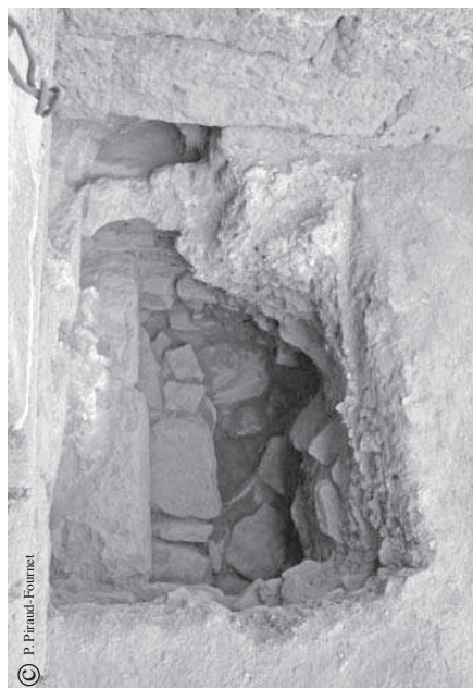
Fig. 18 Sondage dans l'angle sud-ouest de la cour du Palais de Trajan. Tranchée de fondation du bâtiment sud et de la cage d'escalier, perturbée par l'installation d'une canalisation longeant la façade sud. Photo P. Piraud-Fournet.
