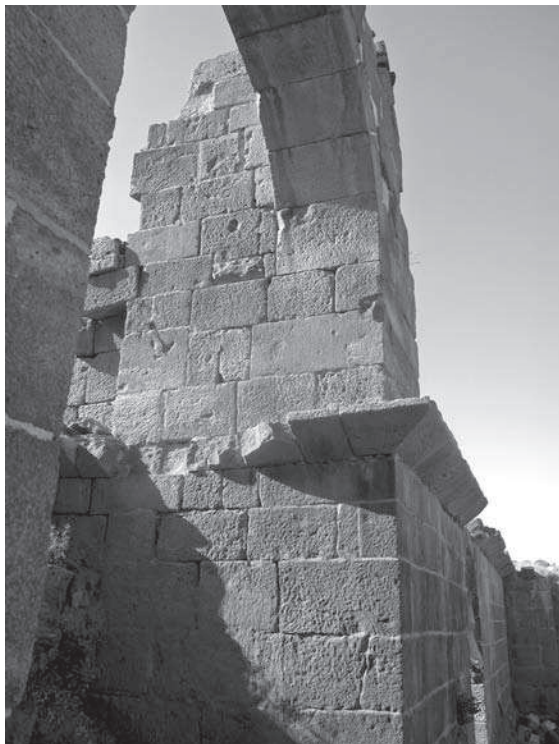
Les thermes du Centre : emplacement de la chaudière du caldarium nord-ouest (salle 10).
