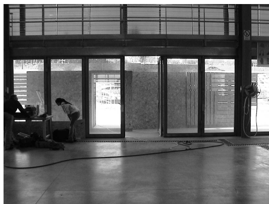
Vue du dedans, la trame existante scande le dispositif, face « lisse » de la coulisse côté bâtiment
