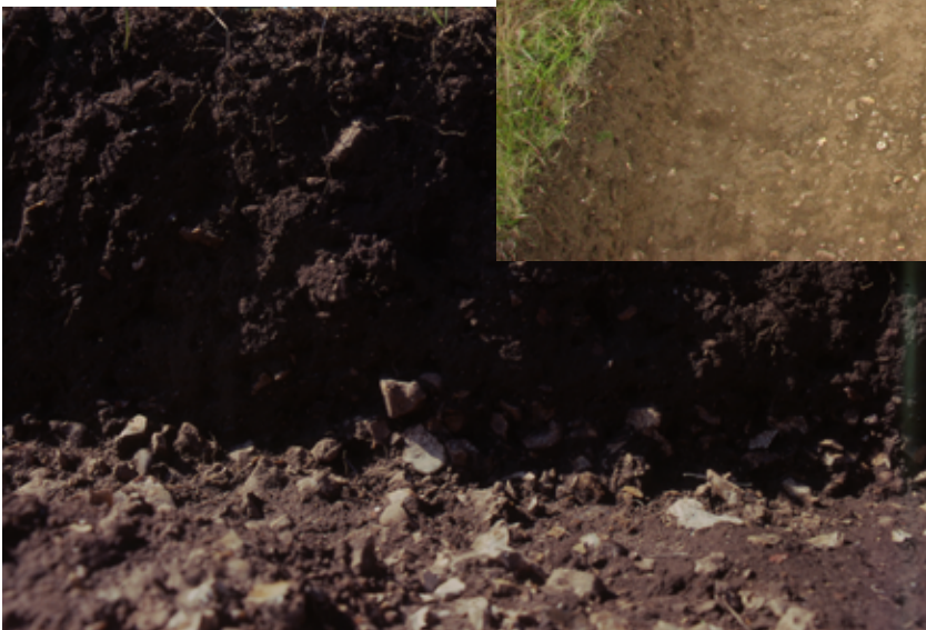
Fig. 46b – Sondage A, secteur 1 : couche de cailloutis A-1060, entamée par la pelle, contre la berme ouest (phot. V. Chevrier, 2007).
