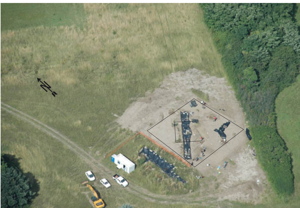
Fig. 10 – Vue aérienne du site (phot. Alain Lelong, juillet 2008).
